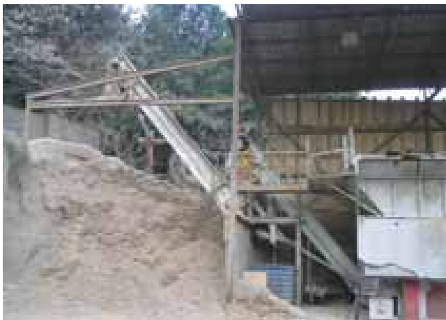
Proceso de trituración de la madera.
