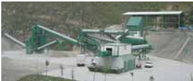
Instalazioen irudi orokorra.
