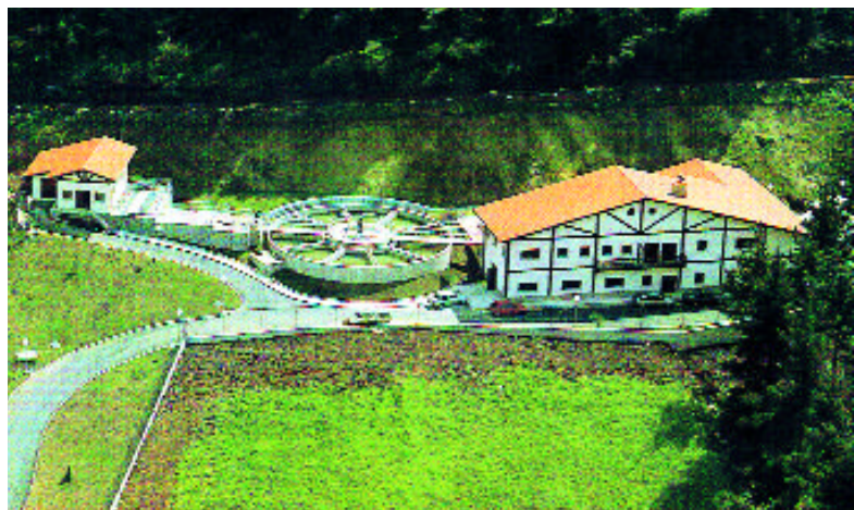
Estación de Tratamiento de Aguas Potables. Ur edangarri tratamendu Hornitegia.
