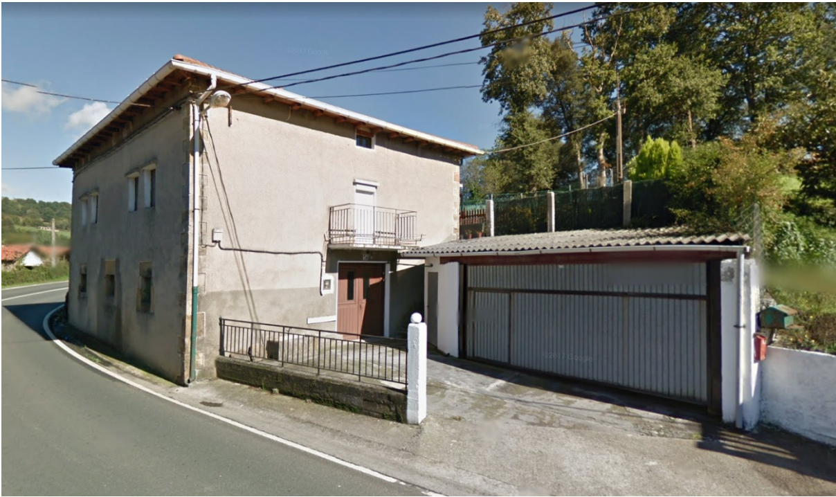
Ilustración 88: Casa nº 16 de El Peso que será derruida.
