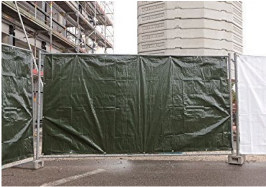
Ilustración 94: Valla de obra con malla verde y bases de hormigón.
