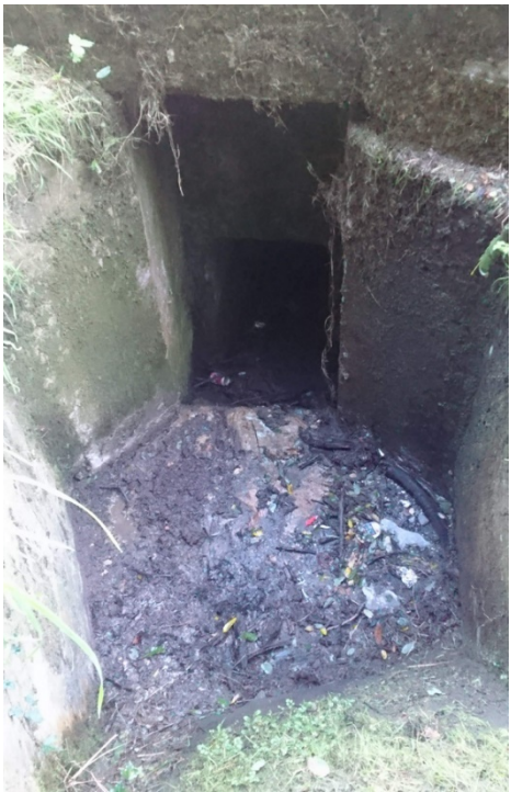
Ilustración nº18: Arroyo intermitente PK 4+090 BI-630
