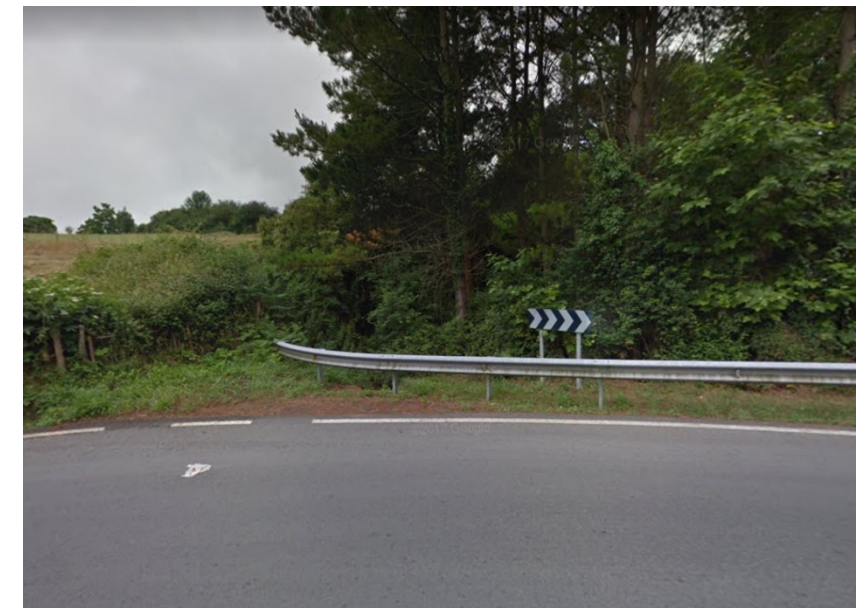
Ilustración nº15: Arroyo Intermitente PK 2+240 BI-630
