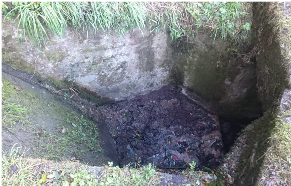
Ilustración nº19: Arroyo intermitente PK 4+090 BI-630
