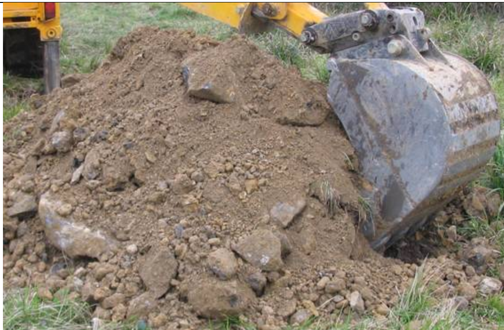
Detalle del acopio de materiales extraídos en la calicata C-6.
