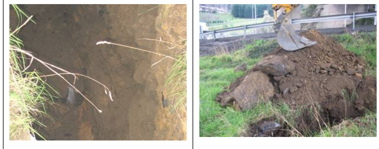
Vistas en detalles de las paredes de excavación y de los materiales de acopio de la calicata C-4-1
