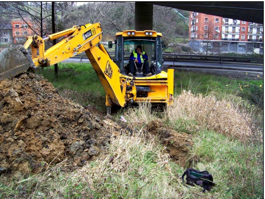
FOTO DE SITUACION
