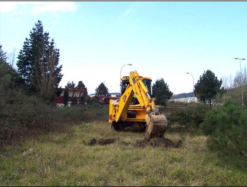
FOTO DE SITUACION
