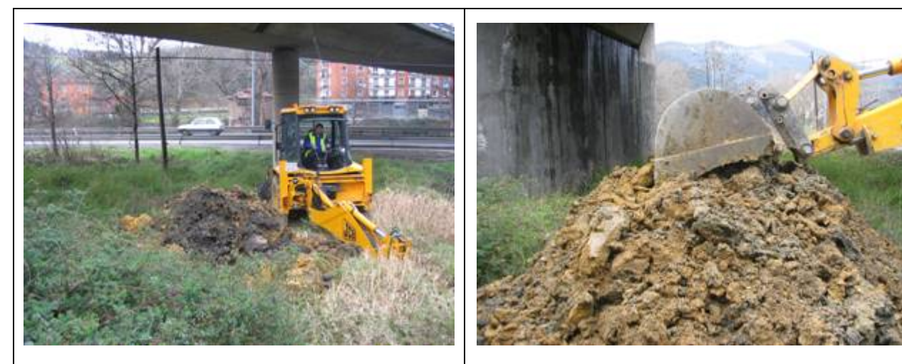
Vista general del emplazamiento de la calicata C-5 y de los materiales extraídos
