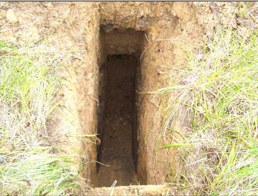
FOTO DE LA CALICATA
