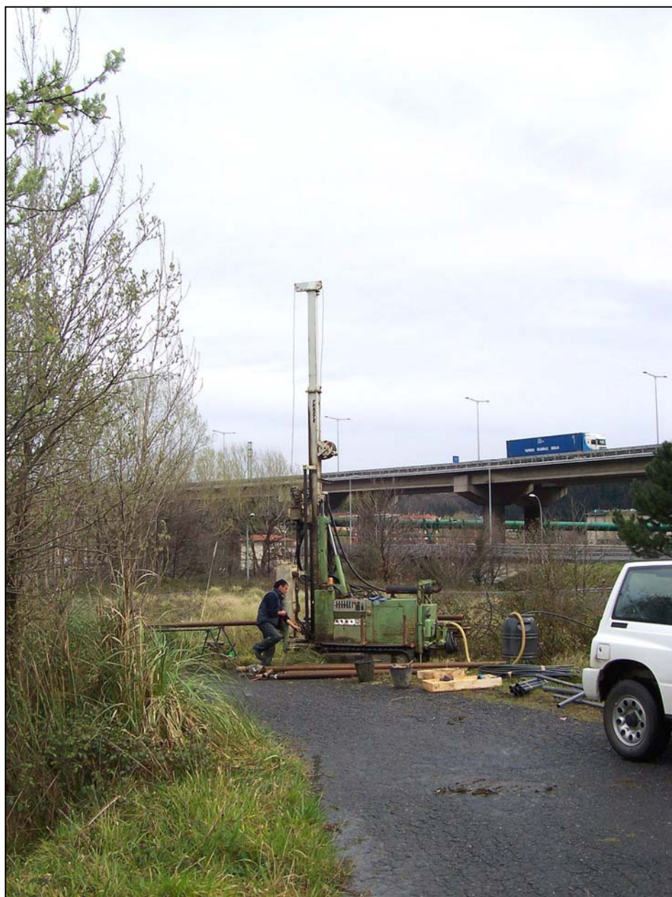
FOTO DE SITUACION
