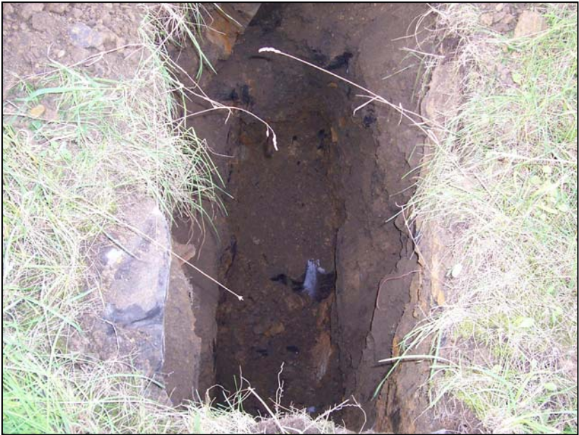
FOTO DE LA CALICATA
