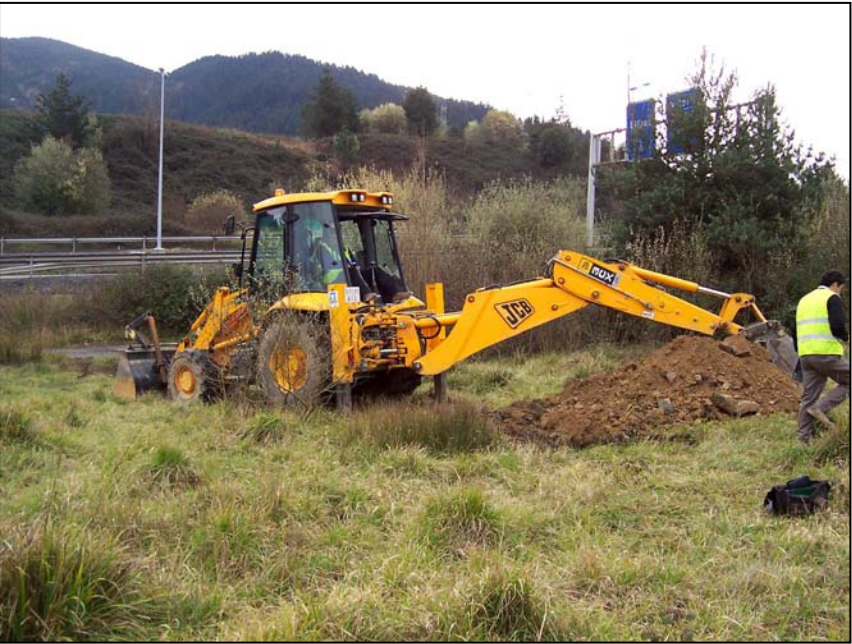
FOTO DE SITUACION
