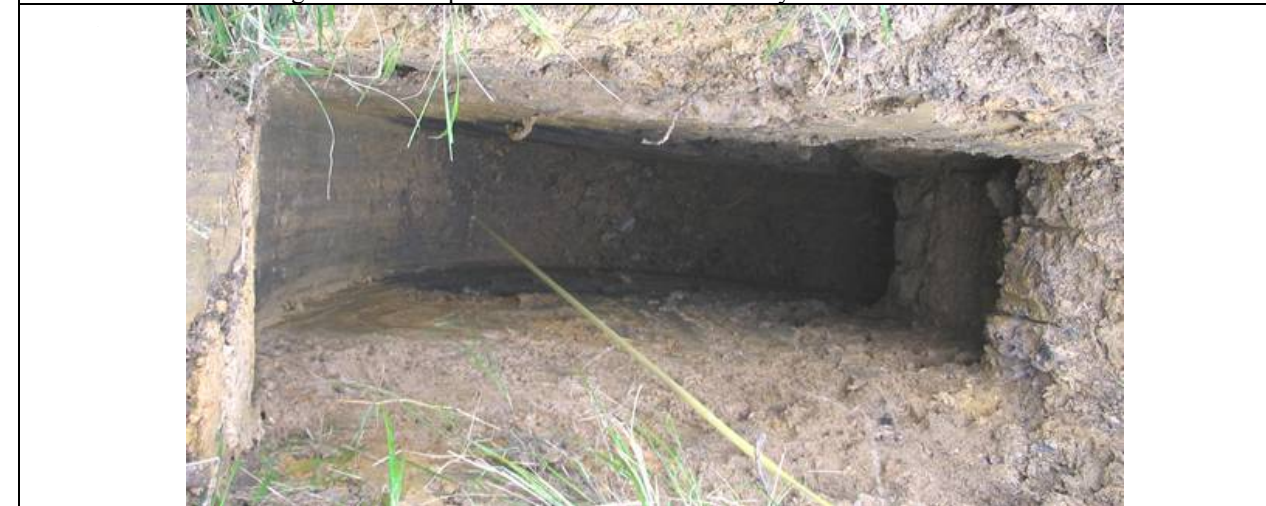
Detalle de las paredes de excavación de la calicata C-5
