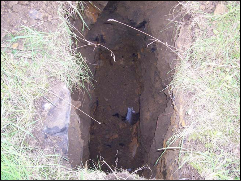
FOTO DE LA CALICATA
