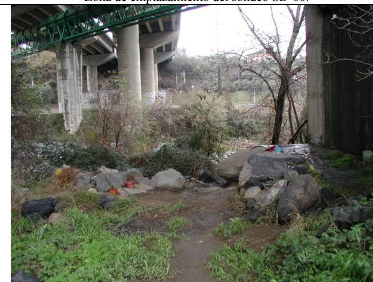
Zona de emplazamiento del sondeo SD-07.
