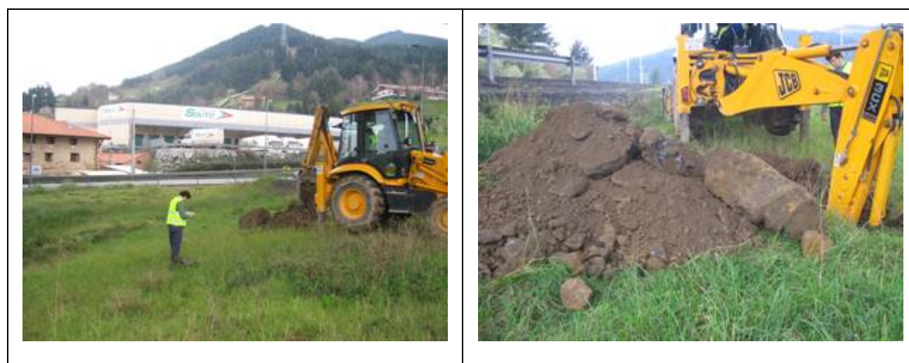
Vista general del emplazamiento y detalle de las labores de excavación de la calicata C-4-1.
