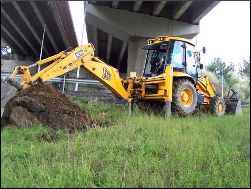
FOTO DE SITUACION
