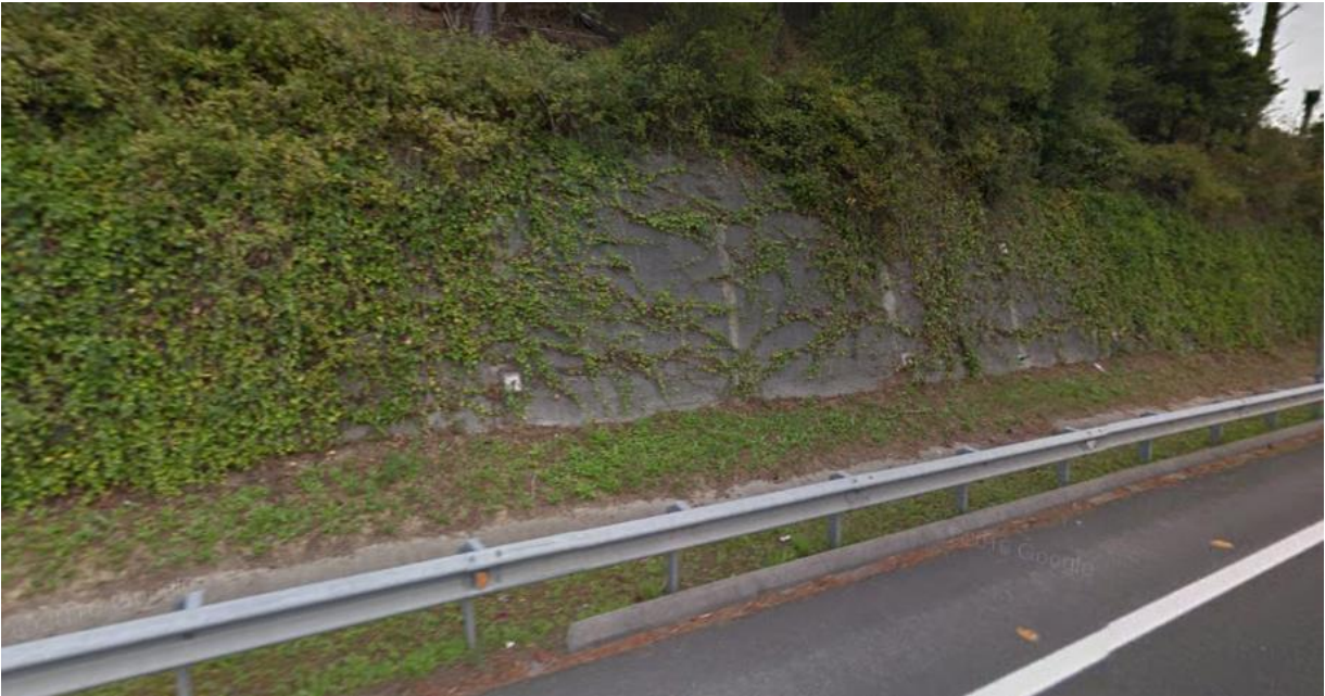
Imagen 30: Plantación de trepadoras para ocultación de un muro de gunita en variante de Igorre.
