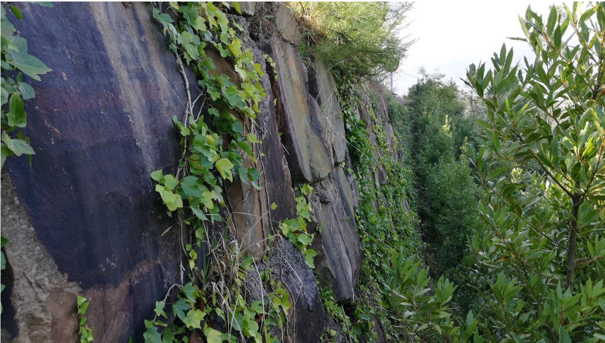
Imagen 29: Plantación de pantalla vegetal de laurus nobilis al pie de un muro de escollera en la BI-3101.
