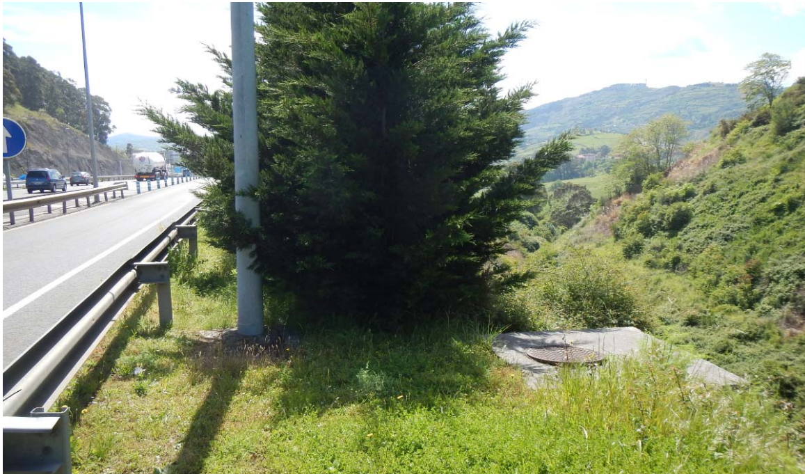
Arqueta de la Red de Drenaje de la A-8 afectada por la nueva senda ciclable.
