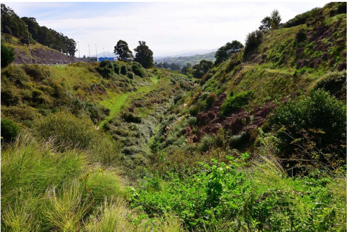
Rellenos antropogénicos. A la izquierda terraplén de la A-8 (Qr) y a la derecha rellenos mineros (Qm).
