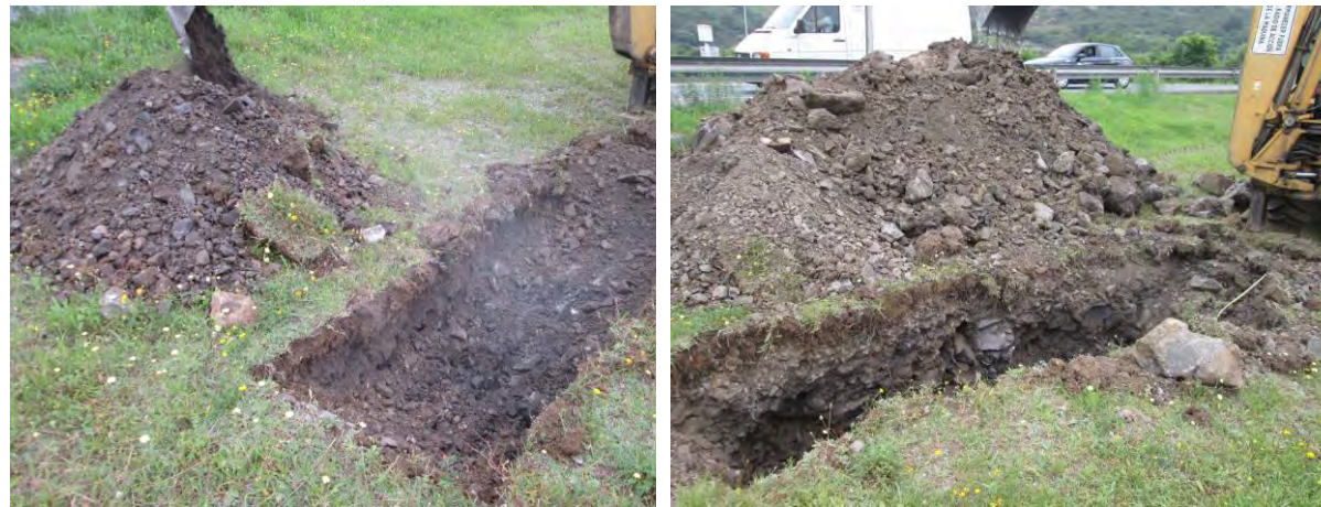
Fotografía 1a (izda.) y 1b (drcha.). Aspecto del relleno durante la excavación de las calicatas
