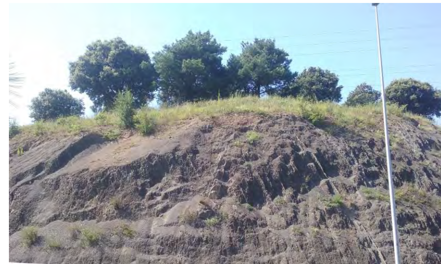
Fotografía 3. Aspecto del macizo rocoso en afloramiento de desmonte, afectado por fenómenos de meteorización superficial y erosión diferencial.
