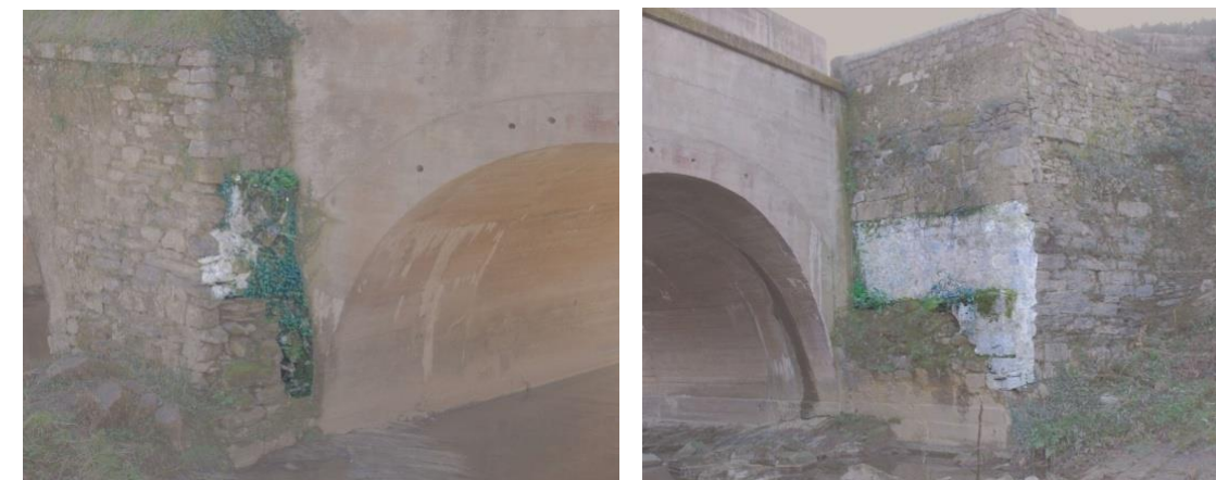
Figura 30. Elementos de arreglo situados a ambos lados del primitivo arco 1 del puente.
