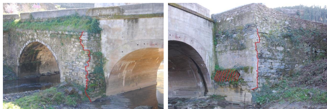
Figura 22. Imágenes donde se han marcado los cortes realizados en el puente en el contexto de la Guerra Civil (UE 1 izquierda, UE 2 derecha).
