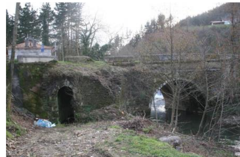
Vista del aliviadero
