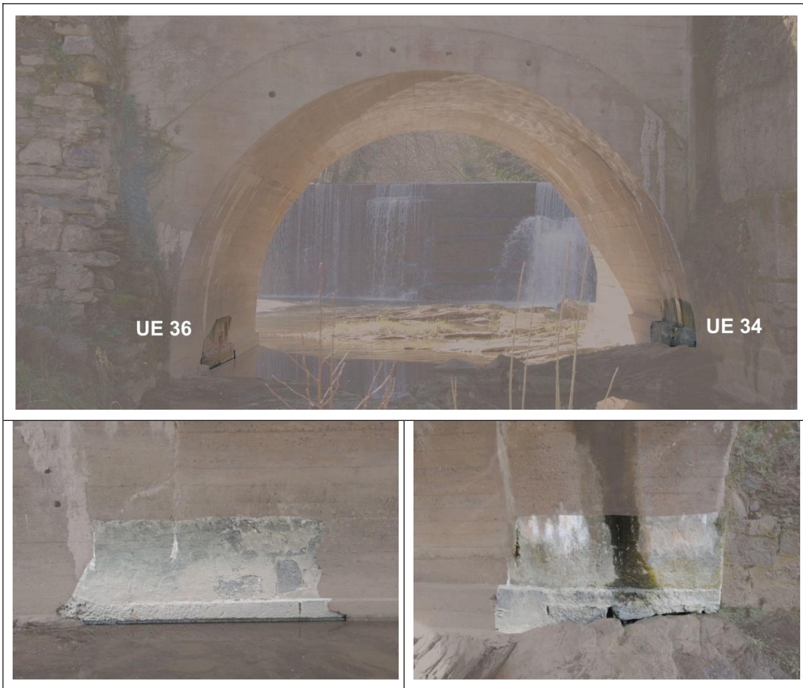
Figura 18. Imágenes del arco 1. En la de arriba se sitúan los restos del arco dentro de la rosca. En las fotografías inferiores, detalles de los mismos (UUEE 34 a la derecha y 36 a la izquierda).
