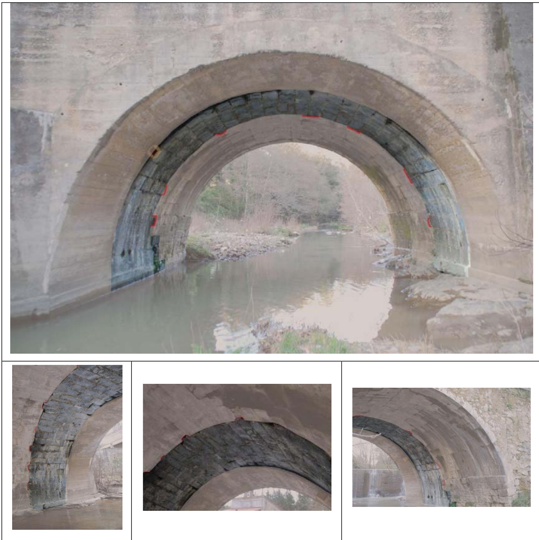
Figura 17. Imágenes del arco 2. Se destacan en rojo los cortes realizados en su rosca (UE 25), además de la parte del arco ampliada (UE 26).
