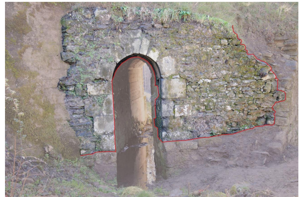
Figura 16. En rojo, ruptura para la obra de reforma del aliviadero. Nueva fachada del aliviadero destacada sobre la fotografía.
