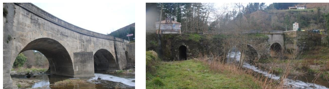
Figura 2. Fotografías generales del puente de Plazakola, a la izquierda, aguas arriba y a la derecha aguas abajo.
