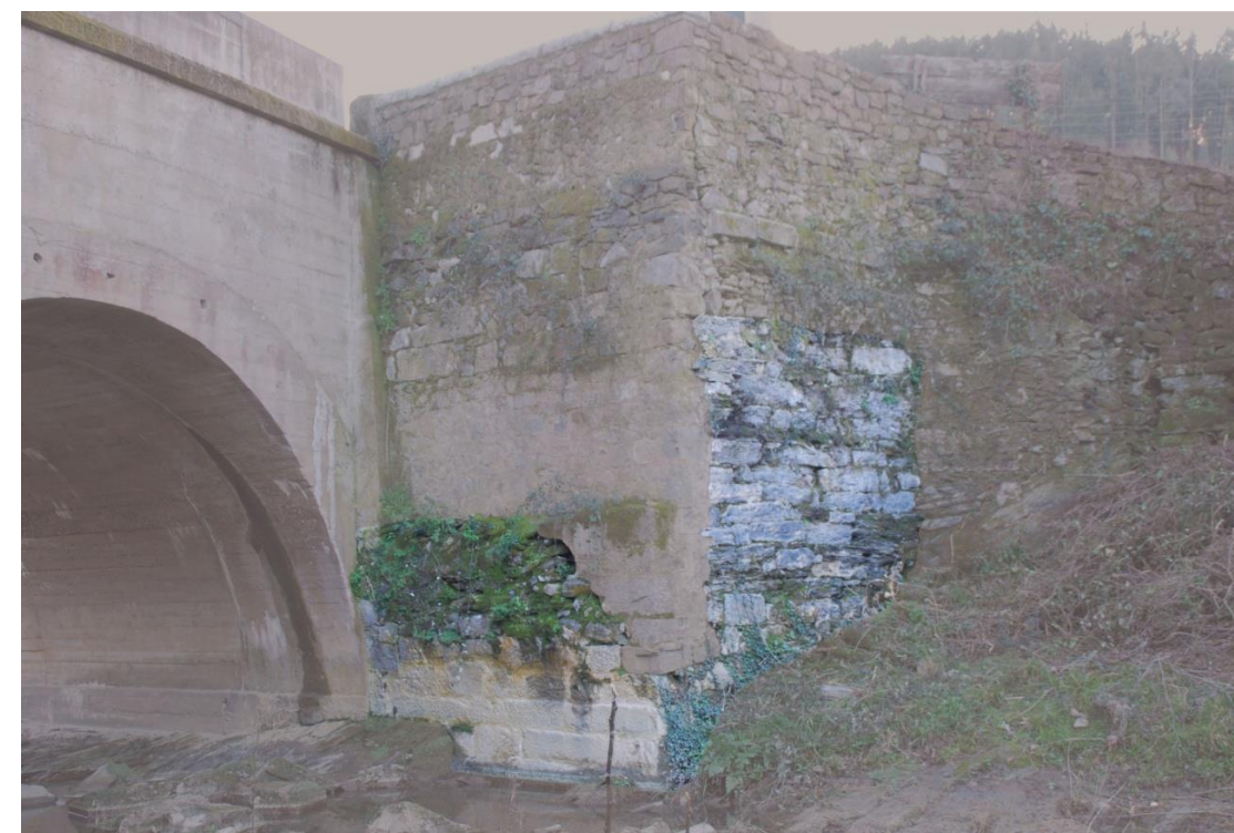
Figura 10. Fotografía de un tramo del puente aguas abajo, donde se ha destacado la UE. 1. El frente del muro hacia el río, por encima de la obra de sillería, también forma parte de esta UE; pero al estar forrado posteriormente, no se aprecia. Es, en realidad, el núcleo del muro una vez caído el arco.
