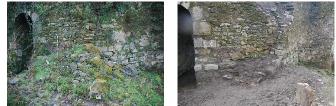
Figura 5. Imágenes del estado inicial de la zona del estribo aguas abajo (izquierda) y estado final una vez eliminando el derrumbe (derecha).
