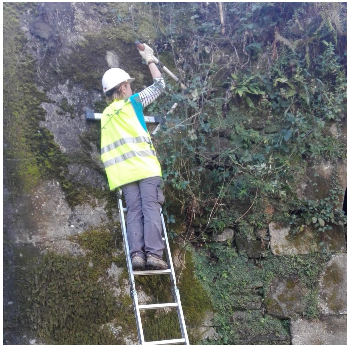
Figura 4. Trabajo de limpieza manual de los alzados del puente de Plazakola.
