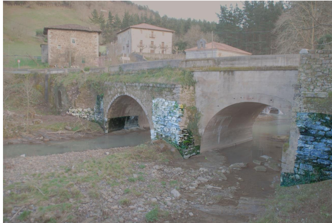
Figura 11. Fotografía general del puente aguas abajo; se han destacado las estructuras pertenecientes a la Fase 1.
