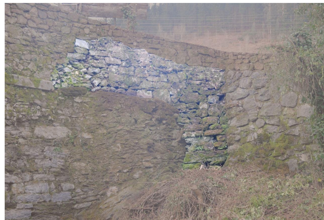
Figura 28. Estructura (UE 11) de la zona del estribo occidental, aguas abajo.
