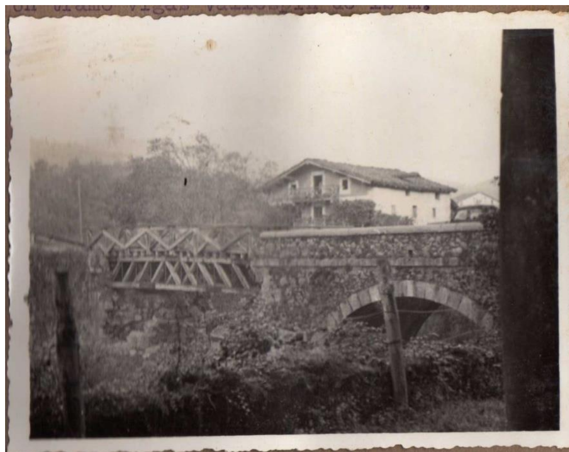
Figura 25. Primitiva fotografía en la que se identifica la estructura de madera provisional, donde en origen estaba el arco 1 del puente.
