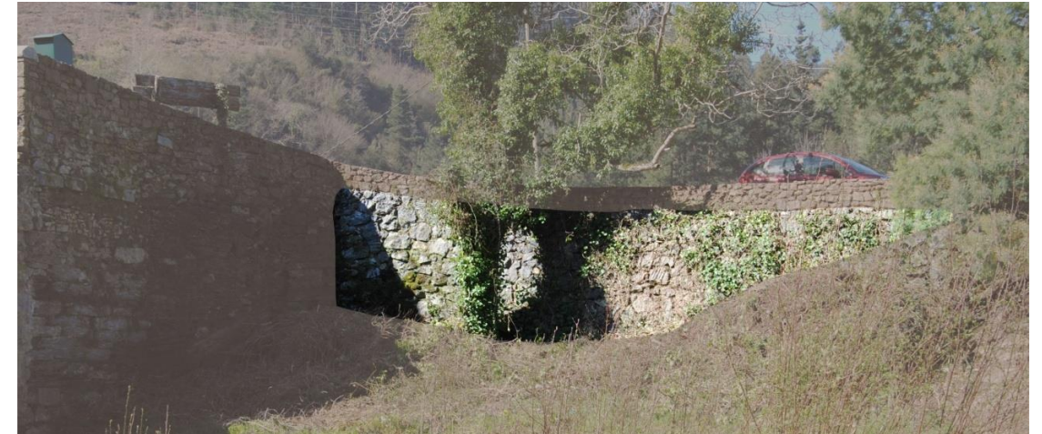
Figura 33. Vista parcial de la UE 12, que sirve de contención a la vía superior.
