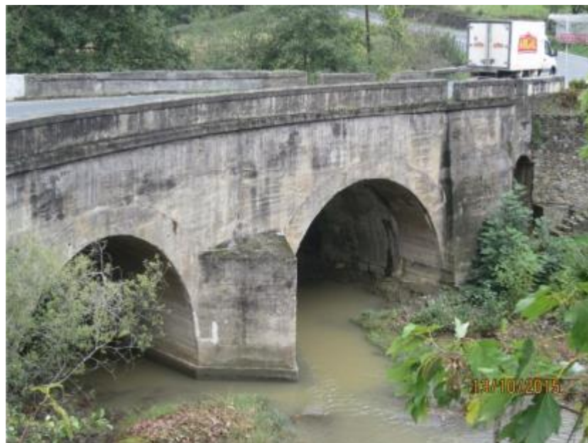
Vista del puente aguas arriba
