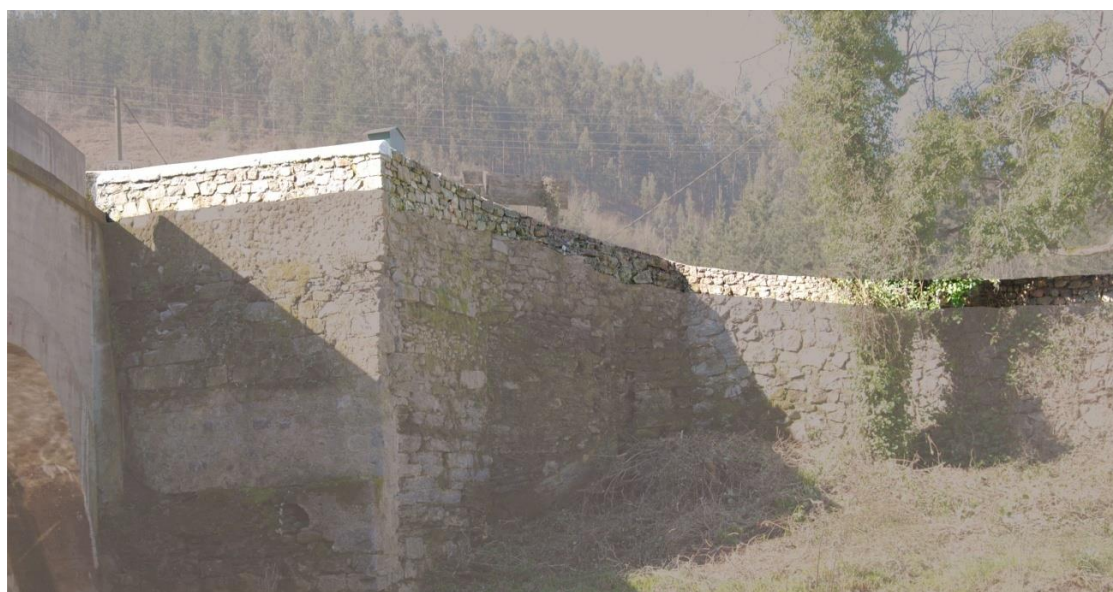
Figura 36. Fotografía donde se destaca la obra del remate del estribo izquierdo aguas abajo.
