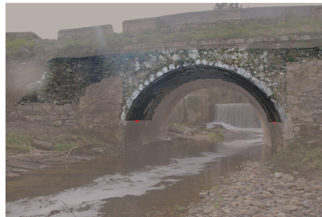
Figura 13. Obra de la parte superior del arco 2. Destacamos en la fotografía los dos mechinales enfrentados (en rojo), que asociamos con el anclaje de la cimbra para la construcción del arco.
