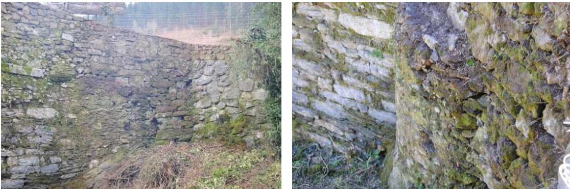
Figura 19. Fotografías de la UE 8, situada en la parte del estribo occidental del puente, aguas abajo.
