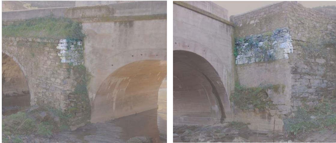
Figura 31. Nuevos elementos de arreglo en la zona del primitivo arco 1 del puente.
