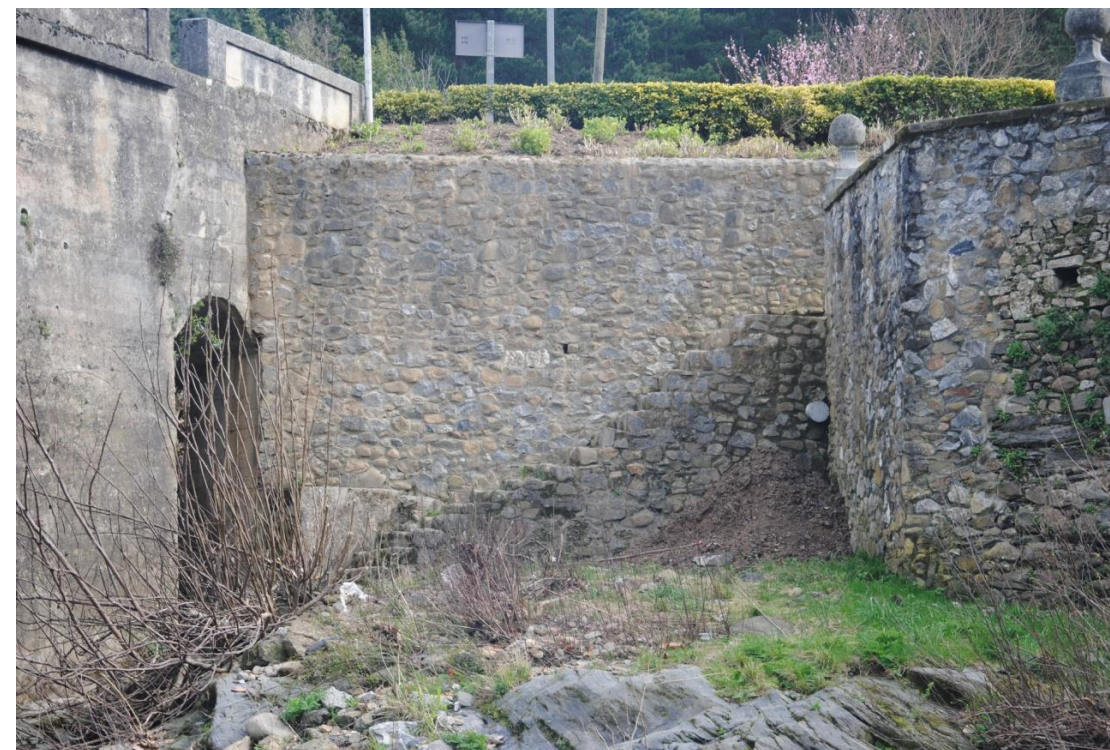
Figura 37. Estructura del estribo y escalera de acceso situado en la margen derecha, aguas arriba del puente.
