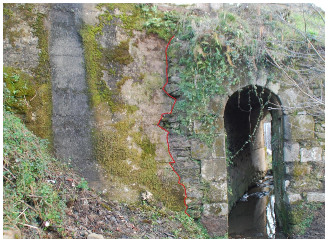
Figura 27. Fotografía del extremo oriental del puente, aguas abajo. Se ha destacado en rojo la línea de ruptura (UE 33), para poder insertar la obra de hormigón.
