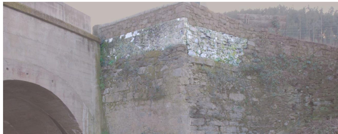
Figura 32. Estructura de arreglo en la parte superior del estribo occidental
