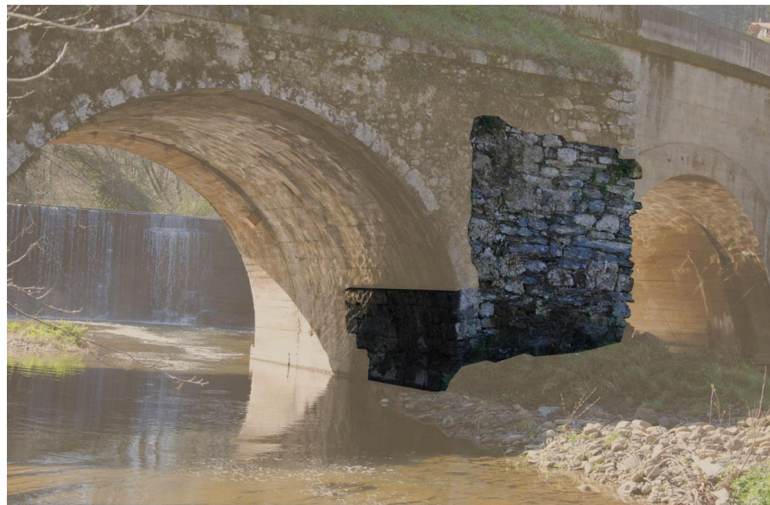
Figura 9. Fotografía de un tramo del puente aguas abajo, donde se ha destacado la UE. 20.
