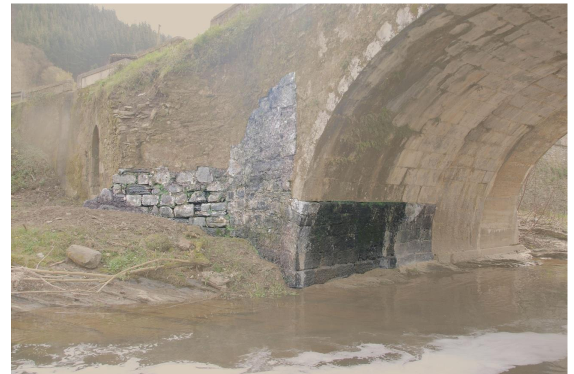
Figura 8. Fotografía de un tramo del puente aguas abajo, donde se ha destacado la UE. 29.
