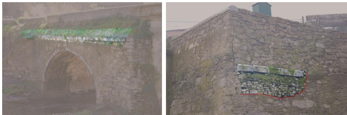
Figura 20. Fotografías de los restos de antigua cornisa (UE 28 y 9), localizadas en distintos lugares del puente, aguas abajo. También se destaca en rojo, en la imagen de la derecha, el corte (UE 7) para asentar la estructura (UE 9).
