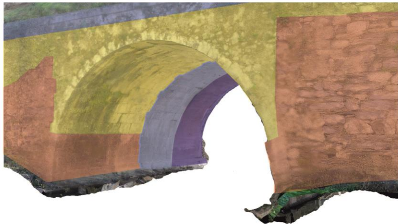
ARCO MARGEN DERECHA. VISTA DESDE LA MARGEN IZQUIERDA
