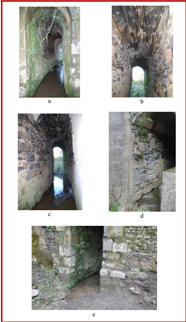
Figura 14. Aliviadero. a: interior desde aguas abajo. b. bóveda. c. interior desde aguas arriba. d. jamba izquierda de su entrada aguas arriba. e. Parte inferior del aliviadero aguas abajo.
