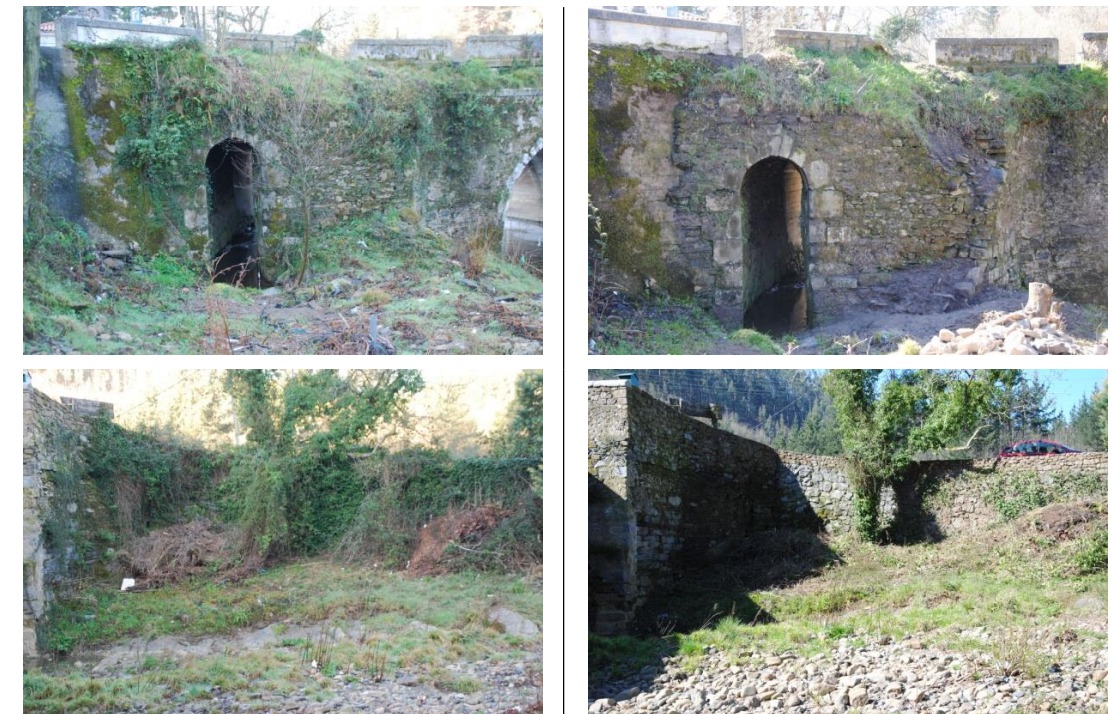
Figura 6. Fotografías de la zona oriental del puente (arriba) y zona occidental (abajo); antes (fotografías de la izquierda) y después (fotografías de la derecha) de la limpieza realizada.
