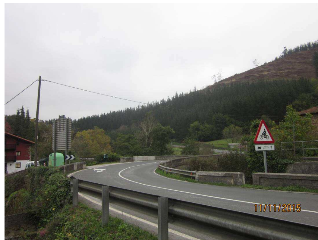
VISTA DE LA CALZADA EN EL PUENTE EN SENTIDO BERRIATUA
