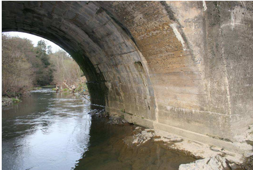
VANO 2 ZONA DEL ESTRIBO. VISTA AGUAS ARRIBA
