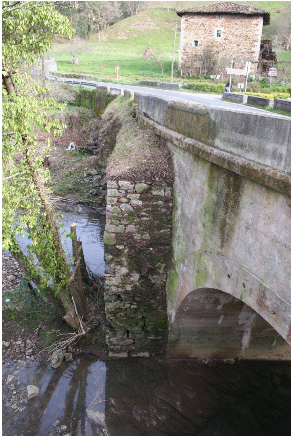
VANO 1 Y PILA CENTRAL. VISTA AGUAS ABAJO
