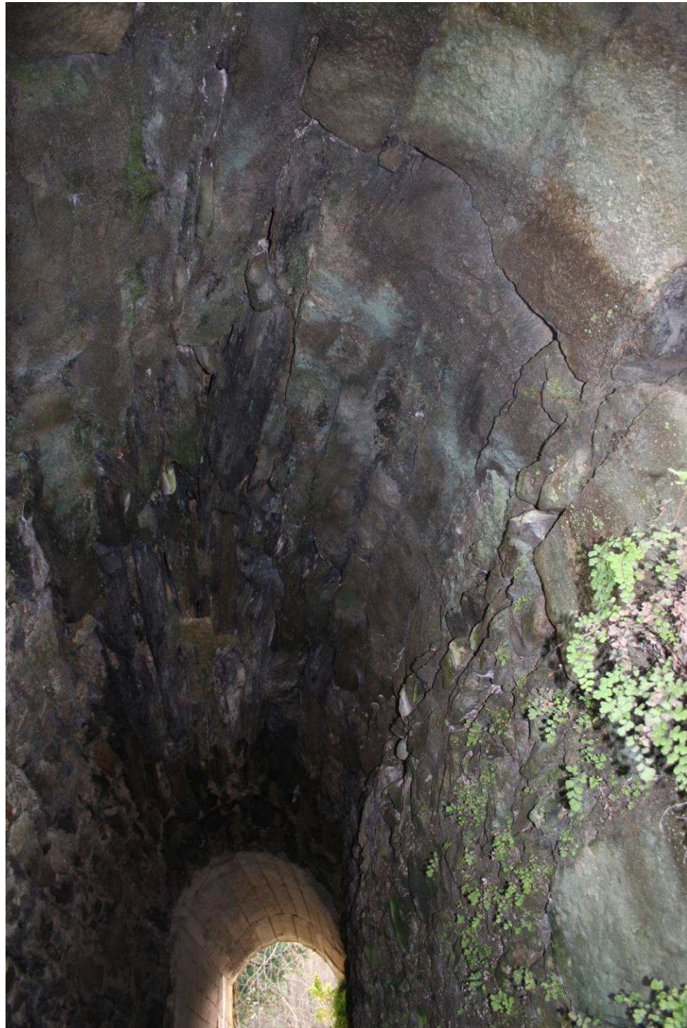
INTERIOR GALERIA AGUAS ABAJO
