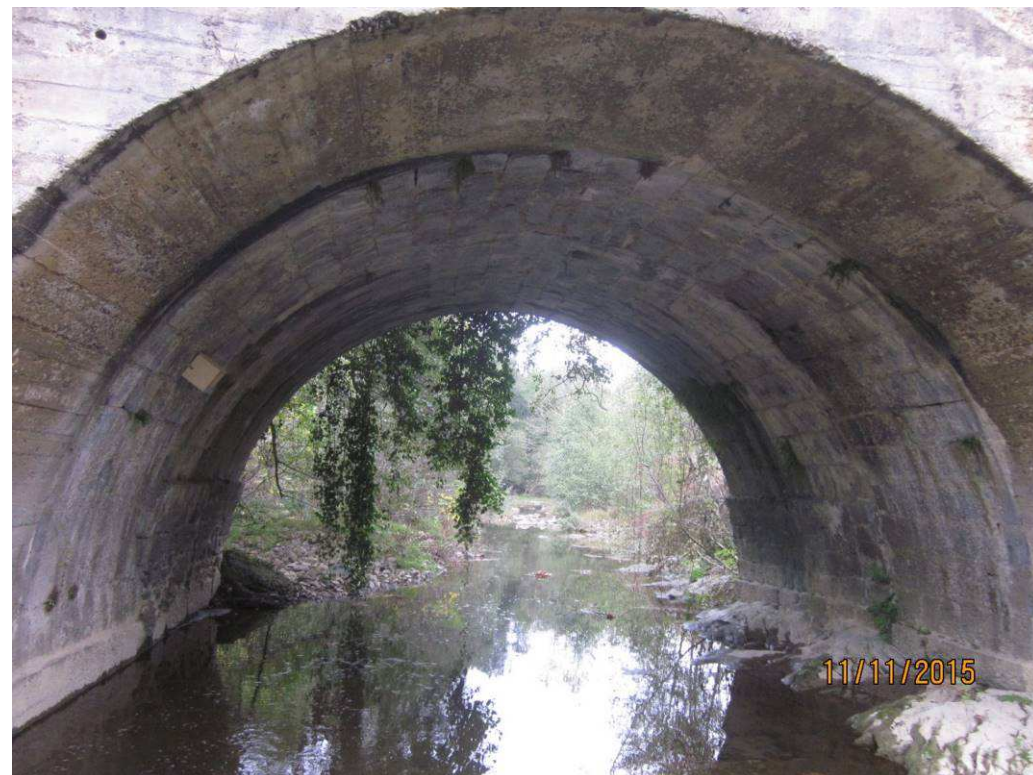
BÓVEDA VANO 2. VISTA AGUAS ARRIBA
