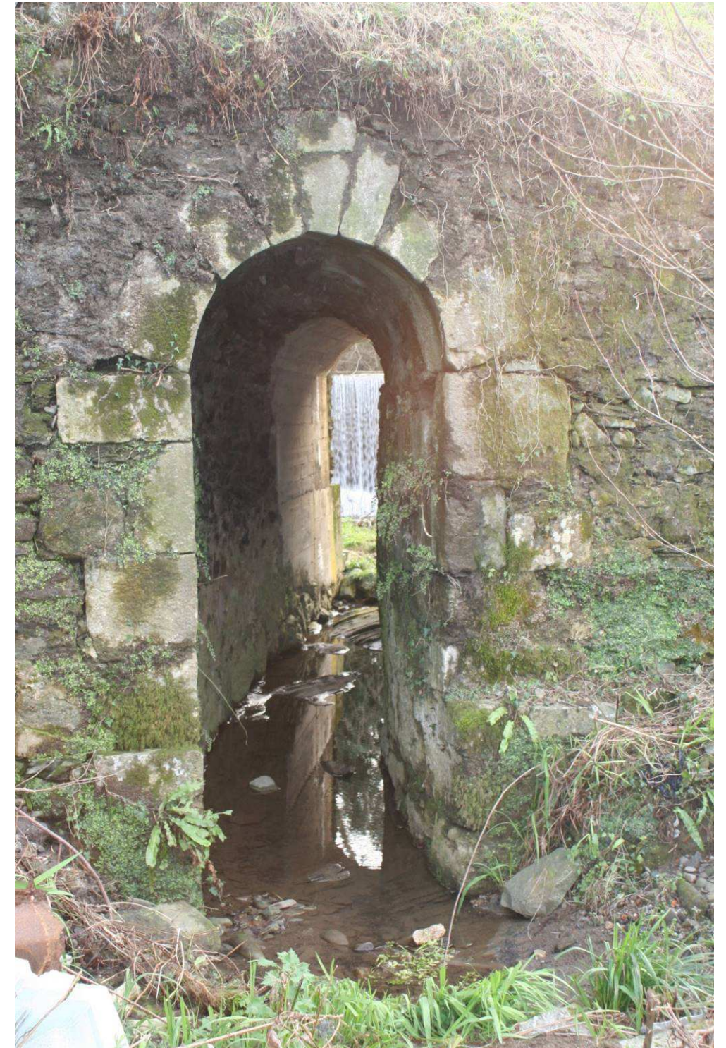
GALERIA AGUAS ABAJO
