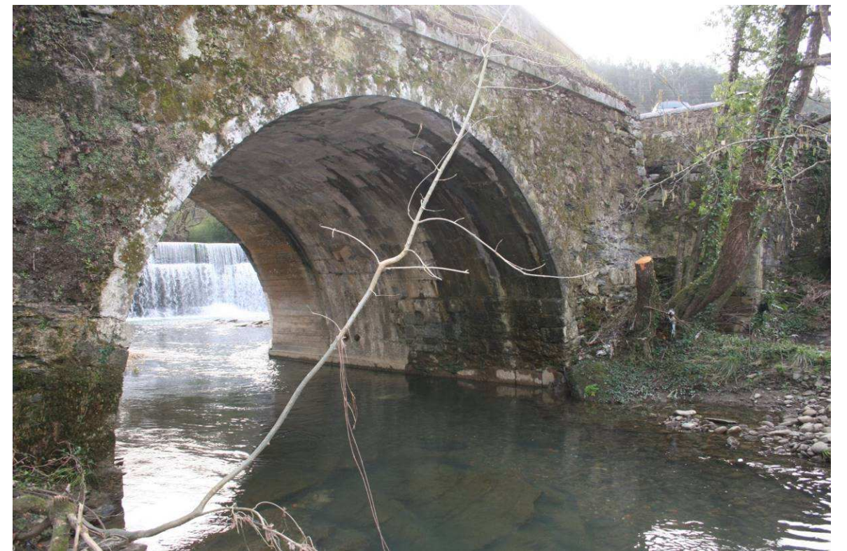
BÓVEDA VANO 2 DESDE MARGEN DERECHA
