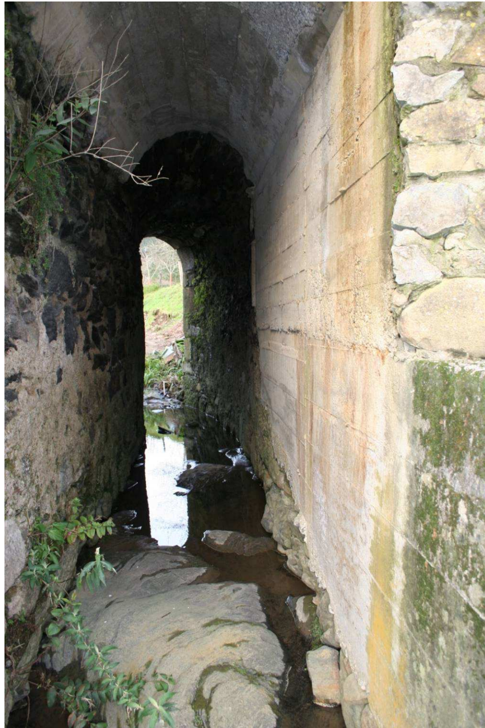
INTERIOR GALERIA AGUAS ARRIBA
