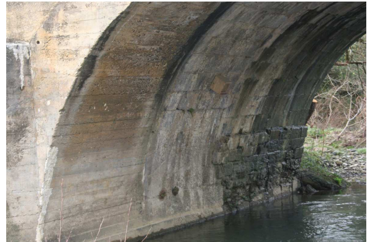
VANO 2 ZONA DE LA PILA. VISTA AGUAS ARRIBA
