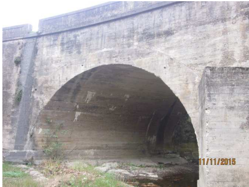
BÓVEDA VANO 1. VISTA AGUAS ARRIBA
