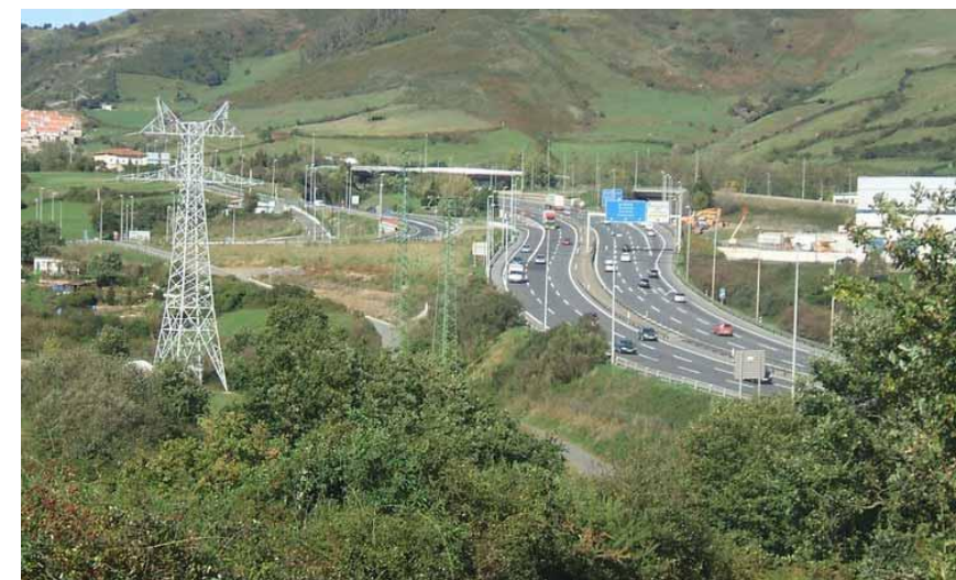
Rellenos antropogénicos. Terraplén de la A-8.
