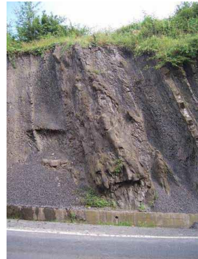
“Slump” próximo al barrio de Urioste.
