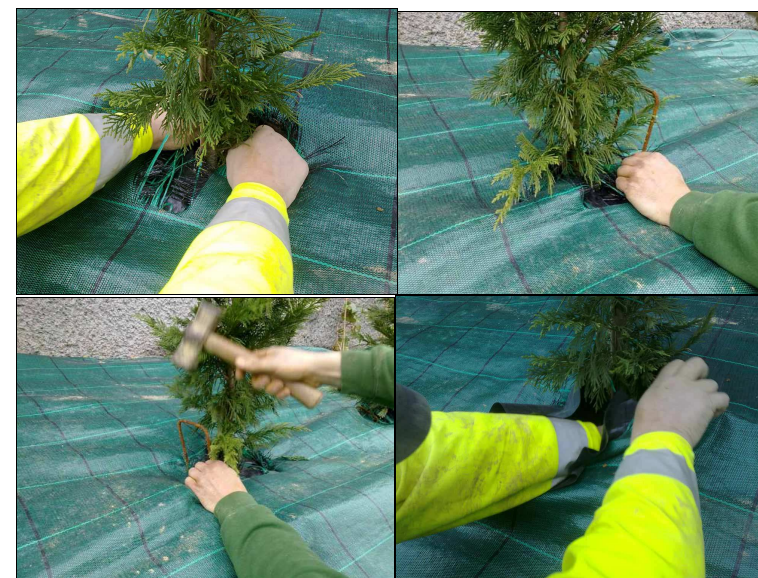
Fig. 1: colocación del collarín de cierre y fijaciones.
