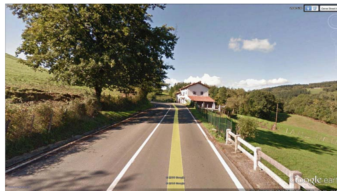
Vista del muro en la zona exterior de la vía
