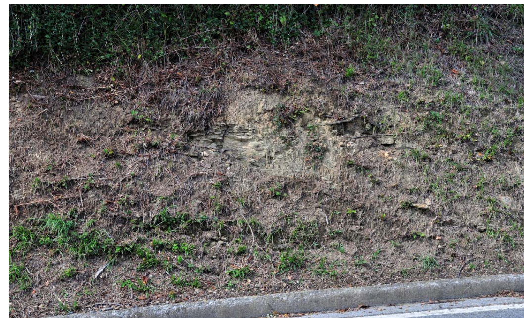
Afloramiento rocoso en el talud del desmonte de la carretera
