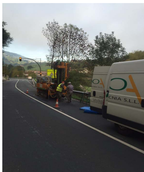
Sondeo Mecánico S-37+100
