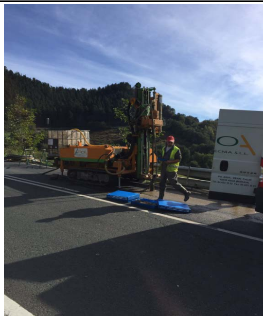
Sondeo Mecánico S-50+750
