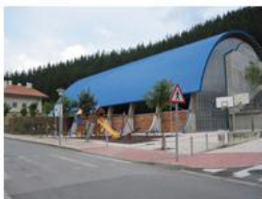
4.57: Ejecución de un equipamiento municipal socio-cultural
