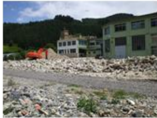
2.50: Demolición de la factoría de La Esperanza y Cia.
