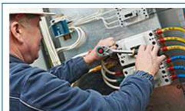
Renove instalaciones eléctricas
