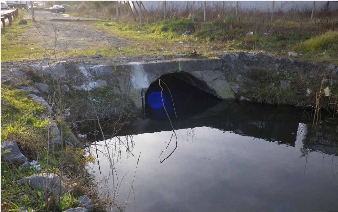
Figura 17: Boca de entrada de la obra de drenaje
