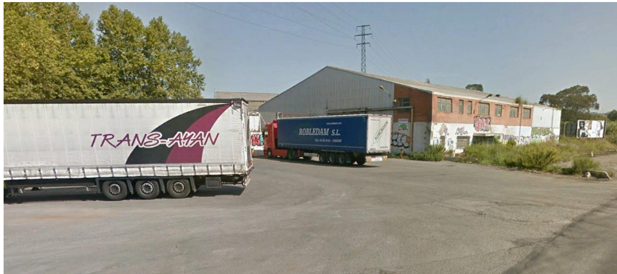
Figura 5: Explanada con aparcamiento de camiones
