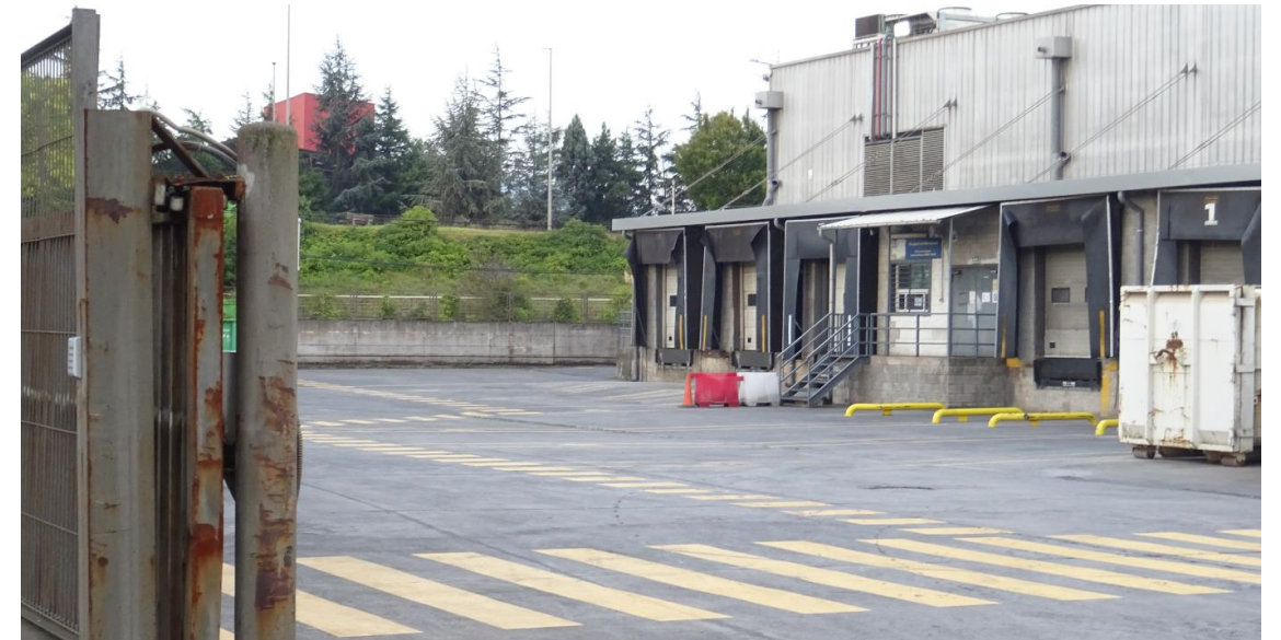
Figura 11: bahías de camiones
