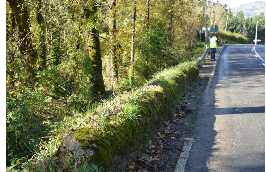
Cercanía del río El Callejo previo al cruce de la subida a Ibañez (pk 1+820)
