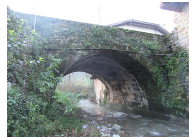
Vista del puente aguas arriba donde se ejecutará la acera en voladizo.
