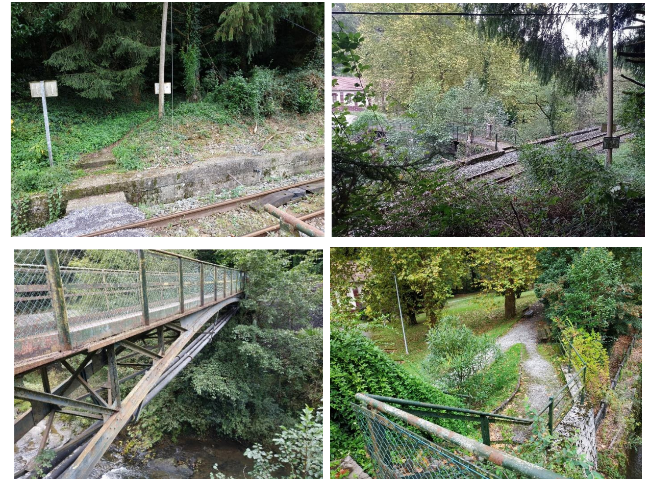
Paso a nivel existente
