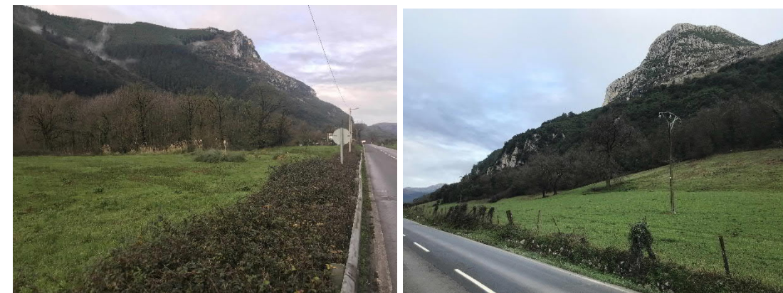
Paso de fauna, con zonas de bosque a ambos lados de la carretera actual
