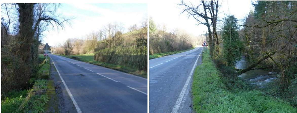
Paso de fauna, que conecta zona de campiña con las riberas del río Callejo.
