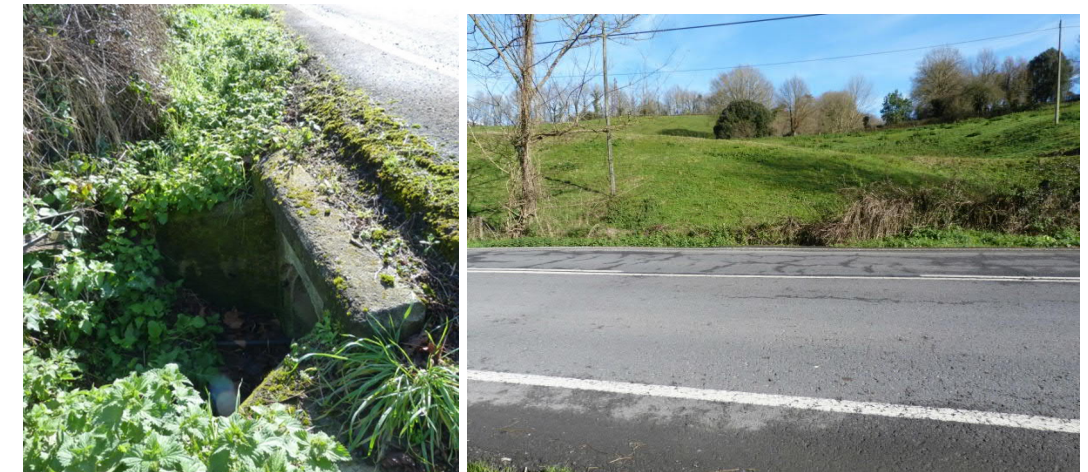
Regata La Tolina, aguas arriba y paso subterráneo no permeable a la fauna.
