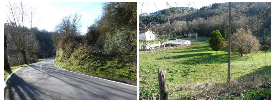
Carretera que va hacia el Karpin, donde se puede observar un pequeño paso (PK 0+110) para la fauna que conecta con los prados junto al barrio de El Callejo y al fondo la carreta y las riberas del río Callejo.
