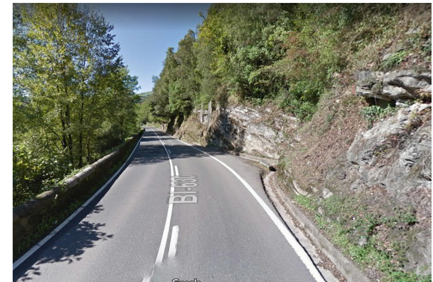
Regata El Molina, discurre bajo la carretera por caño no permeable a la fauna.
