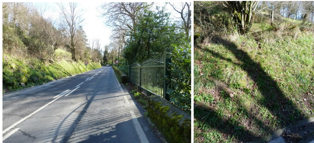
Tramo de la carretera actual que es utilizado como zona de paso por ungulados (PK 4+000 – PK 4+050).
