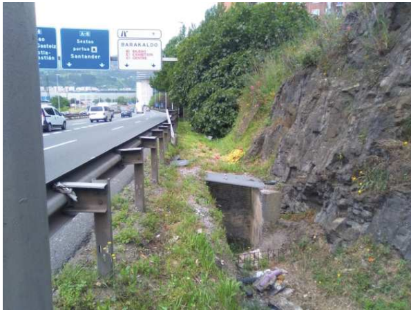
Foto 6.- Imagen del final del perfil de tomografía eléctrica TME-1, en la que se aprecia un paso.
