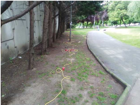
Foto 1.- Imagen de la zona inicial del perfil de tomografía eléctrica TME-1, a su paso por una zona ajardinada.
