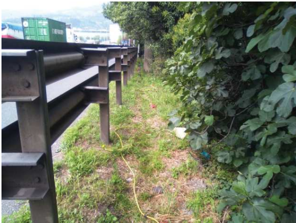
Foto 5.- Imagen de la zona final del perfil de tomografía eléctrica TME-1, muy próximo a la autopista.
