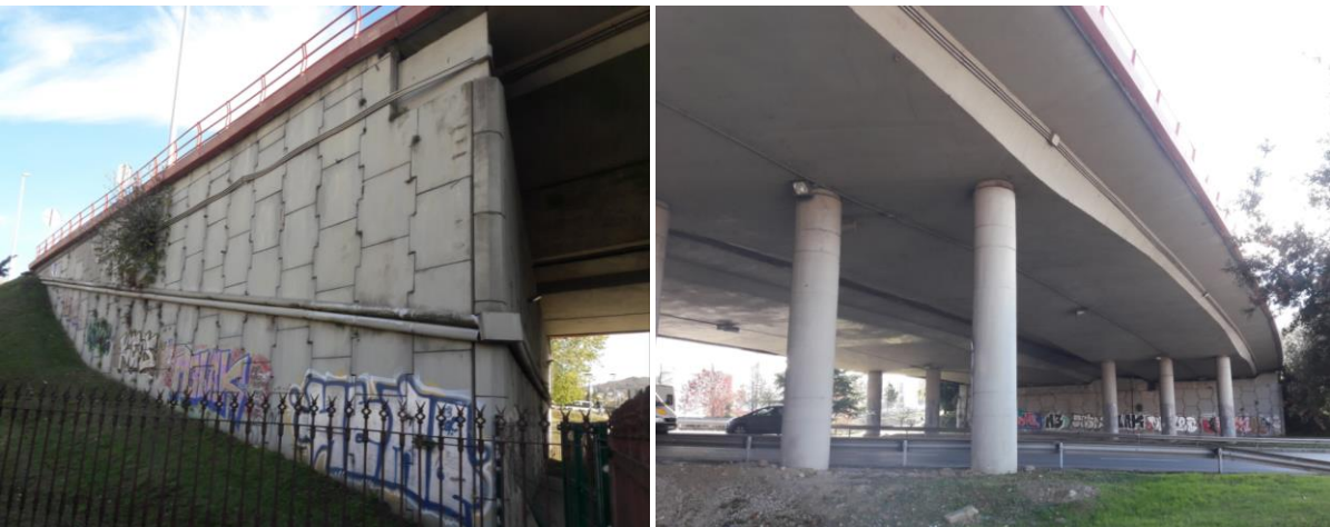
Aspecto actual del tablero dirección Cantabria del viaducto del Buen Pastor
