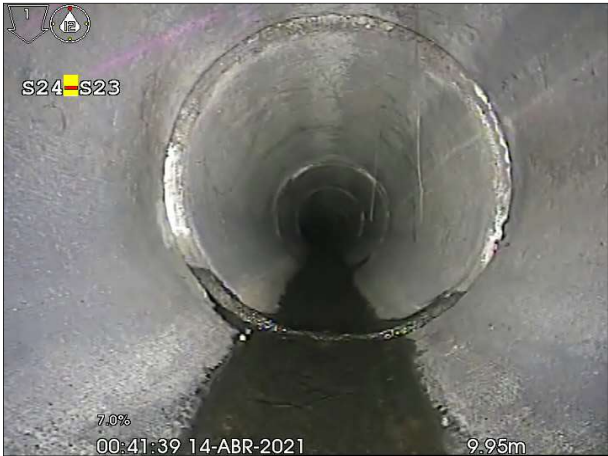
Fotografía: 81a, Nº Video: 28, 00:01:28 10,2m, Junta abierta desde 12 hasta 12 horas
