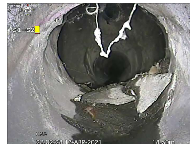
Fotografía: 5a, N° Video: 1, 00:03:20 19,4m, Fin de la inspección, Arqueta S2
