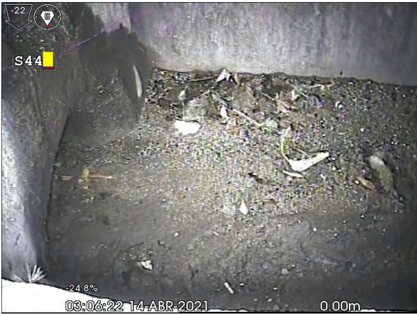
Fotografía: 145a, N° Video: 52, 00:00:00 0m, Fin de la inspección
