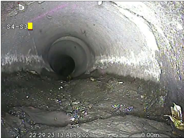
Fotografía: 14a, Nº Video: 5, 00:00:00 0m, Inicio de la inspección, Arqueta S4
