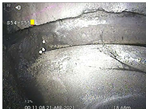
Fotografía: 174b, Nº Video: 63, 00:01:29 18,7m, Junta abierta desde 12 hasta 12 horas
