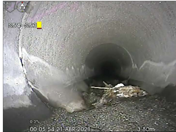
Fotografía: 171a, Nº Video: 62, 00:00:33 4,9m, Llegada al punto deseado, punto donde la cámara no podía avanzar desde la arqueta S53.
