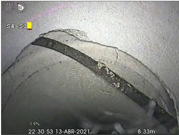
Fotografía: 18b, Nº Video: 5, 00:01:19 8m, Goma de junta suelta desde 11 hasta 03 horas, junta abierta.
