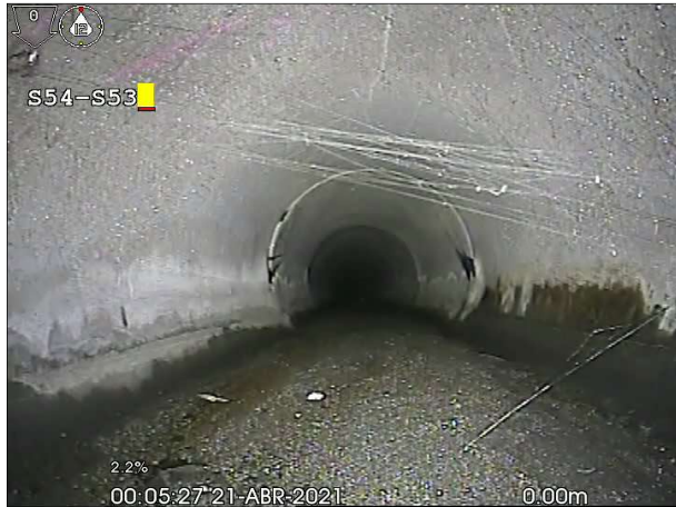
Fotografía: 170a, N° Video: 62, 00:00:00 0m, Inicio de la inspección, Arqueta S54
