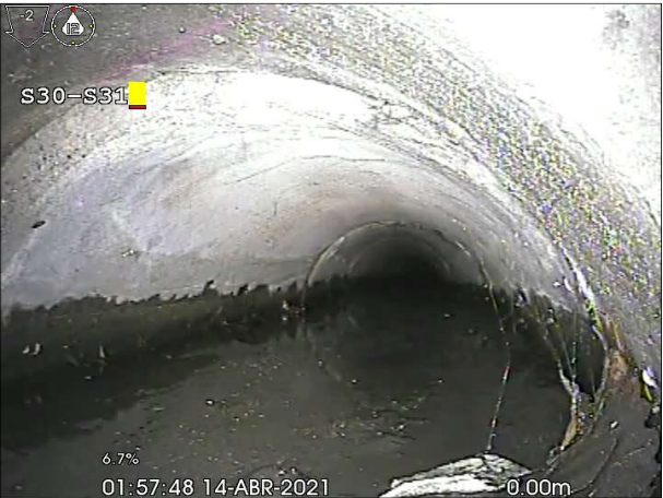
Fotografía: 117a, Nº Video: 38, 00:00:00 0,2m, Inspección interrumpida, La cámara no puede avanzar.
