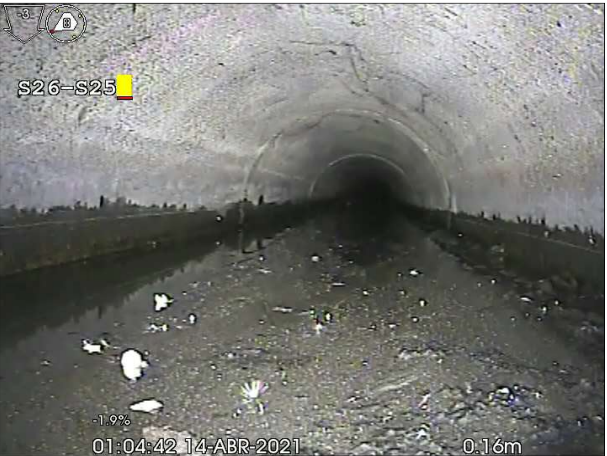
Fotografía: 91a, N° Video: 31, 00:00:00 0m, Inicio de la inspección, Arqueta S26
