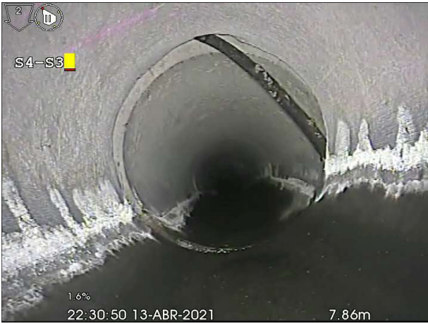
Fotografía: 18a, Nº Video: 5, 00:01:19 8m, Goma de junta suelta desde 11 hasta 03 horas, junta abierta.
