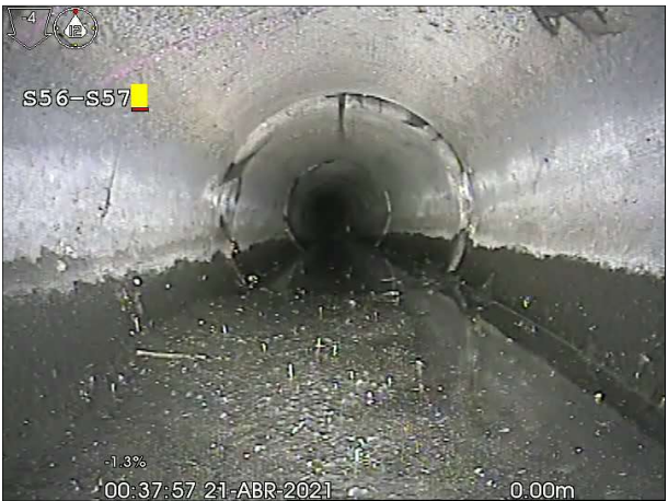
Fotografía: 186a, N° Video: 67, 00:00:00 0m, Inicio de la inspección, Arqueta S56
