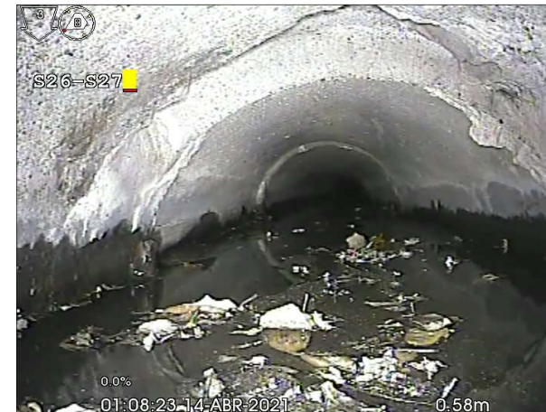
Fotografía: 93a, N° Video: 32, 00:00:00 0m, Inicio de la inspección, Arqueta S26
