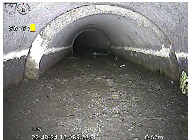
Fotografía: 33b, N° Video: 9, 00:00:09 0,6m, Junta abierta desde 12 hasta 12 horas
