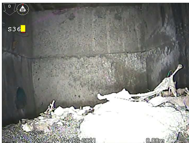
Fotografía: 128a, N° Video: 44, 00:00:00 0m, Inicio de la inspección, Arquets S36
