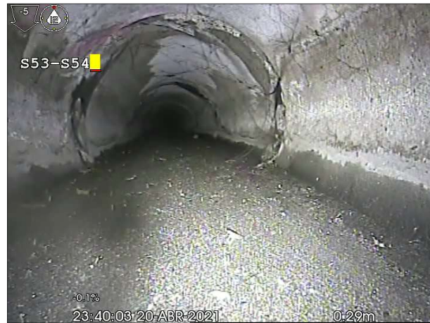
Fotografía: 161a, N° Video: 60, 00:00:07 1m, Junta abierta desde 12 hasta 12 horas
