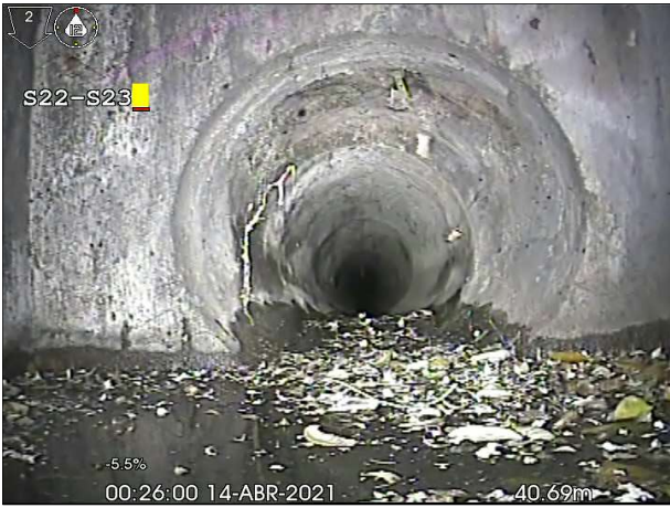
Fotografía: 77b, N° Video: 27, 00:03:22 40,7m, Fin de la inspección, Arqueta S23
