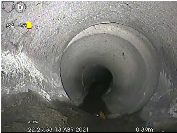
Fotografía: 16a, Nº Video: 5, 00:00:11 0,5m, Junta abierta desde 12 hasta 12 horas
