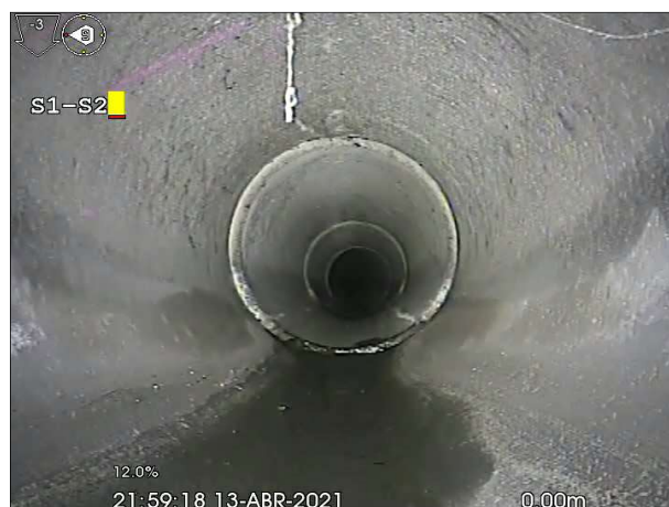
Fotografía: 1a, N° Video: 1, 00:00:00 0m, Inicio de la inspección, Arqueta S1
