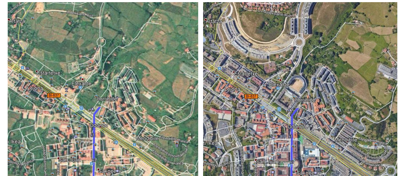
Figura 3: En estas ortofotos, de 1991 y 2019, respectivamente, se observa -en trazo azul- la canalización del arroyo Elexalde en su cruce bajo la autovía BI-637 y el proceso de urbanización en la cuenca del Arroyo Elexalde.
