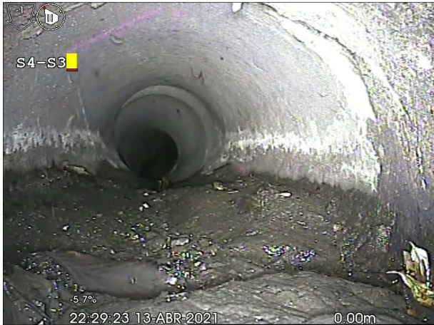
Fotografía: 15a, Nº Video: 5, 00:00:00 0m, Obstáculo por sedimentaciones desde 04 hasta 08 horas.
