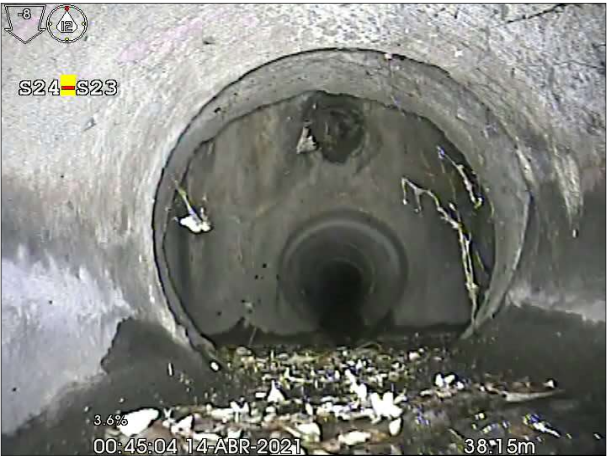
Fotografía: 83a, Nº Video: 28, 00:04:52 38,9m, Fin de la inspección, Arqueta S23
