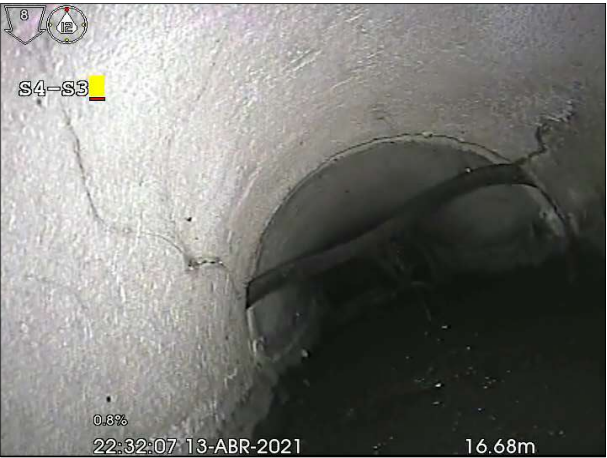
Fotografía: 21a, Nº Video: 5, 00:02:36 16,7m, Goma de junta suelta desde 10 hasta 02 horas
