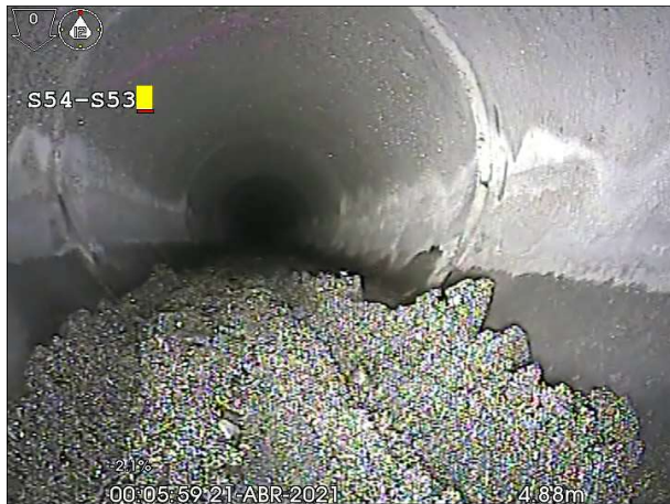
Fotografía: 171b, Nº Video: 62, 00:00:33 4,9m, Llegada al punto deseado, punto donde la cámara no podía avanzar desde la arqueta S53.
