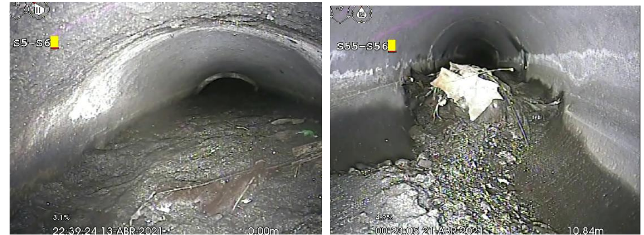
Figura 15: Sedimentos y obstáculos.
