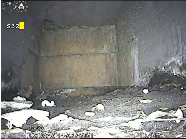
Fotografía: 120a, Nº Video: 40, 00:00:00 0m, Inicio de la inspección, Arqueta S32
