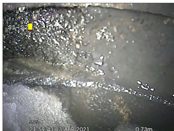
Fotografía: 2b, N° Video: 1, 00:00:07 0,5m, Junta abierta desde 12 hasta 12 horas
