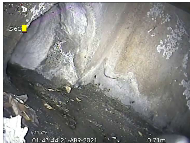
Fotografía: 205a, N° Video: 73, 00:00:00 0,2m, Fin de la inspección
