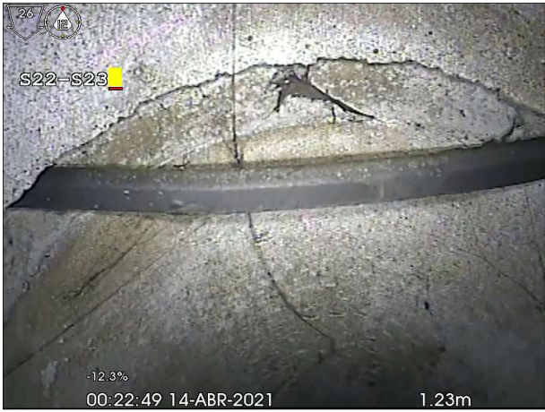
Fotografía: 75b, N° Video: 27, 00:00:08 0,7m, Goma de junta suelta desde 10 hasta 01 horas
