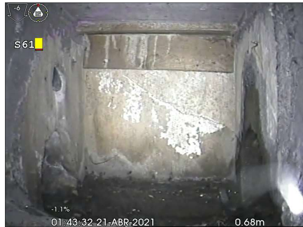
Fotografía: 207a, N° Video: 73, 00:00:00 0m, Encofrado perdido.
