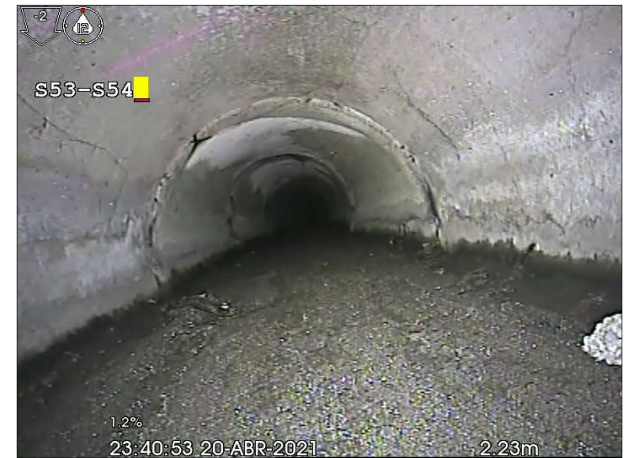
Fotografía: 163a, N° Video: 60, 00:00:56 2,2m, Obstáculo por sedimentaciones desde 04 hasta 08 horas. Reducción de sección 20 %
