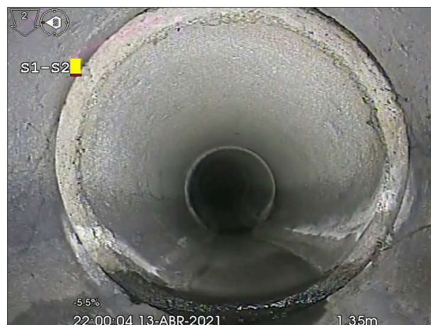
Fotografía: 3a, N° Video: 1, 00:00:46 1,4m, Junta abierta desde 12 hasta 12 horas
