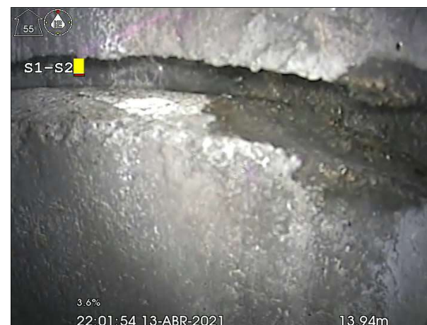
Fotografía: 4b, N° Video: 1, 00:02:20 13,2m, Junta abierta desde 12 hasta 12 horas
