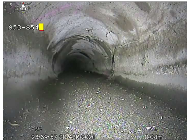
Fotografía: 160a, N° Video: 60, 00:00:00 0m, Inicio de la inspección, Arqueta S53
