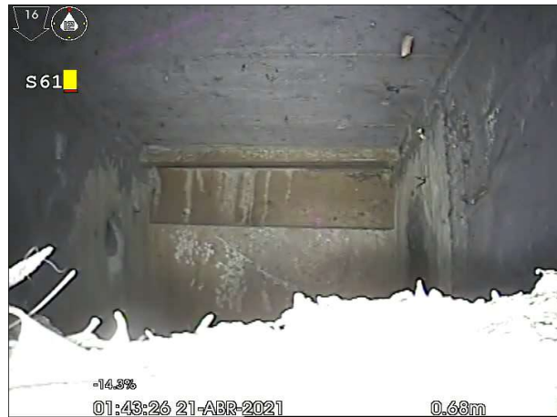
Fotografía: 204a, N° Video: 73, 00:00:00 0m, Inicio de la inspección, Arqueta S61
