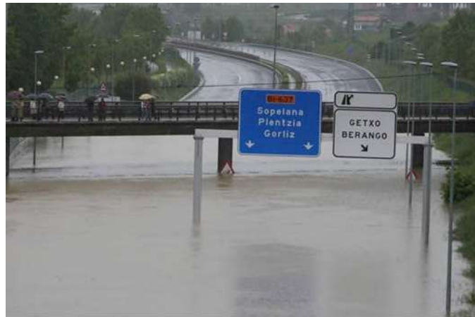
Figura 13. La autovía de la avanzada bajo el agua. Fuente: El Correo
