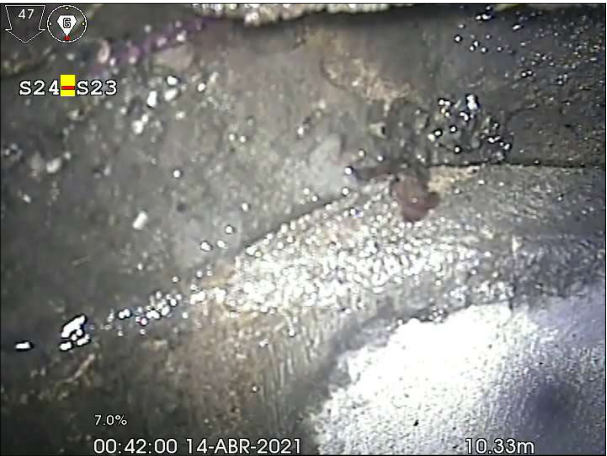
Fotografía: 81b, Nº Video: 28, 00:01:28 10,2m, Junta abierta desde 12 hasta 12 horas
