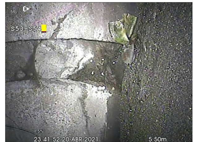
Fotografía: 164b, N° Video: 60, 00:01:44 5,5m, Junta abierta desde 12 hasta 12 horas
