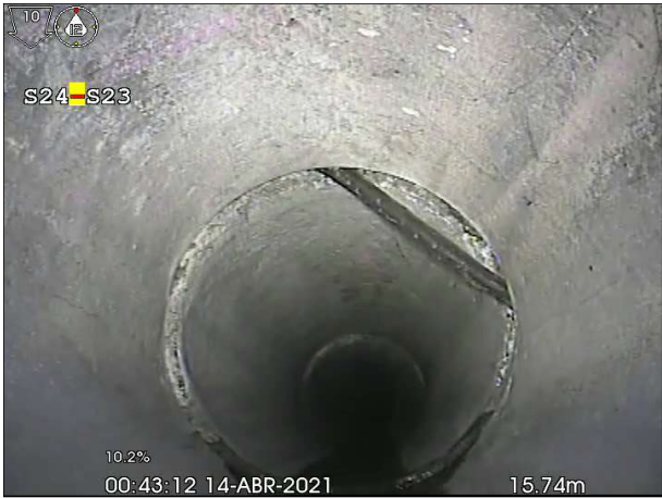
Fotografía: 82a, Nº Video: 28, 00:03:01 15,7m, Goma de junta suelta desde 12 hasta 03 horas
