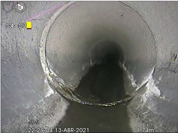
Fotografía: 17a, Nº Video: 5, 00:00:22 1,8m, Junta abierta desde 12 hasta 12 horas
