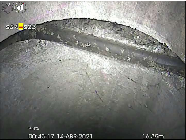
Fotografía: 82b, Nº Video: 28, 00:03:01 15,7m, Goma de junta suelta desde 12 hasta 03 horas
