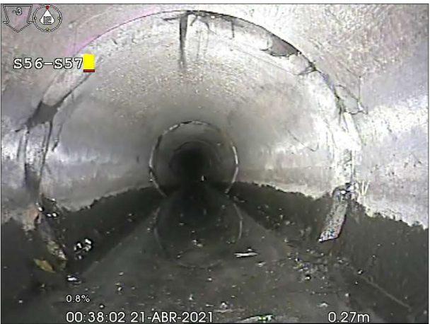
Fotografía: 187a, N° Video: 67, 00:00:07 0,3m, Junta abierta desde 12 hasta 12 horas
