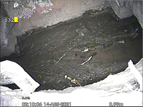
Fotografía: 120b, Nº Video: 40, 00:00:00 0m, Inicio de la inspección, Arqueta S32
