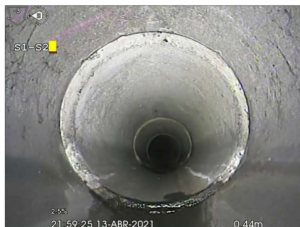
Fotografía: 2a, N° Video: 1, 00:00:07 0,5m, Junta abierta desde 12 hasta 12 horas
