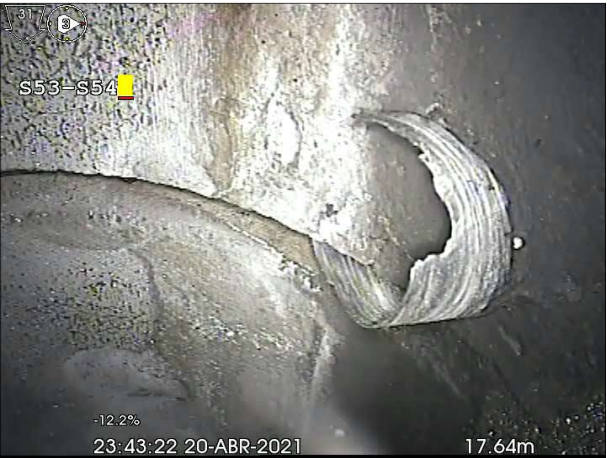
Fotografía: 165b, N° Video: 60, 00:03:20 17,64m, Goma de junta suelta desde 04 hasta 05 horas
