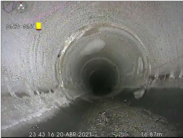
Fotografía: 165a, N° Video: 60, 00:03:20 17,64m, Goma de junta suelta desde 04 hasta 05 horas
