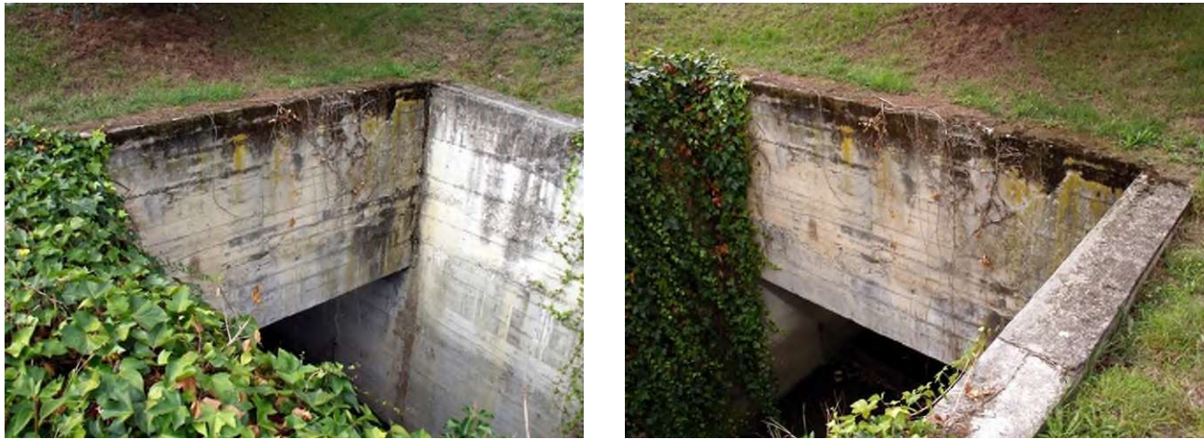
Figura 6. Embocadura norte del paso del arroyo Elexalde bajo la BI-637
