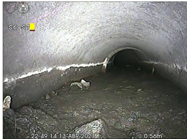
Fotografía: 31a, N° Video: 9, 00:00:00 0m, Inicio de la inspección, Arqueta S6
