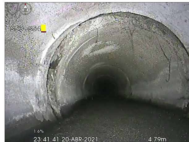
Fotografía: 164a, N° Video: 60, 00:01:44 5,5m, Junta abierta desde 12 hasta 12 horas
