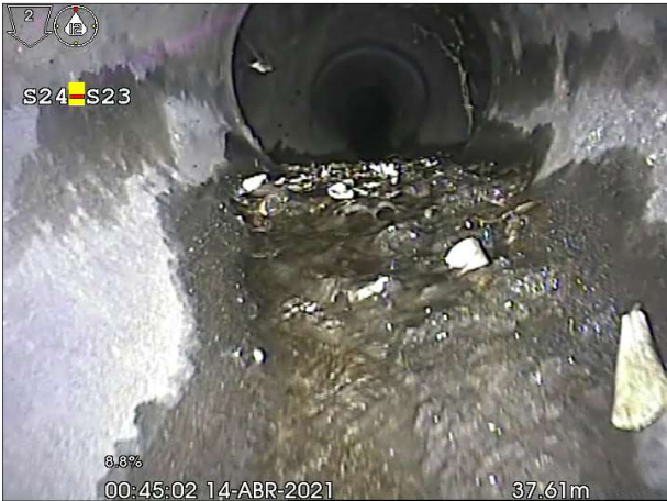
Fotografía: 84a, Nº Video: 28, 00:04:51 37,6m, Obstáculo por sedimentaciones (masa solidificada) desde 05 hasta 07 horas. Reducción de sección 1 %
