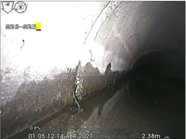
Fotografía: 92a, Nº Video: 31, 00:00:26 2,4m, Inspección interrumpida, La cámara no puede avanzar.
