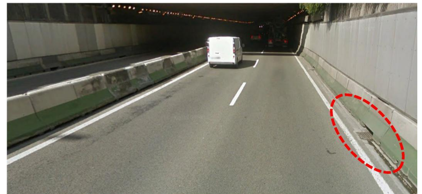
Figura 13: Arqueta en zona de trinchera
