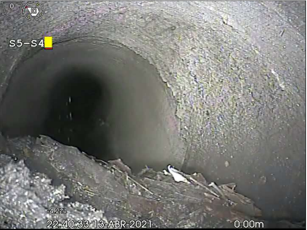
Fotografía: 245a, Nº Video: 89, 00:00:00 0m, Inicio de la inspección, Arqueta S5
