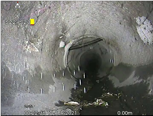
Fotografía: 74a, N° Video: 27, 00:00:00 0m, Inicio de la inspección, arqueta S22
