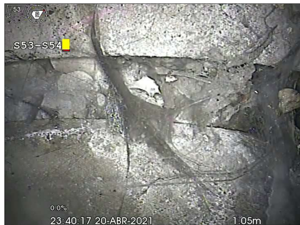
Fotografía: 161b, N° Video: 60, 00:00:07 1m, Junta abierta desde 12 hasta 12 horas
