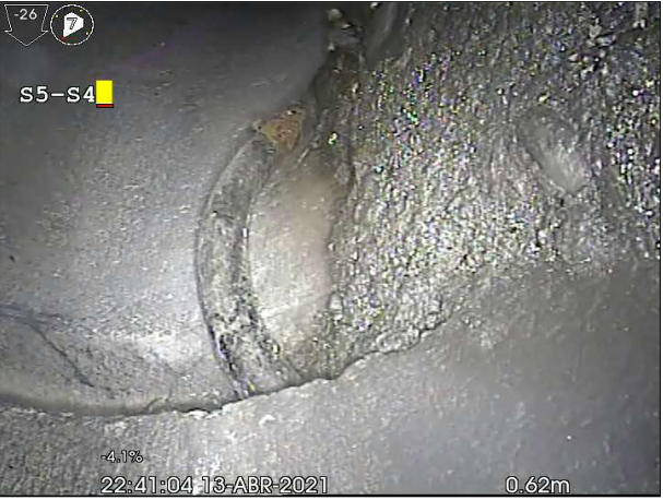
Fotografía: 246b, Nº Video: 89, 00:00:20 0,6m, Goma de junta suelta desde 03 hasta 08 horas
