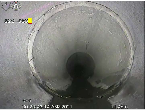
Fotografía: 76a, N° Video: 27, 00:01:04 11,5m, Junta abierta desde 12 hasta 12 horas
