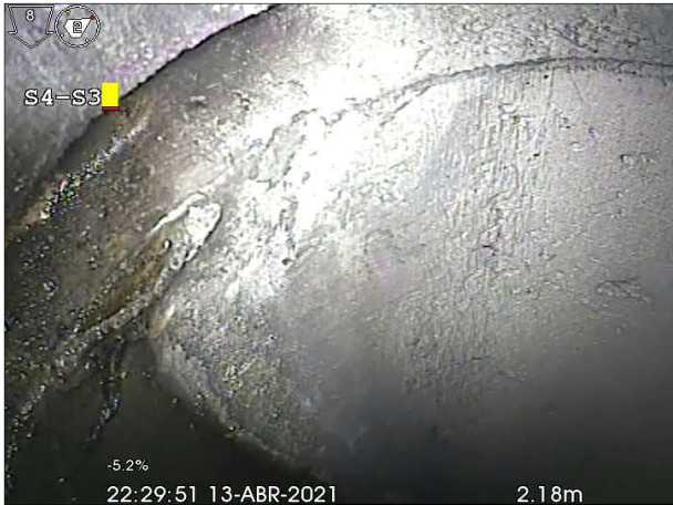
Fotografía: 17b, Nº Video: 5, 00:00:22 1,8m, Junta abierta desde 12 hasta 12 horas
