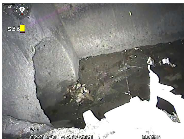
Fotografía: 129a, N° Video: 44, 00:00:00 0m, Fin de la inspección
