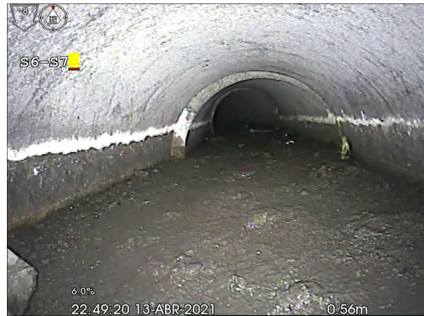
Fotografía: 32a, N° Video: 9, 00:00:06 0,5m, Gran cantidad de sedimentaciones.
