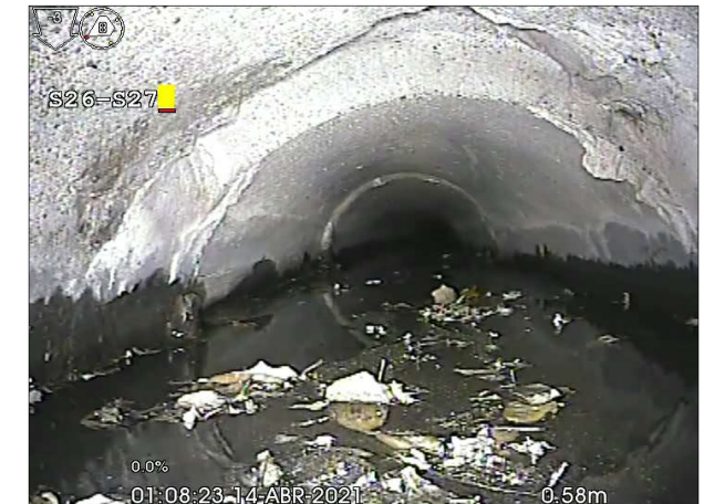
Fotografía: 94a, Nº Video: 32, 00:00:00 0,3m, Junta abierta desde 12 hasta 12 horas
