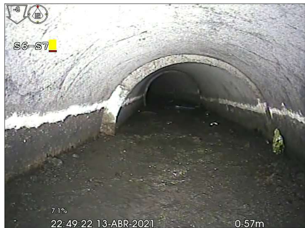
Fotografía: 33a, N° Video: 9, 00:00:09 0,6m, Junta abierta desde 12 hasta 12 horas
