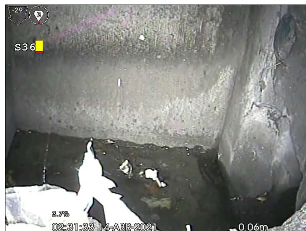
Fotografía: 128b, N° Video: 44, 00:00:00 0m, Inicio de la inspección, Arquets S36
