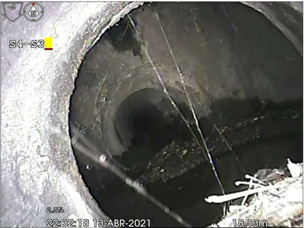
Fotografía: 23a, Nº Video: 5, 00:02:46 18,2m, Fin de la inspección, Arqueta S3
