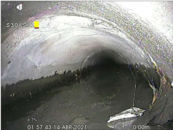
Fotografía: 116a, Nº Video: 38, 00:00:00 0m, Inicio de la inspección, Arqueta S30
