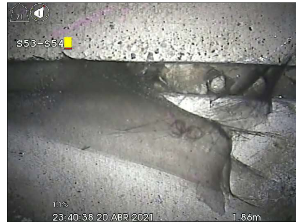
Fotografía: 162b, N° Video: 60, 00:00:35 2m, Junta abierta desde 12 hasta 12 horas
