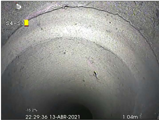
Fotografía: 16b, Nº Video: 5, 00:00:11 0,5m, Junta abierta desde 12 hasta 12 horas
