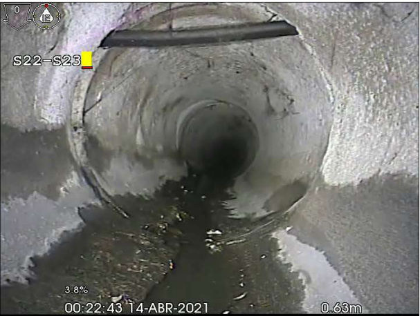
Fotografía: 75a, N° Video: 27, 00:00:08 0,7m, Goma de junta suelta desde 10 hasta 01 horas
