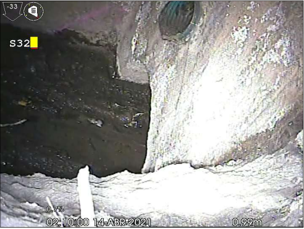
Fotografía: 121b, Nº Video: 40, 00:00:00 0m, Fin de la inspección
