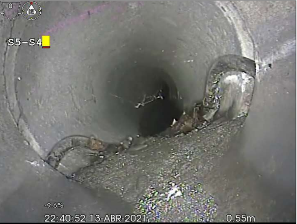
Fotografía: 246a, Nº Video: 89, 00:00:20 0,6m, Goma de junta suelta desde 03 hasta 08 horas
