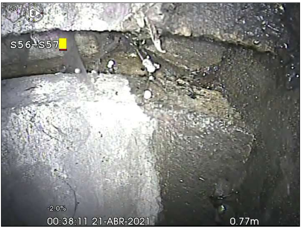
Fotografía: 187b, N° Video: 67, 00:00:07 0,3m, Junta abierta desde 12 hasta 12 horas
