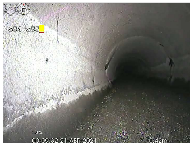
Fotografía: 172a, N° Video: 63, 00:00:00 0m, Inicio de la inspección, Arqueta S54
