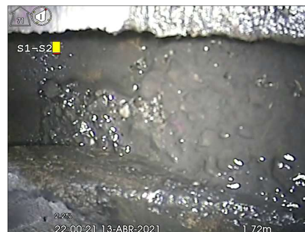
Fotografía: 3b, N° Video: 1, 00:00:46 1,4m, Junta abierta desde 12 hasta 12 horas
