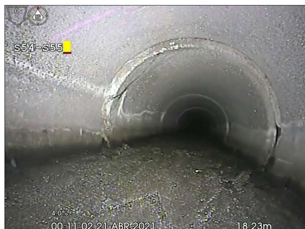
Fotografía: 174a, N° Video: 63, 00:01:29 18,7m, Junta abierta desde 12 hasta 12 horas
