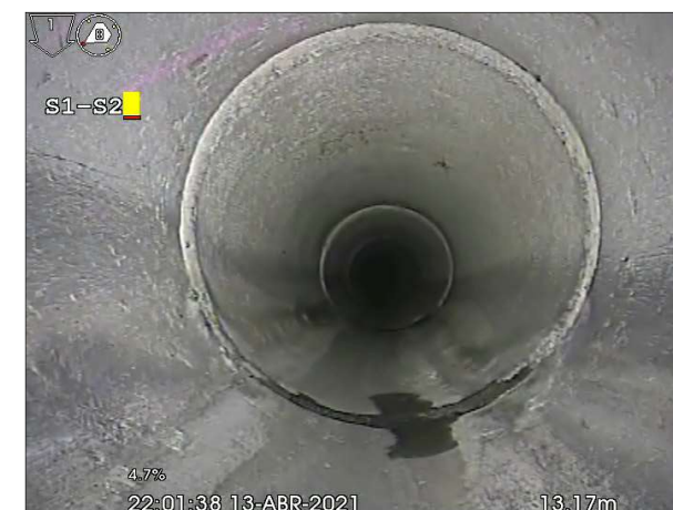
Fotografía: 4a, N° Video: 1, 00:02:20 13,2m, Junta abierta desde 12 hasta 12 horas
