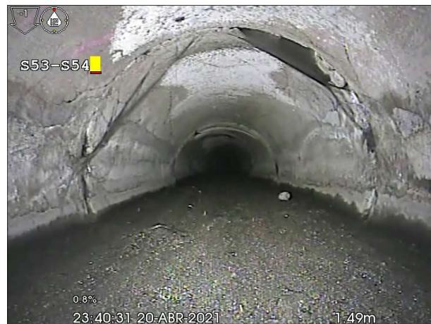
Fotografía: 162a, N° Video: 60, 00:00:35 2m, Junta abierta desde 12 hasta 12 horas
