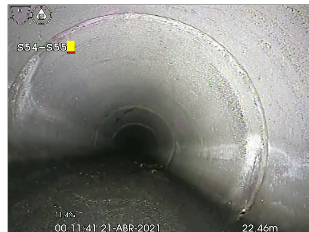
Fotografía: 175a, Nº Video: 63, 00:02:20 22,4m, Inspección interrumpida, La cámara no puede avanzar.
