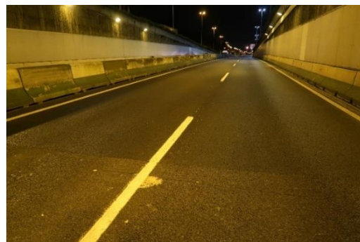
Figura 4 - PK 12+420 (Bilbao-Getxo): Cambio de Firme
