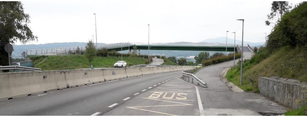
FIGURA 3. Vista de la Pasarela Egirleta. Desde la parada de bus de la margen derecha.
