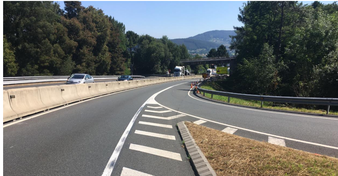
FIGURA 4. Vista de la segunda parte del tramo de proyecto.
