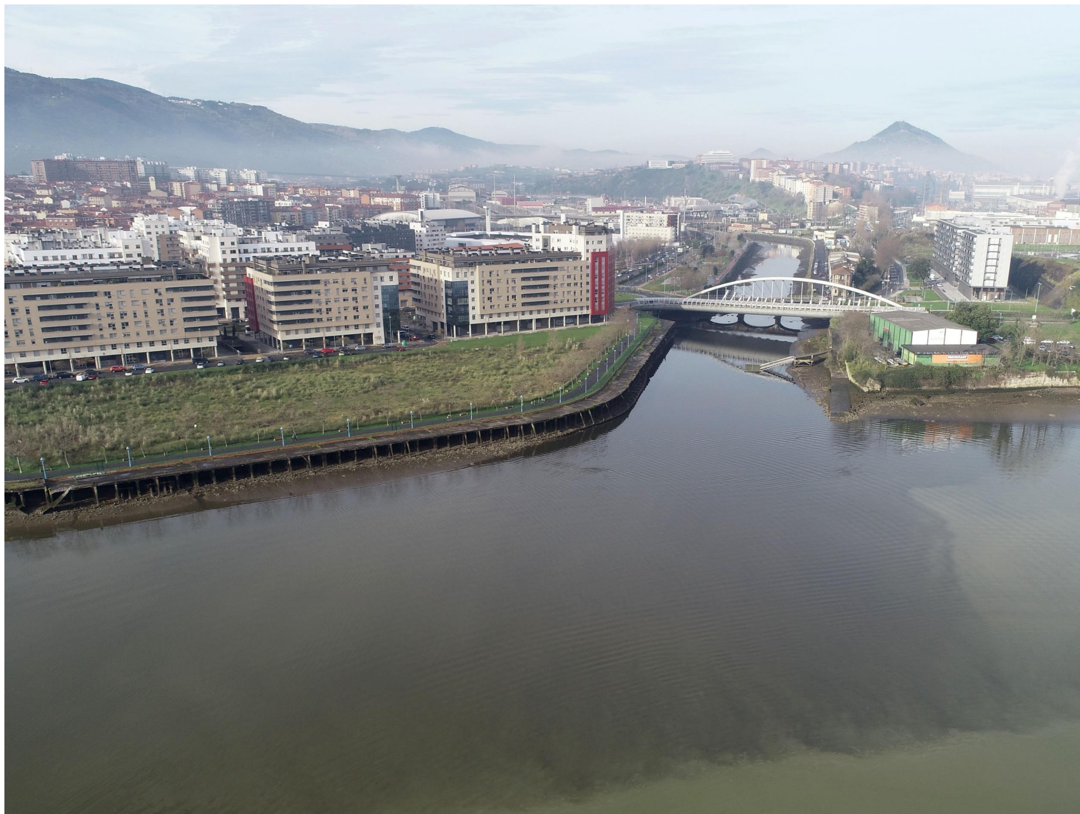
Imagen 1: Vista actual de la margen de Barakaldo.
