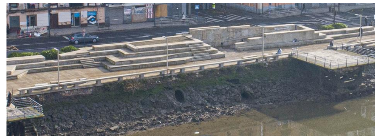
Proyecto de Construcción de Puente peatonal y ciclable entre Barakaldo y Erandio
