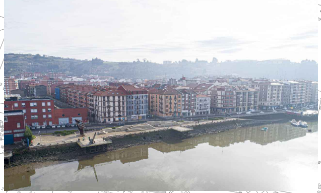
Alivio interceptor y arqueta de rotura de carga
