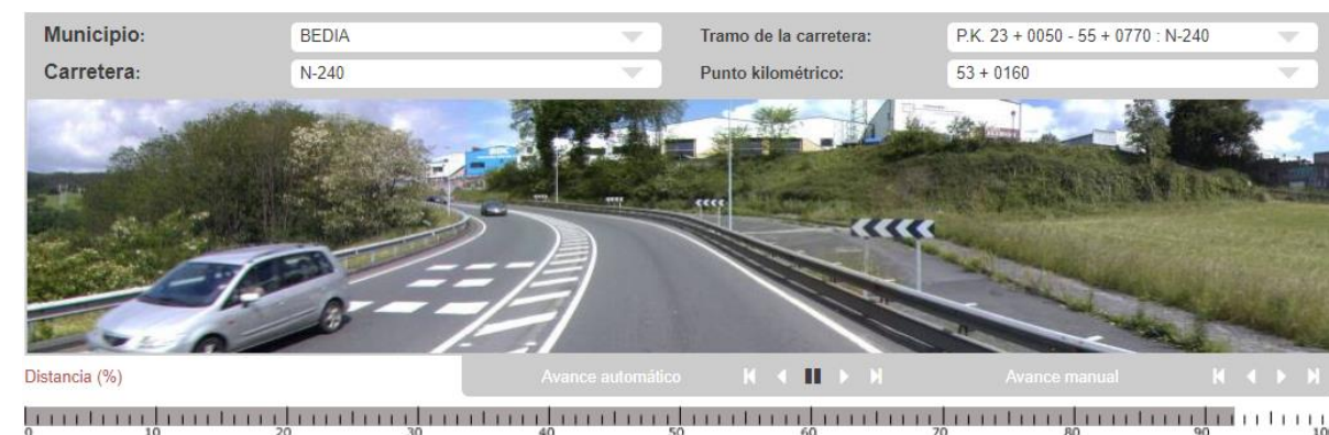
Imagen 58: Tramo abandonado de plataforma en la N-240. Fuente: Visor del “Catalogo Visual de Carreteras de la DFB” http://apli.bizkaia.net/apps/danok/ghvc/index.html
