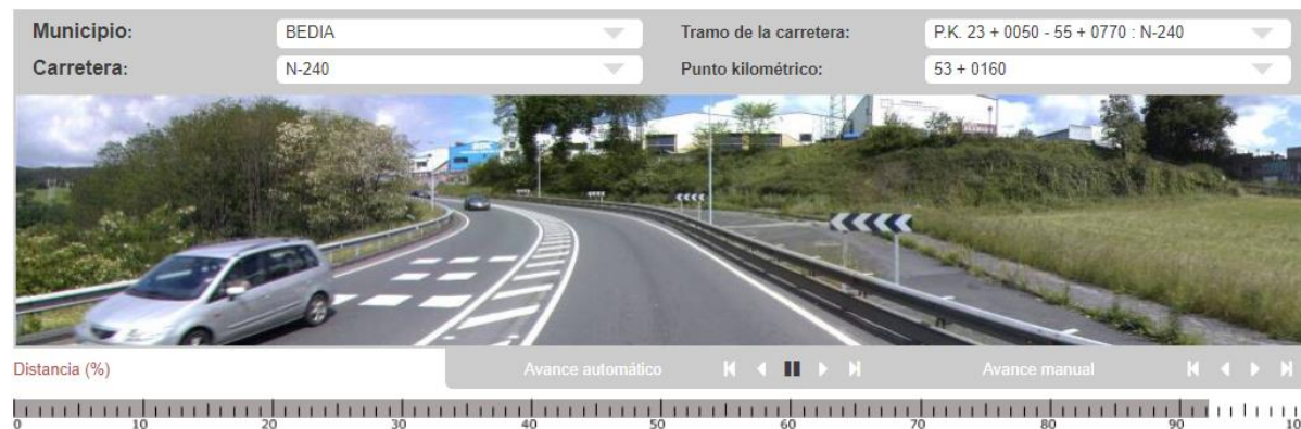
Imagen 2: Tramo abandonado de plataforma en la N-240. Fuente: Visor del “Catalogo Visual de Carreteras de la DFB” http://apli.bizkaia.net/apps/danok/ghvc/index.html
