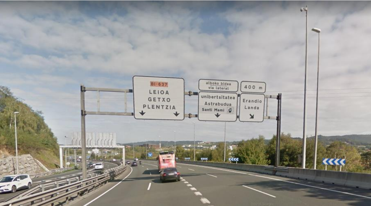
Ilustración 22 - Tramos previo a la bifurcación de la Avanzada en Erandio Goikoa (BI-637)
