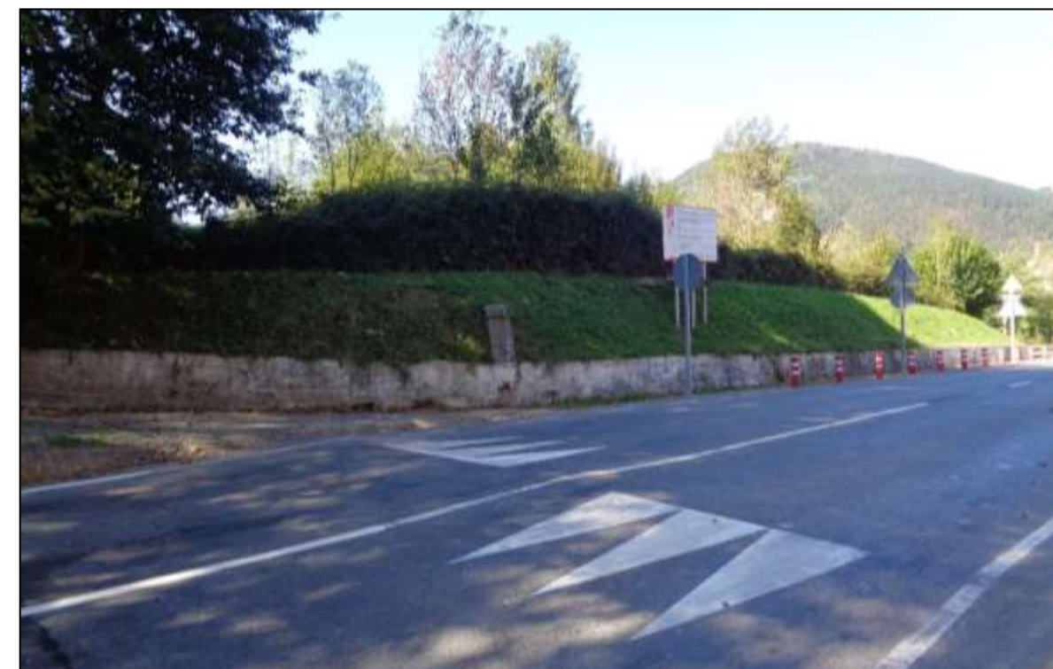
Fotografía 10d. Vista del muro y talud existentes en el tramo afectado de la finca Munibe
