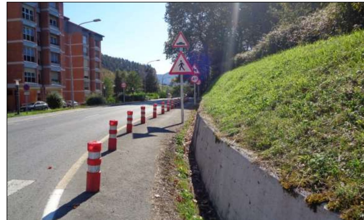
Fotografía 10c. Vista del muro y talud existentes en la ubicación de la rotonda proyectada
