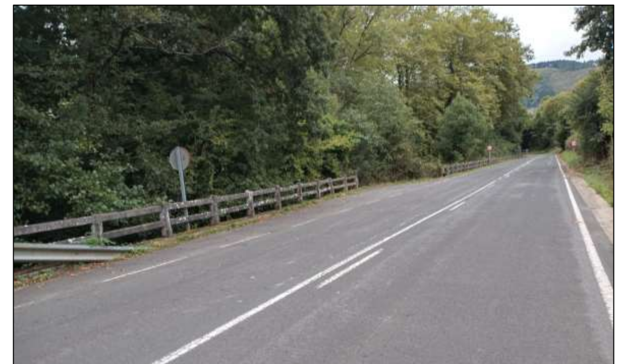
Fotografía 12a. Tramo de la carretera BI-4404 a reponer
