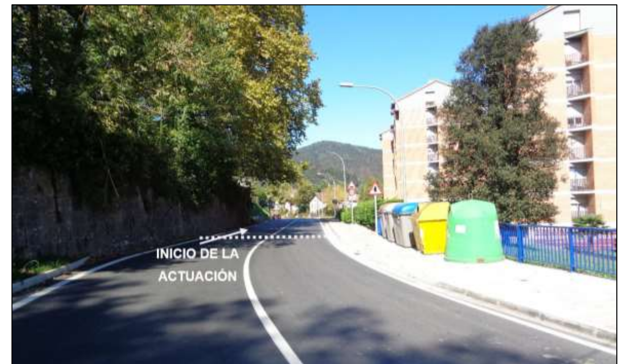
Fotografía 10h. Vista de las viviendas de Txoribenta y el cierre de la finca Munibe desde la BI-2636
