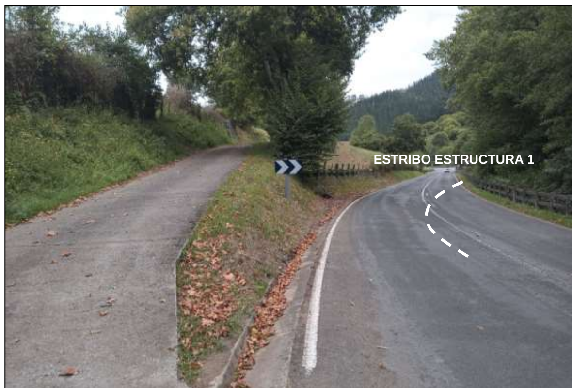
Fotografía 12c. Tramo de la carretera BI-4404 a reponer
