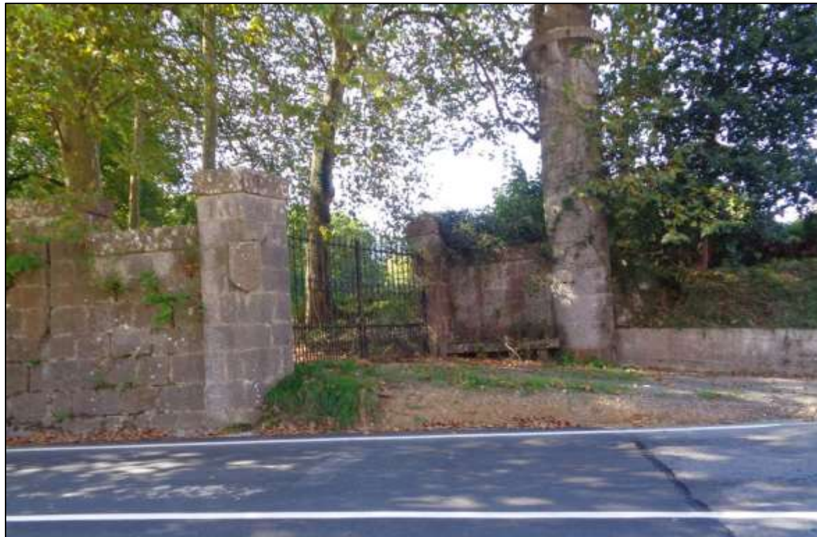
Fotografía 10e. Vista de la puerta de acceso existente en el tramo afectado de la finca Munibe
