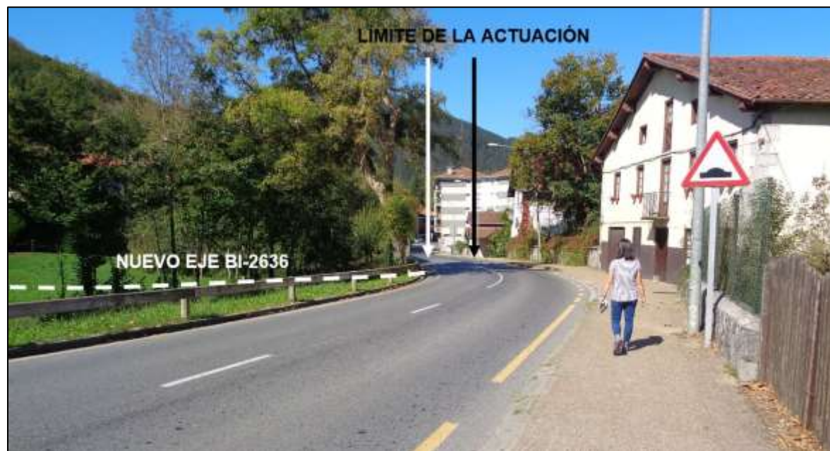
Fotografía 9a. Tramo actual de la BI-2636 en sentido Markina desde la zona de Txoribenta
