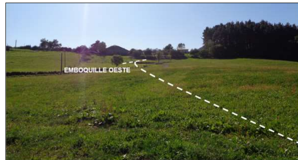
Fotografía 5a. Vista de la localización del emboquille oeste del túnel y del tramo en trinchera del tronco anterior a este
