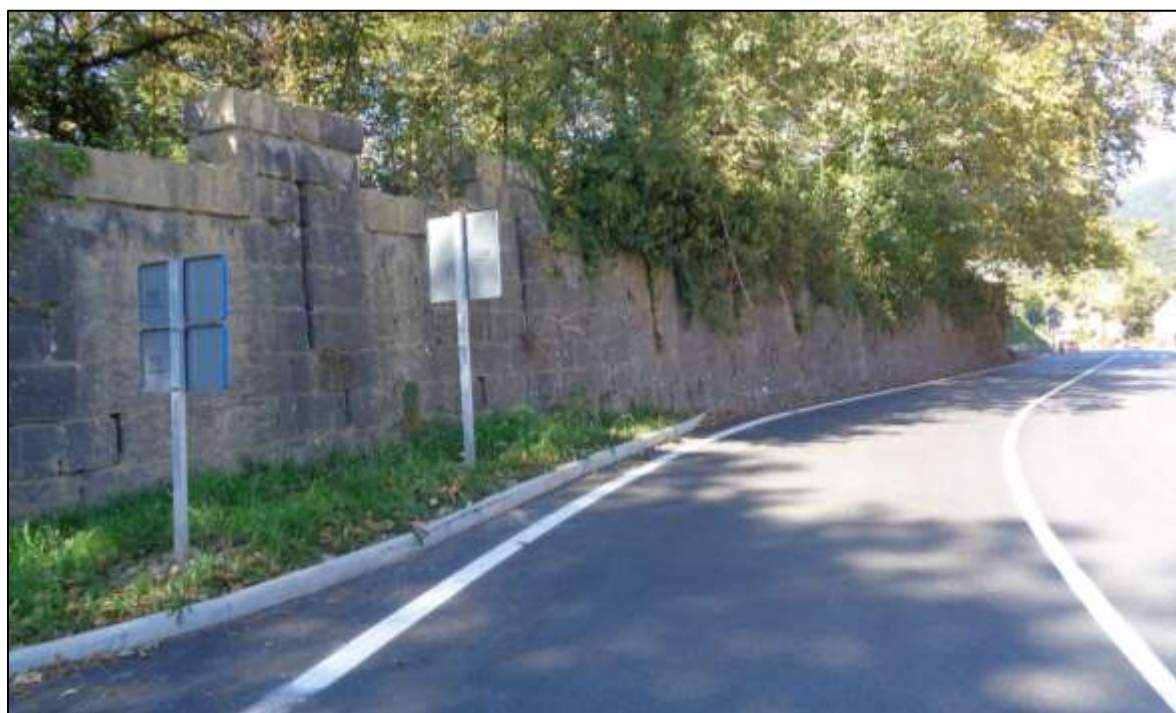
Fotografía 10f. Vista del muro de mampostería existente en el tramo afectado de la finca Munibe
