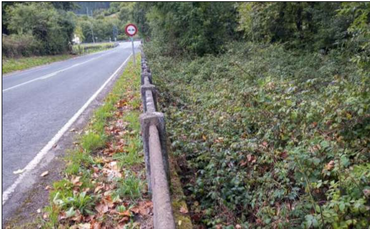
Fotografía 12b. Tramo de la carretera BI-4404 a reponer
