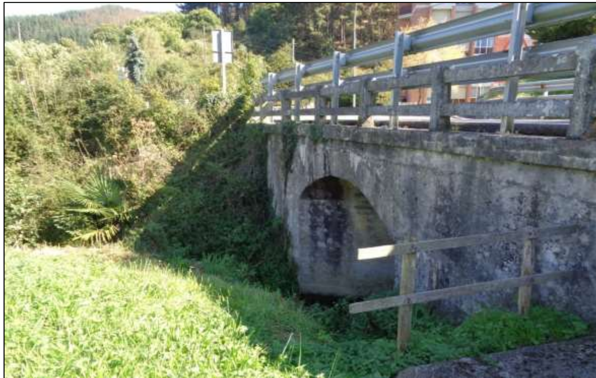
Fotografía 8c. Estructura existente en la BI-4404 para salvar el arroyo Muniberreka en la ubicación de la nueva rotonda proyectada, que será demolida
