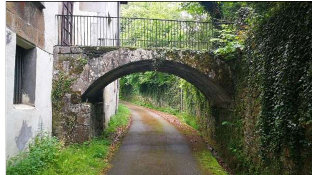
Fotografía 11c. Arco existente sobre el camino, que limita el gálibo e impide el paso de determinados vehículos
