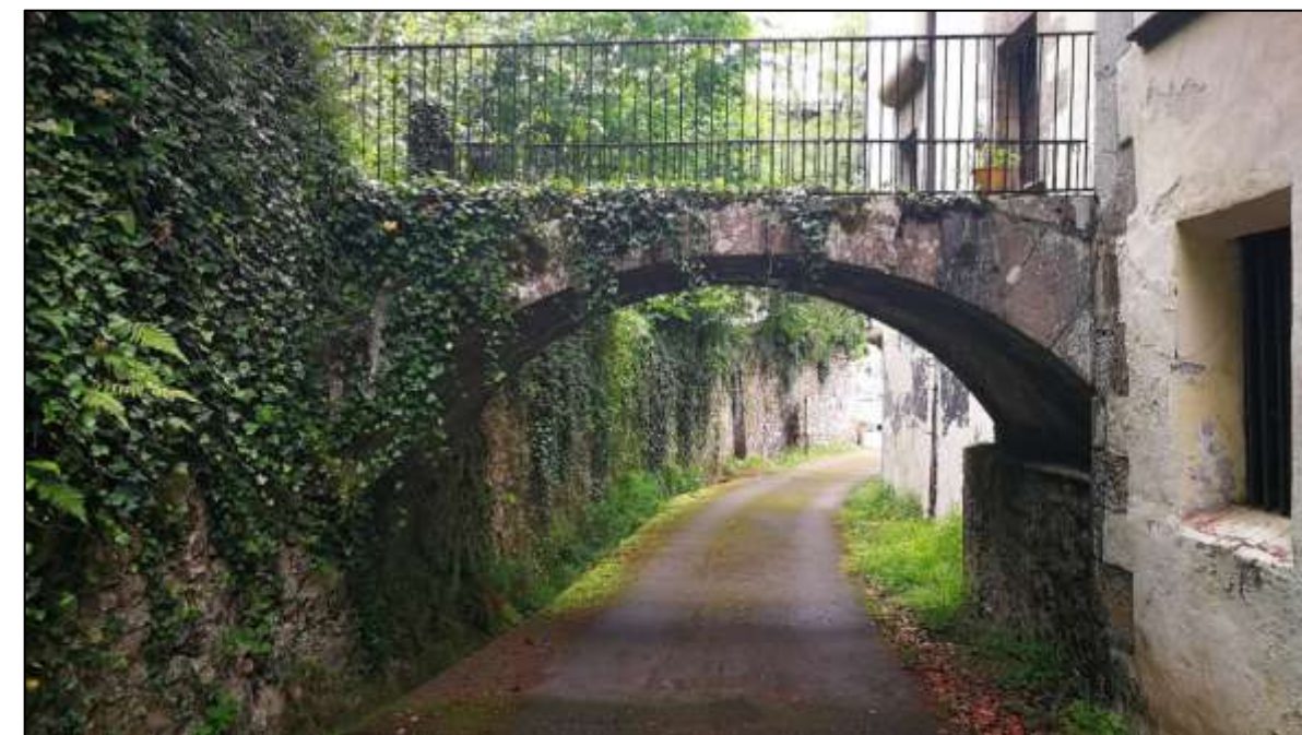
Fotografía 11d. Arco existente sobre el camino, que limita el gálibo e impide el paso de determinados vehículos
