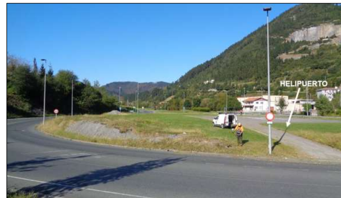
Fotografía 1a. Conexión con la BI-633 en la zona del helipuerto
