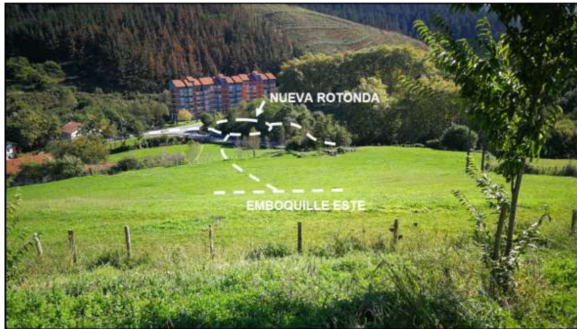
Fotografía 7a. Vista del emboquille este y tramo final desde la ETAP Iparragirre
