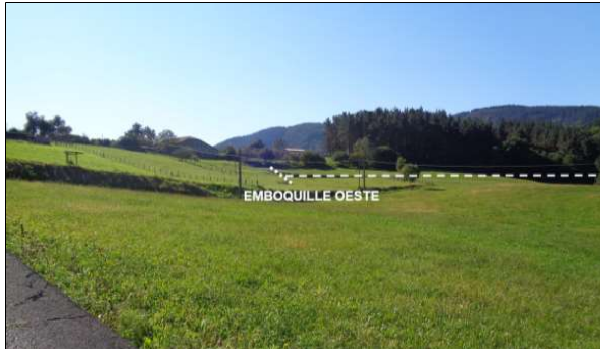
Fotografía 5b. Vista de la localización del emboquille oeste del túnel y del tramo en trinchera anterior a este
