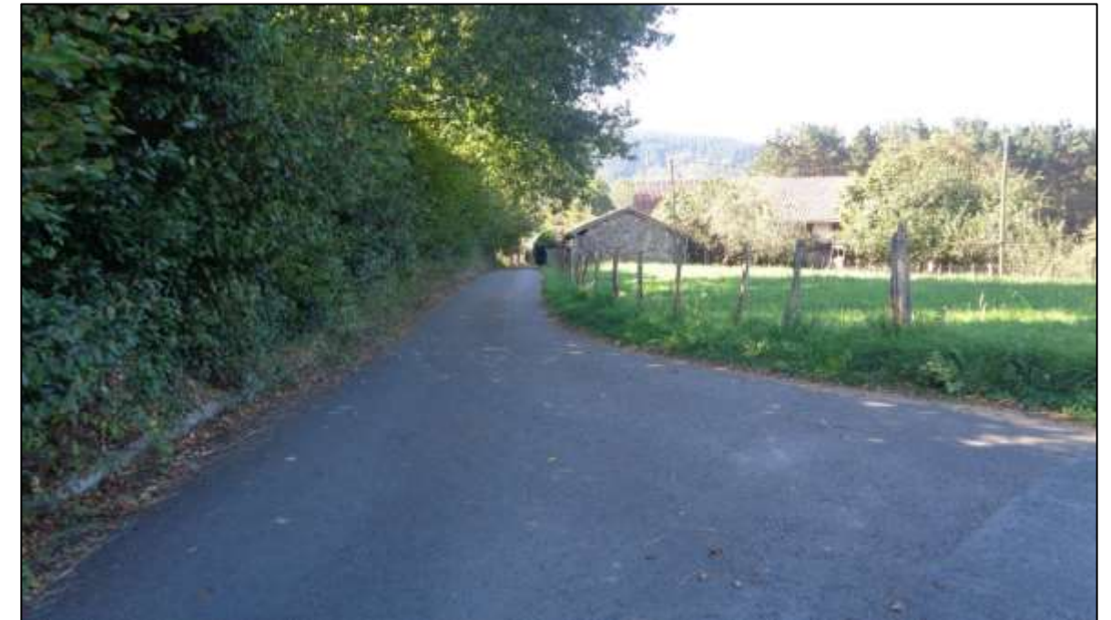
Fotografía 6a. Vista del caserío existente en el lado derecho de la traza sobre el tramo en túnel (PK 0+520)
