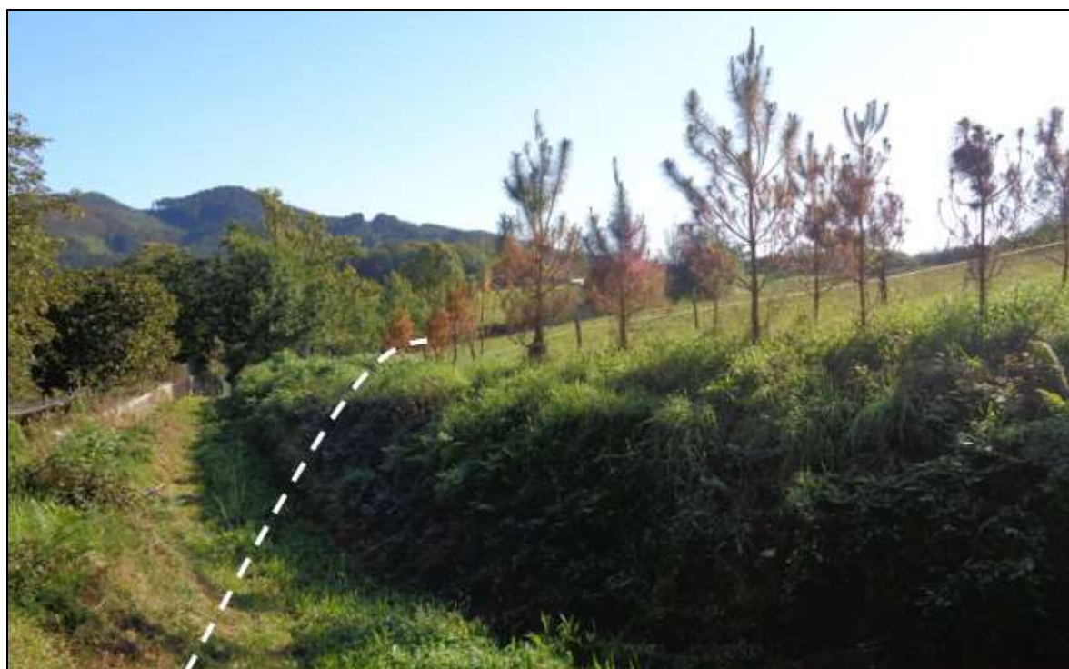
Fotografía 3c. Vista del tramo en trinchera del tronco desde el PK 0+160 hacia Etxebarria
