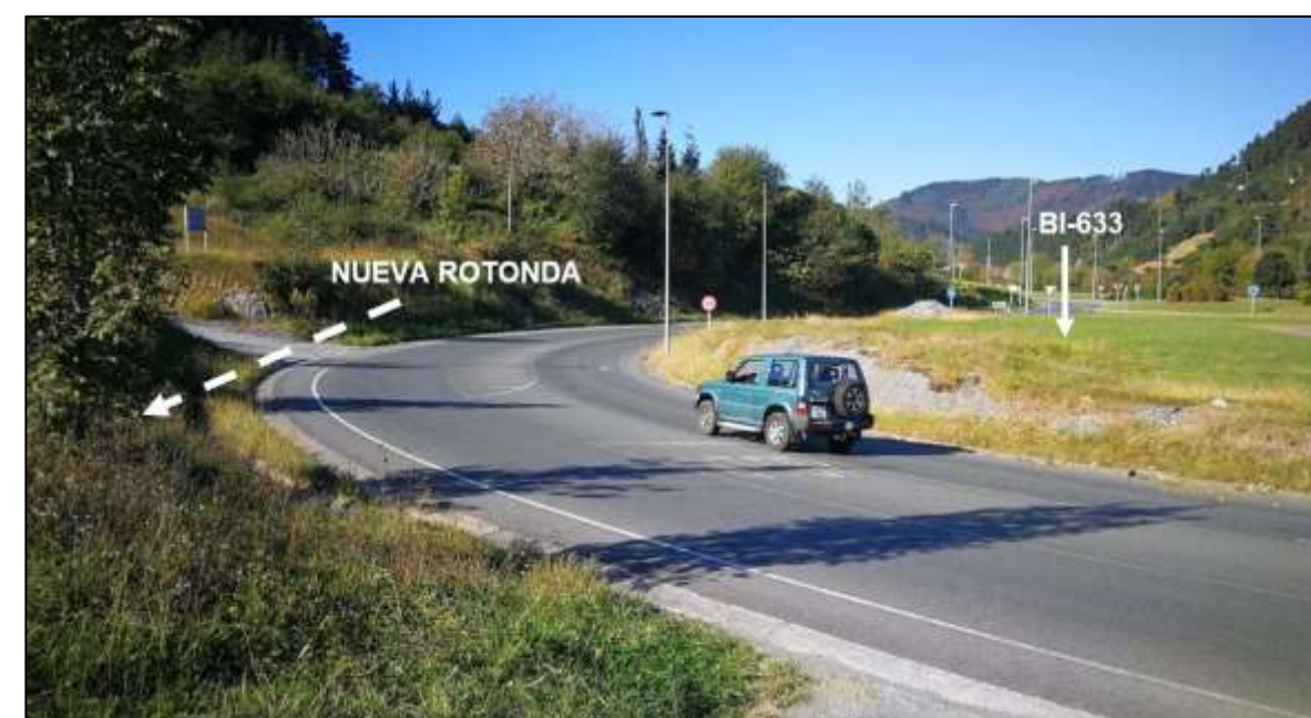
Fotografía 1b. Conexión con la BI-633 en la zona del helipuerto
