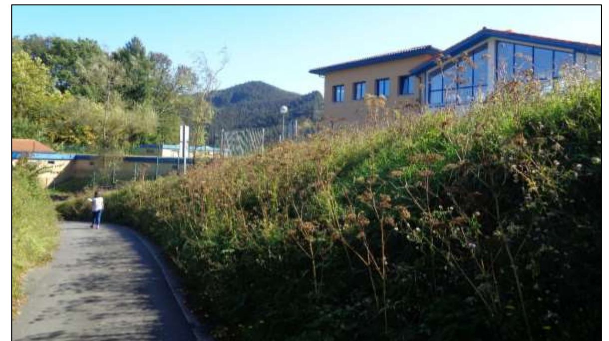
Fotografía 6b. Vista de la ETAP de Iparragirre, en el lado izquierdo de la traza sobre el tramo en túnel (PK 0+630)
