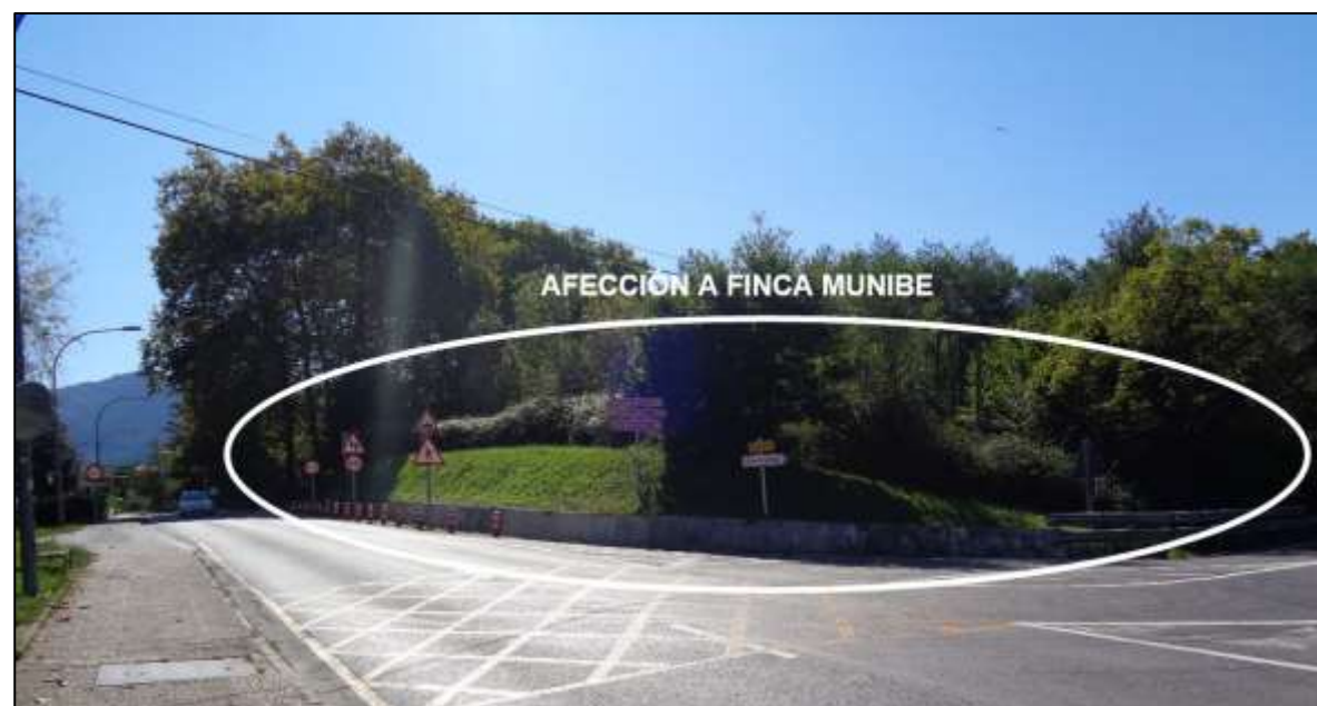
Fotografía 10b. Afección a la finca Munibe por el nuevo trazado de la BI-2636 en su entronque con la rotonda proyectada
