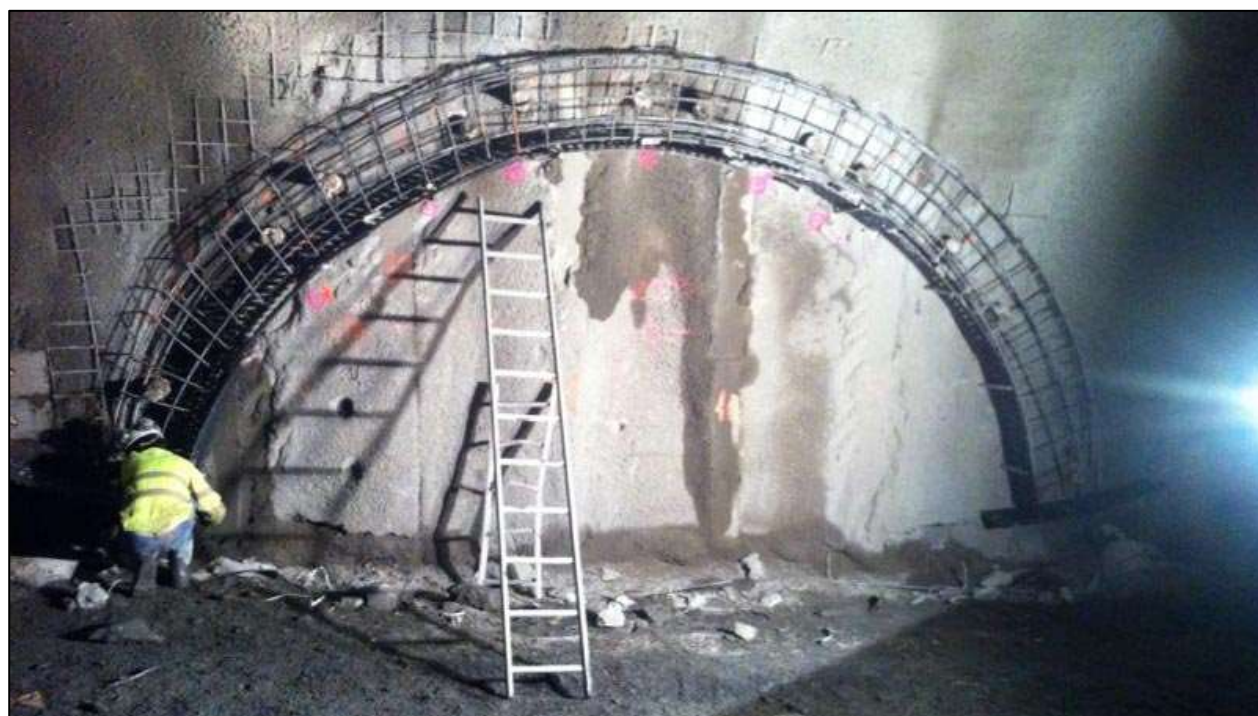
Paraguas de micropilotes y viga zuncho de atado
