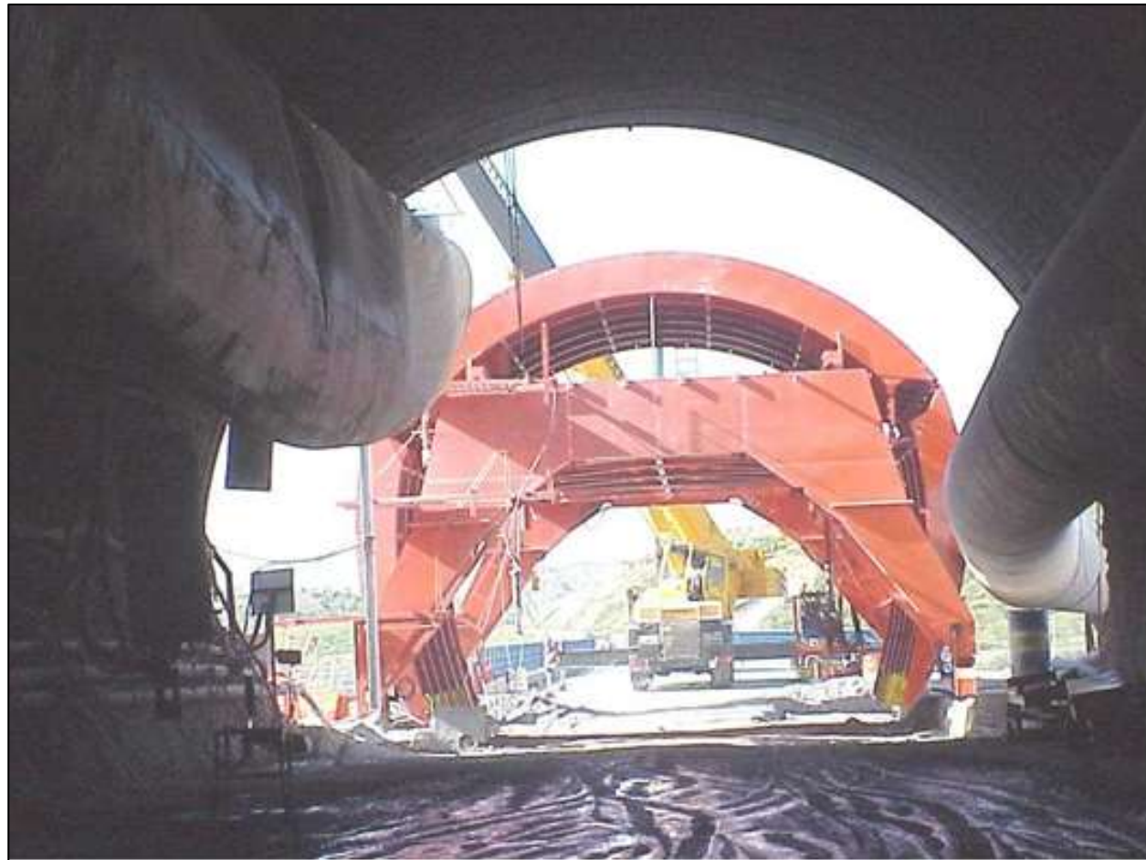
Carro de encofrado del revestimiento
