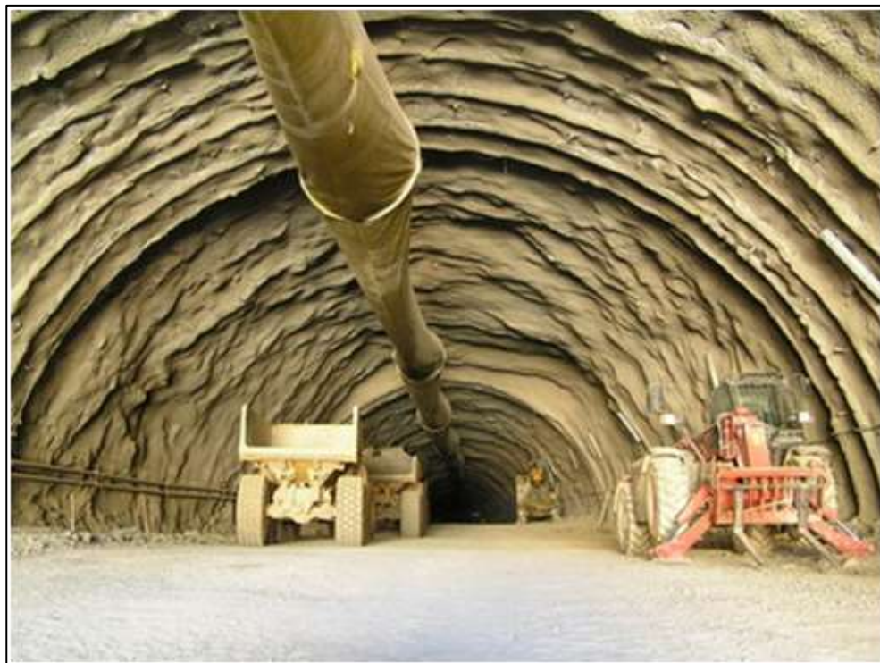
Fase de avance en excavación con sostenimiento colocado
