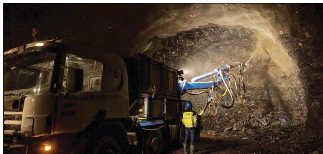
Equipo de proyección de hormigón colocando la capa de sellado
