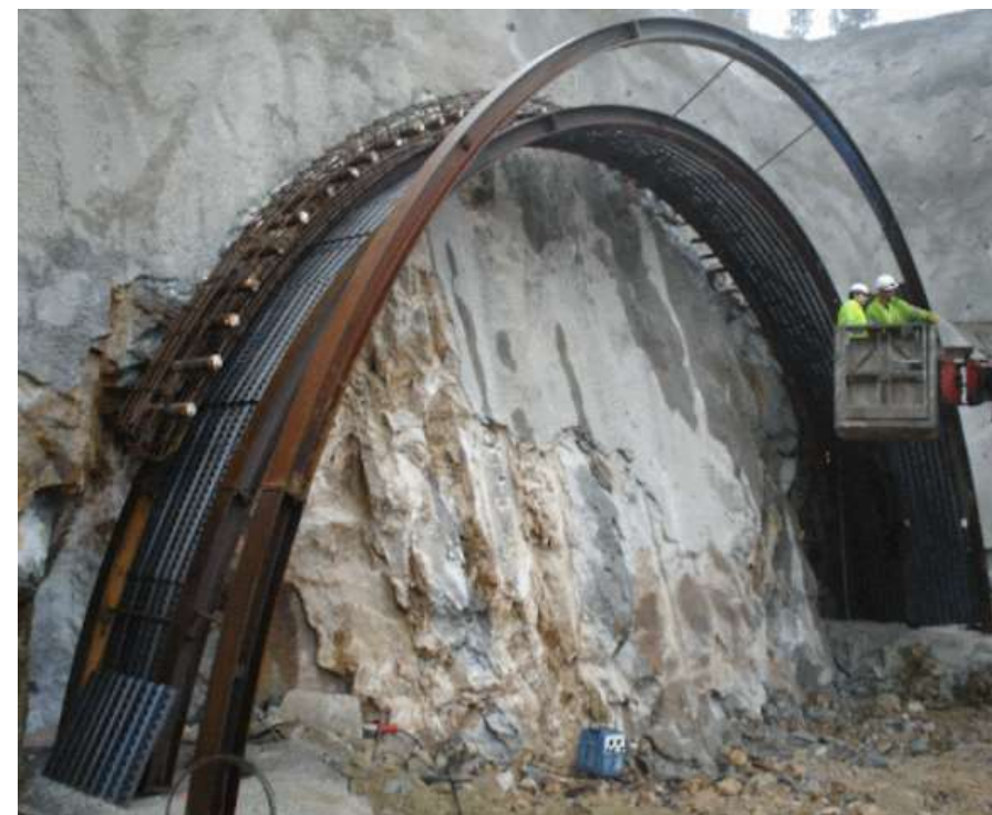
Montaje de los elementos metálicos de la visera
