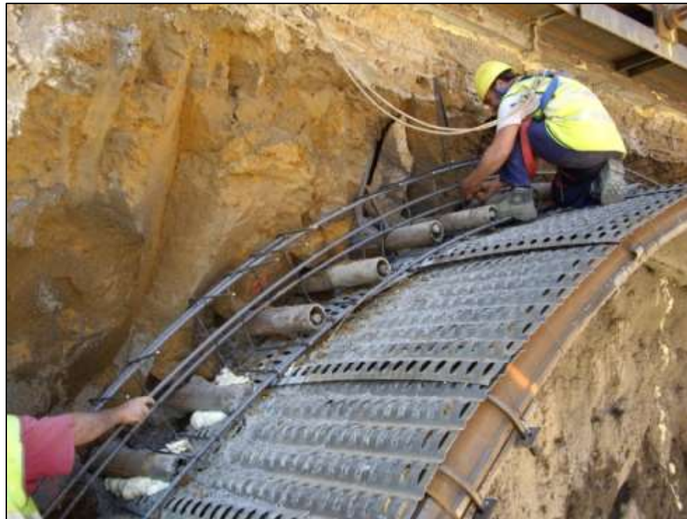
Colocación de visera de protección en emboquille
