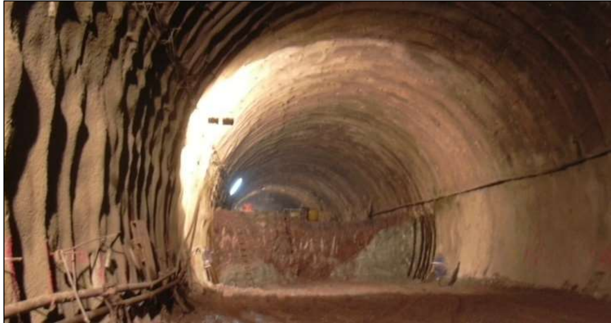
Vista del frente de excavación de la destroza de un túnel
