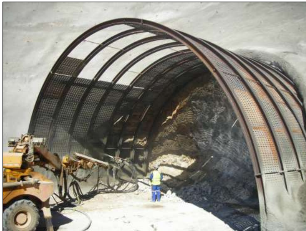
Terminación de la visera de protección
