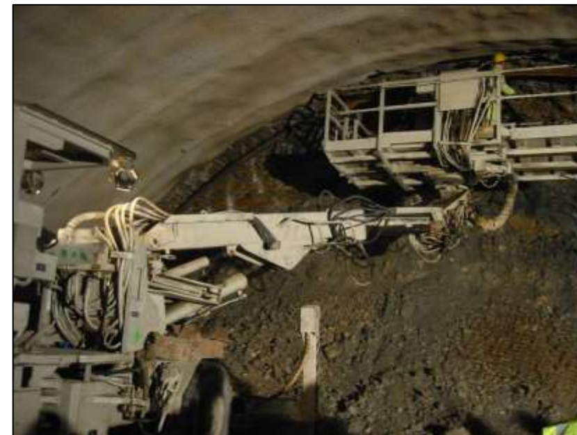
Plataforma de elevación hidráulica para colocación de cerchas y mallazo
