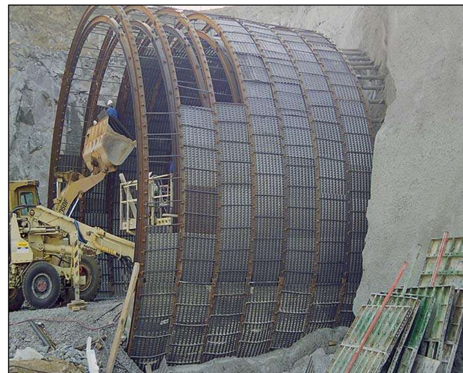
Montaje de Chapa Bernold
