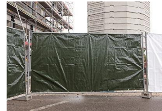
Ilustración 2: Valla de obra con malla verde y bases de hormigón.
