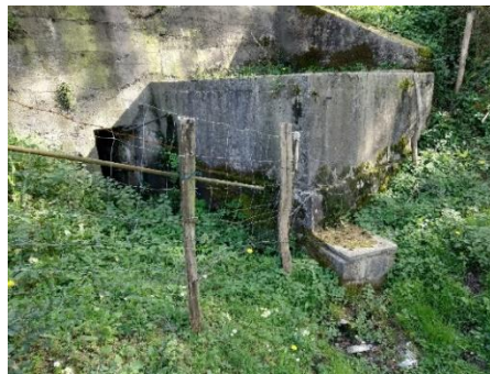
Depósito adosado al muro de la carretera
