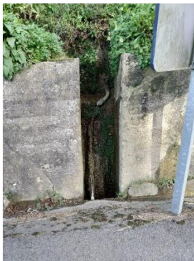
Punto de captación en la margen derecha de la carretera
