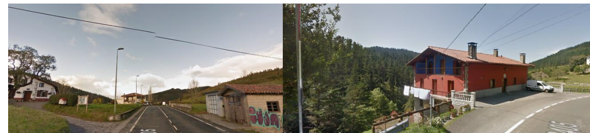
Conjunto de edificios pegados a la carretera en el alto de Millai. Edificio junto al trazado actual en el pk 59+100.
