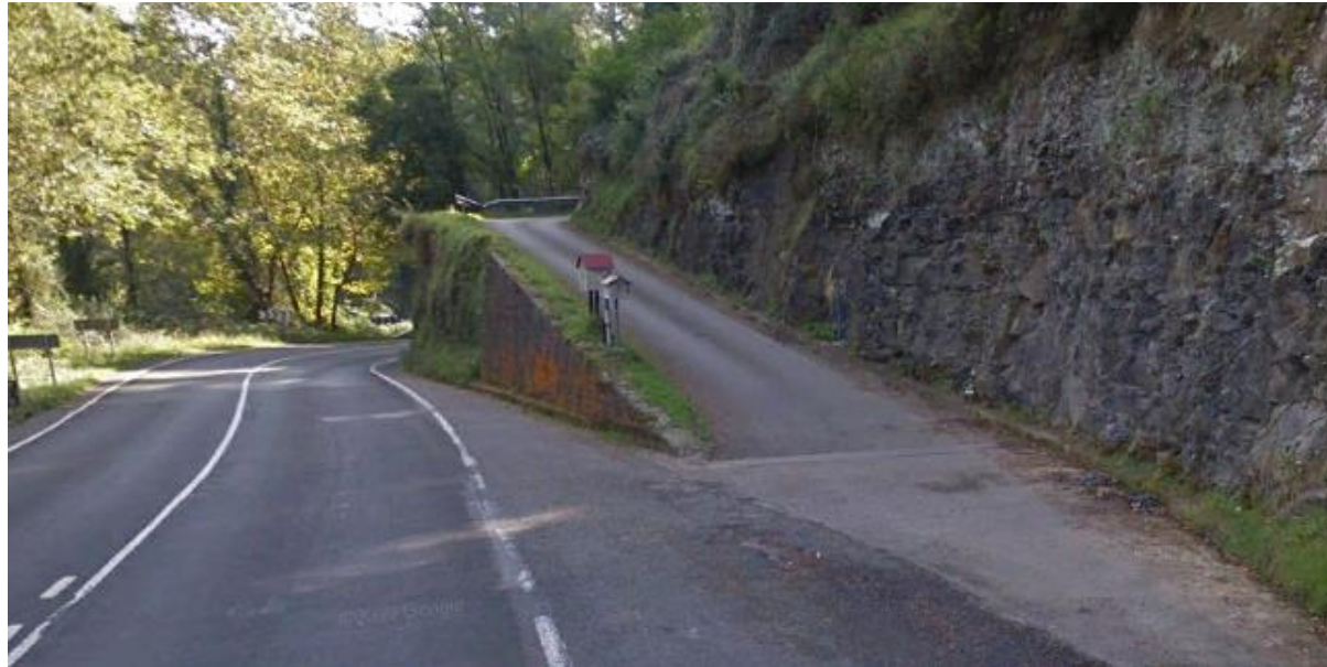
Acceso del camino a la Ermita de San Antolín, PK 58+670
