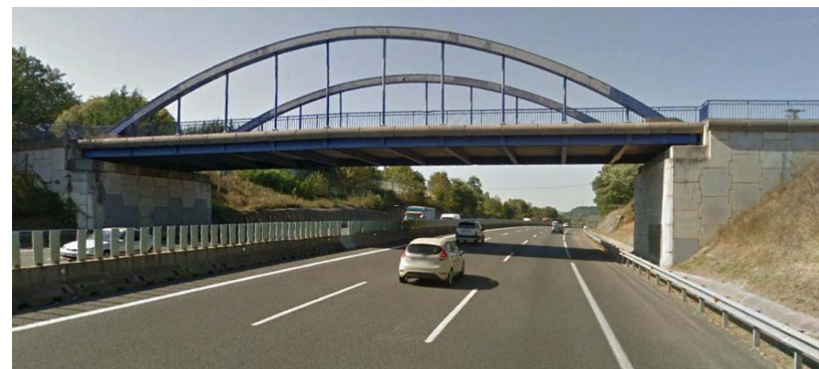
Figura 3. Paso superior existente en el km 94,2 de la AP-8
