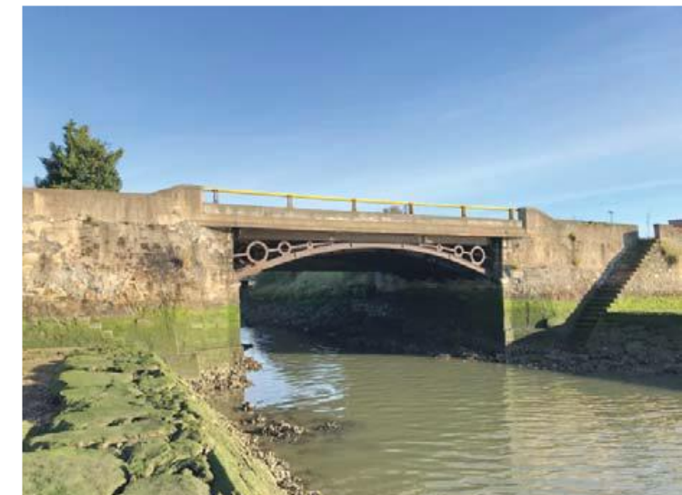
Puente de Udondo. reconstruido en 1876 en el camino se sirga.
