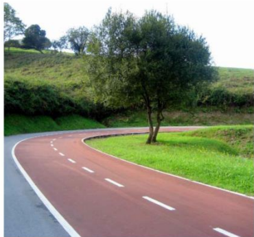
Mezcla bituminosa AC-8 SURF D (D-8) con árido siderúrgico reciclado y pigmento de color rojo.
