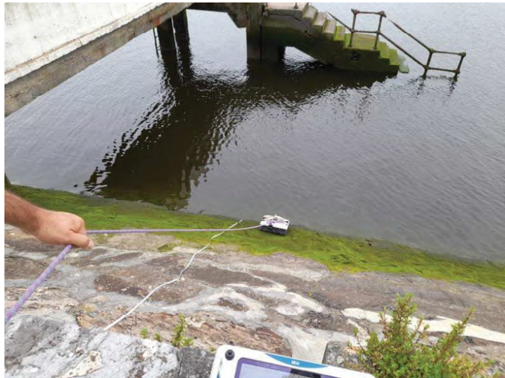
Figura 4. Imagen de la toma de datos con la antena de 450 MHz, en uno de los puntos de estudio del muro.
