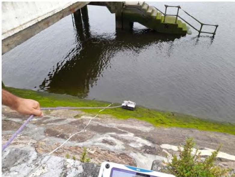
Ilustración 5: Ejecución de perfil transversal por paramento del muro existente
