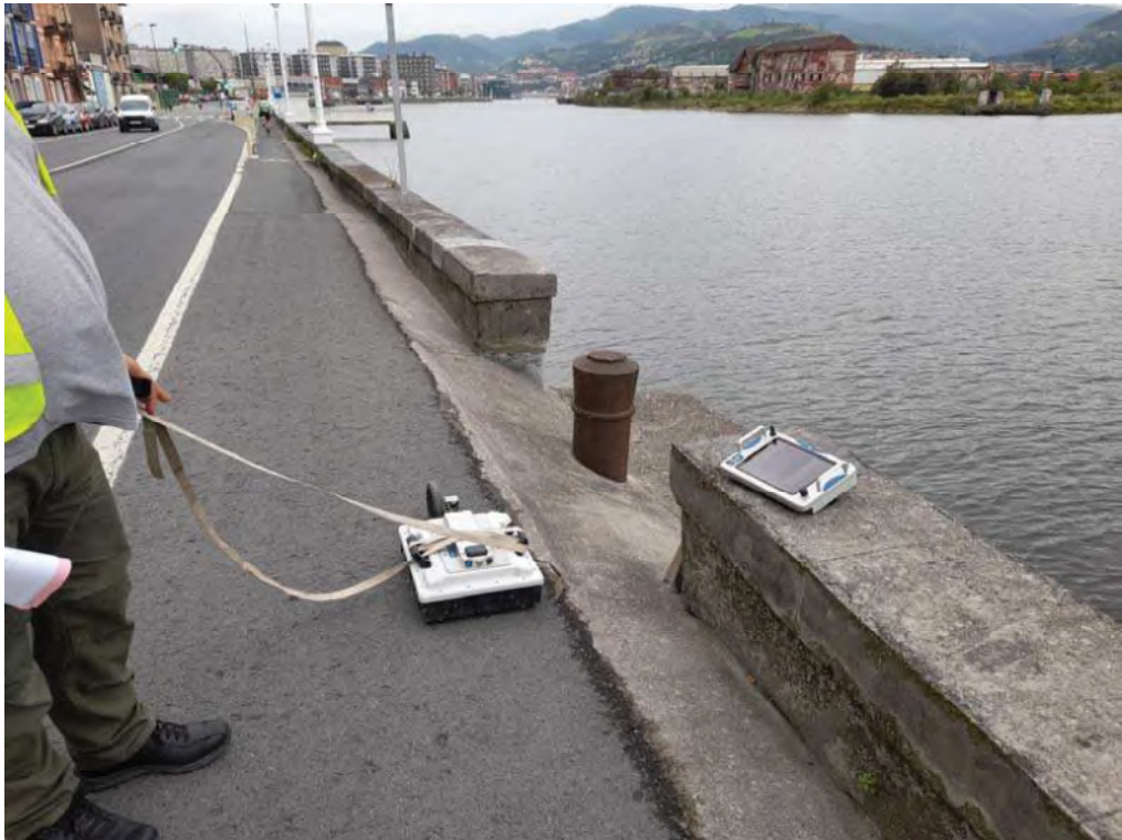
Figura 3. Imagen de la toma de datos con la antena de 450 MHz, en la calzada adyacente al muro.
