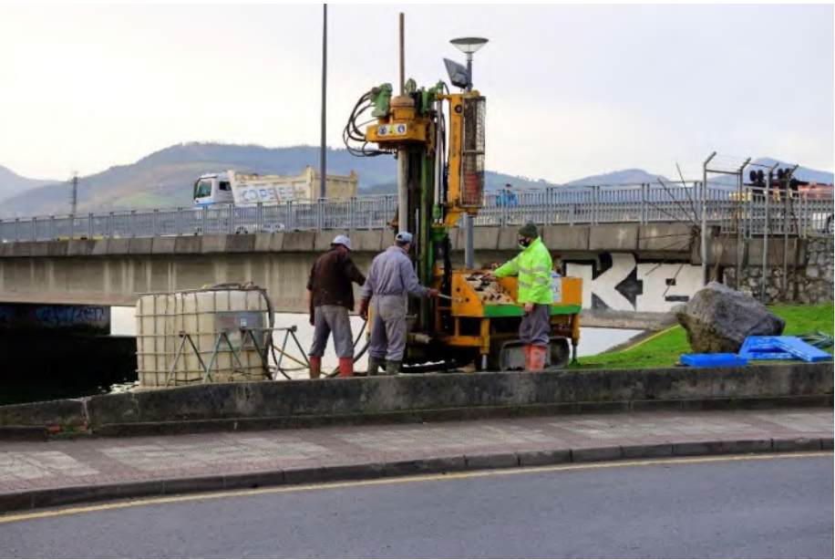
Ilustración 4: Ejecución Sondeo SBEL-3
