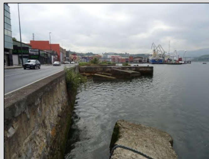
Planchada nº2. Vista hacia Bilbao
