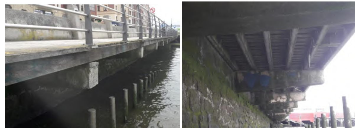
Estado actual voladizo existente
