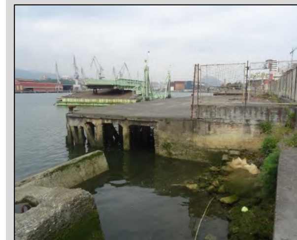
Planchada nº3. Vista hacia Getxo
