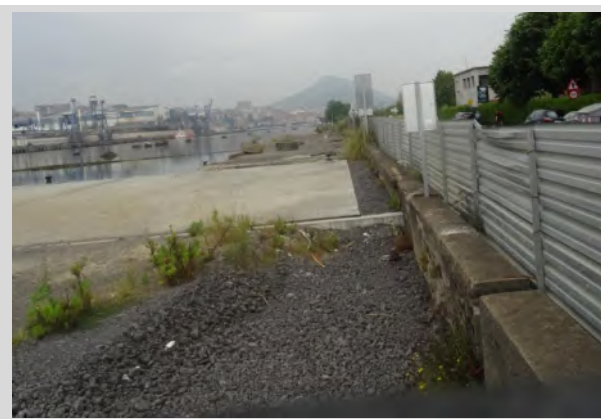
Planchada nº5. Vista hacia Getxo
