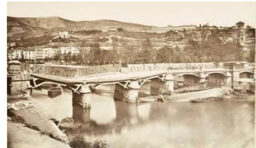
Imagen del puente de Isabel II dañado tras la socavación de las pilas de 1875
