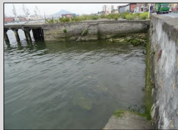
Planchada nº1. Vista hacia Getxo
