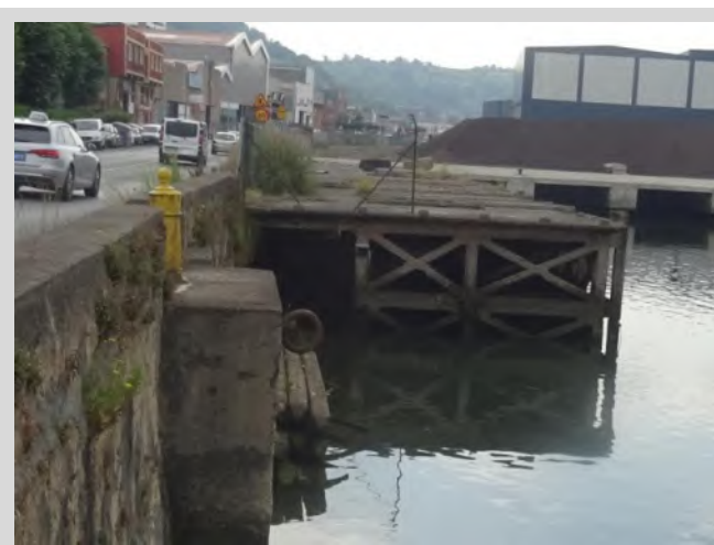
Planchada nº6. Vista hacia Bilbao
