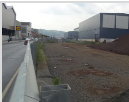
Planchada nº6. Vista hacia Bilbao
