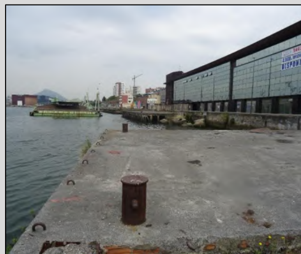
Planchada nº2. Vista hacia Getxo
