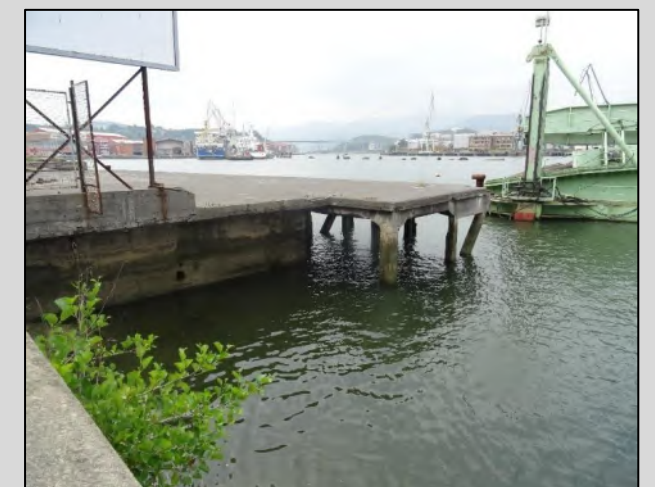
Planchada nº3. Vista hacia Bilbao
