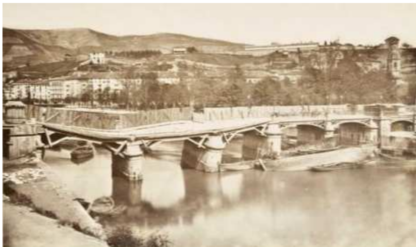
Imagen del puente de Isabel II dañado tras la socavación de las pilas de 1875
