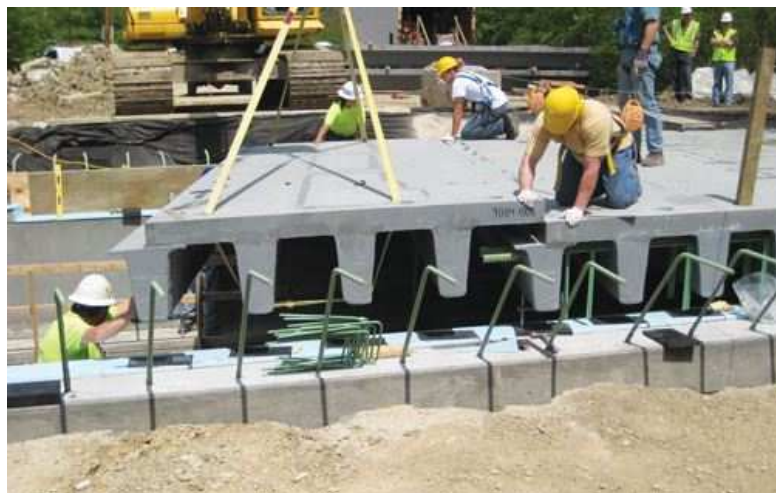
Ejemplo de prefabricación completa de tablero con materiales compuestos.
