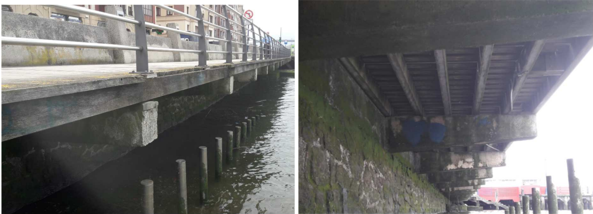
Estado actual voladizo existente
