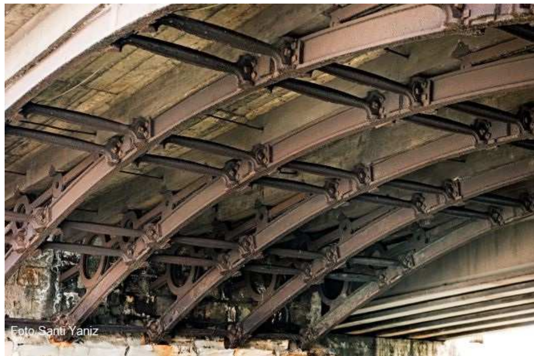
Puente de Udondo. Vista del intradós
