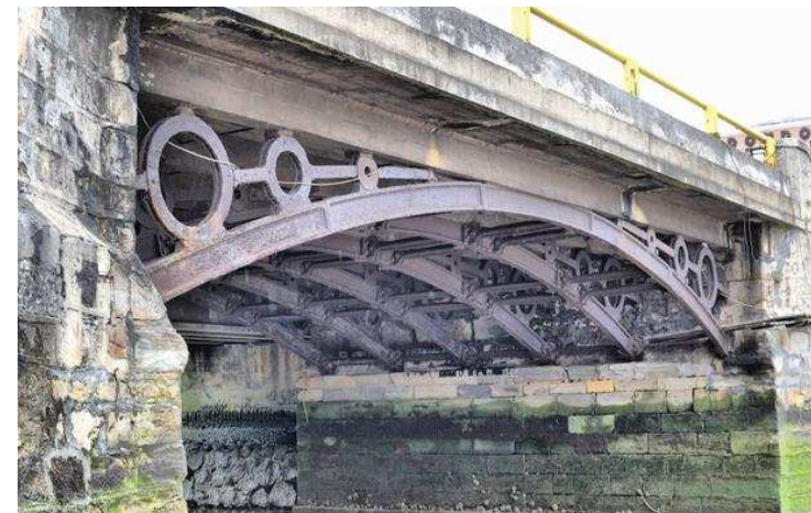
Puente de Udondo. Vista lateral desde las escaleras de acceso al borde de la ría
