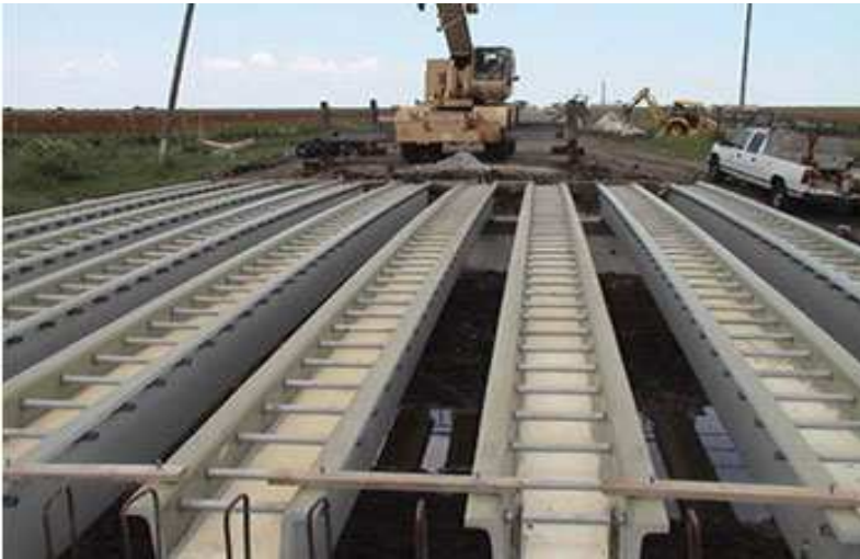
Vigas de CFRP montadas para un tablero de puente de carretera
