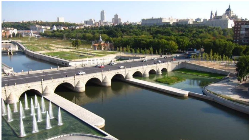
Puente de Segovia sobre el Manzanares. Madrid.
