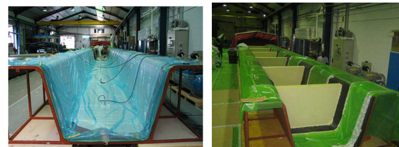
Fabricación de vigas de CFRP
