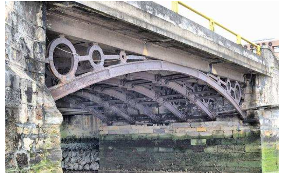
Puente de Udondo. Vista desde la ría
