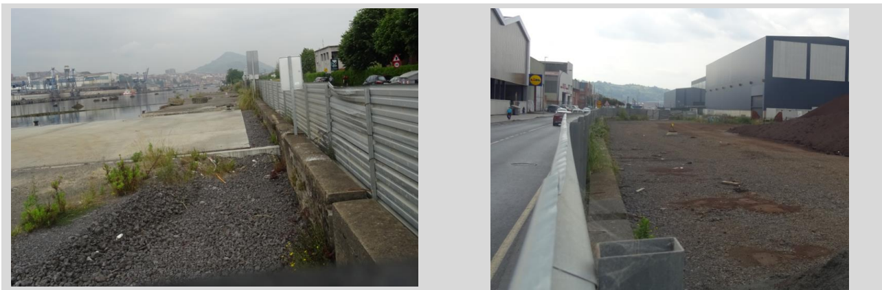
Planchada nº5. Vista hacia Getxo
