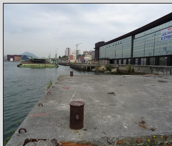
Planchada nº2. Vista hacia Getxo
