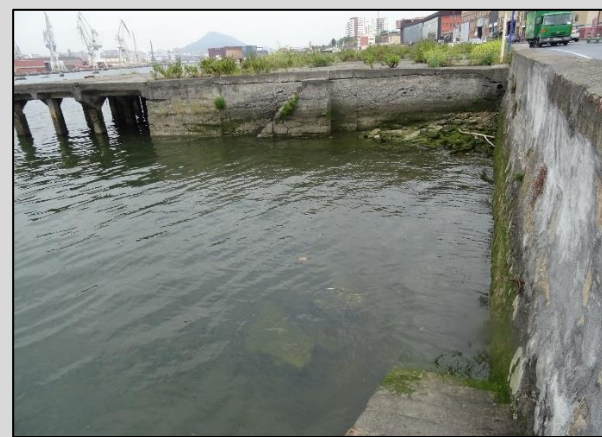
Planchada nº1. Vista hacia Getxo
