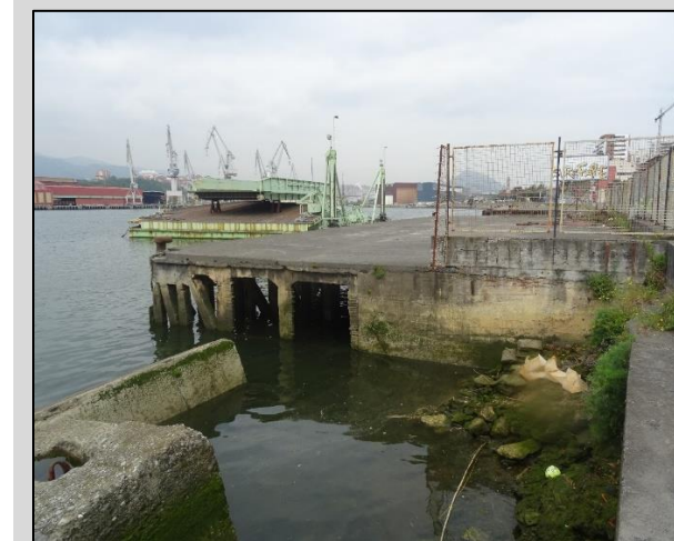
Planchada nº3. Vista hacia Getxo
