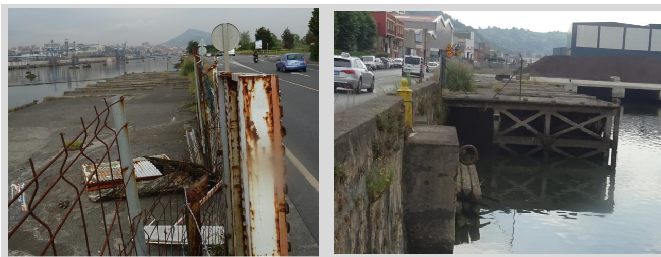
Planchada nº6. Vista hacia Getxo
