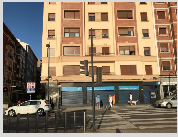
Paso de peatones elevado. San Ignacio Kalea
