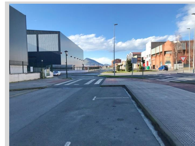
Vista de la vía de servicio de Navacel. Senda Acera Bici, aparcamiento y calzada unidireccional.
