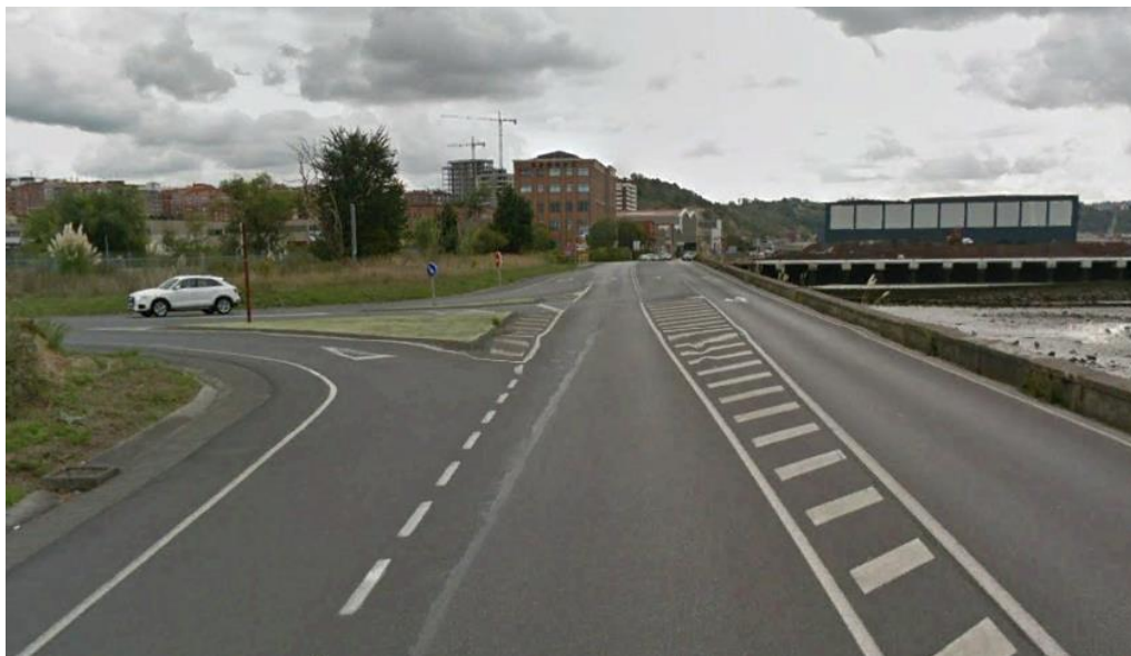
Acceso a Leioa por Felipe del Río. Vista sentido Bilbao
