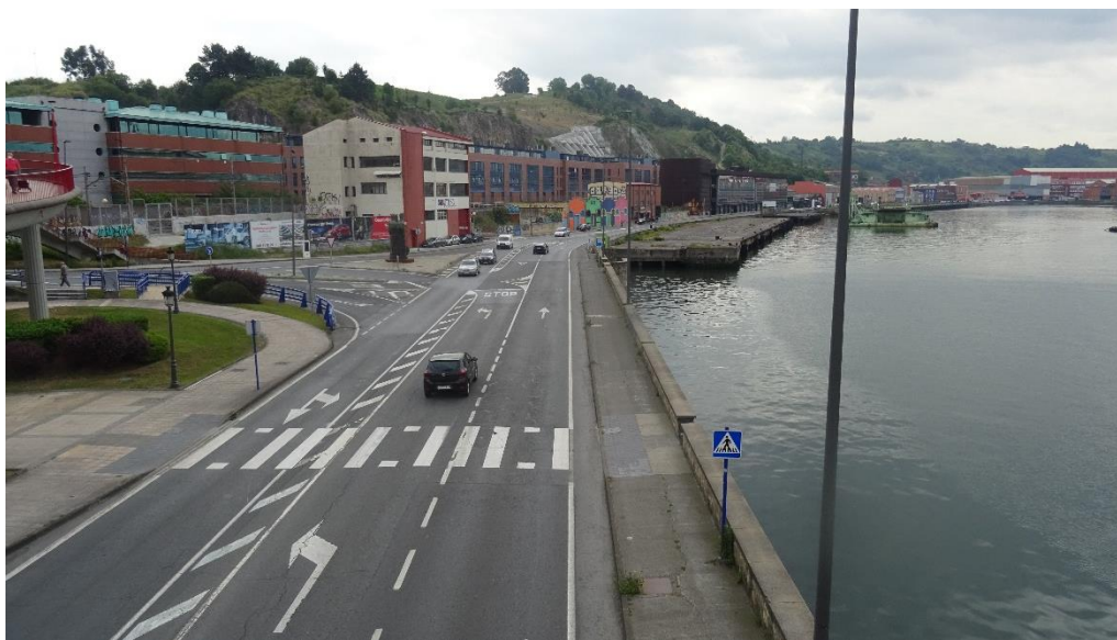
Acceso a Astrabudua. BI-747. Vista sentido Bilbao desde pasarela
