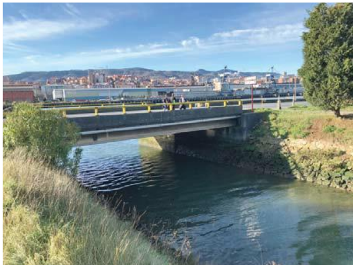
Ampliación de Puente de Urdondo. Ancho entre pretilos 14m.
