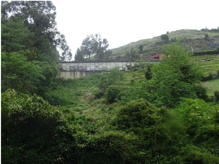
Imagen 7: Zona de pasarela. Vista del muro de Autovía desde calle Bullón (sudeste)
