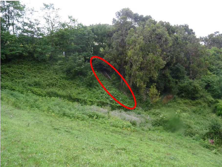
Imagen 9: Vaguada y bajante. Vista desde talud de la residencia
