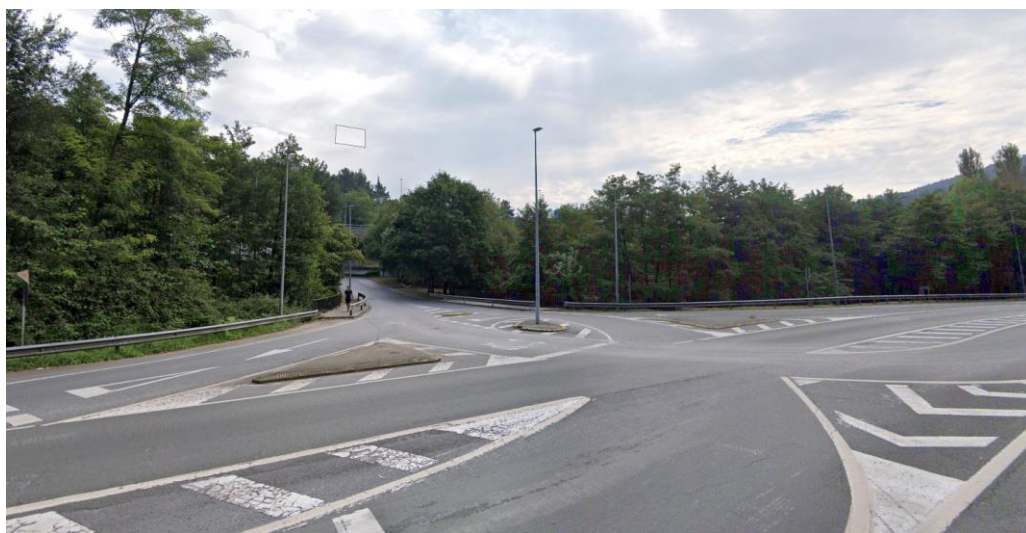
Intersección BI-737 acceso a Polígono Industrial
