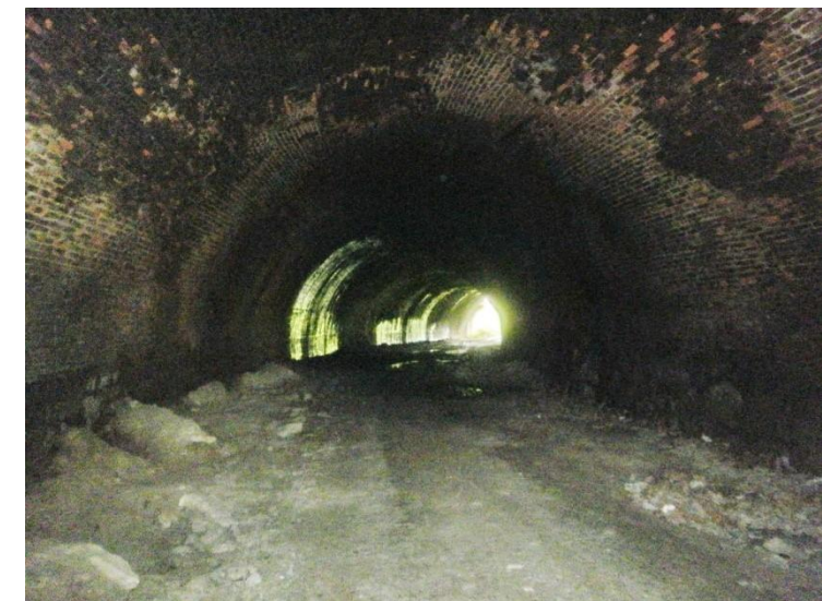
Imagen 9: Túnel del Boquete. Vista sentido Basauri
