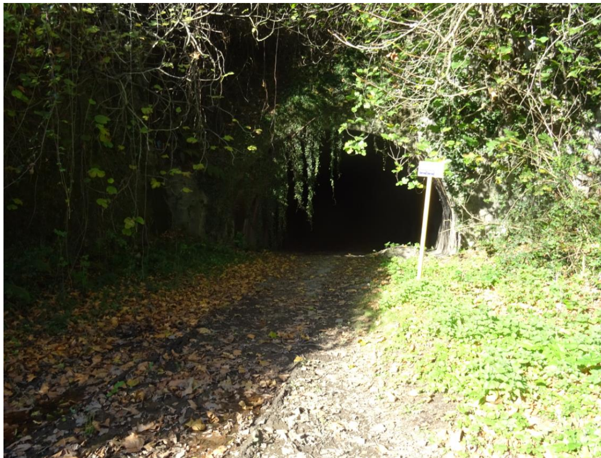
Boca sur del túnel (lado Basauri)
