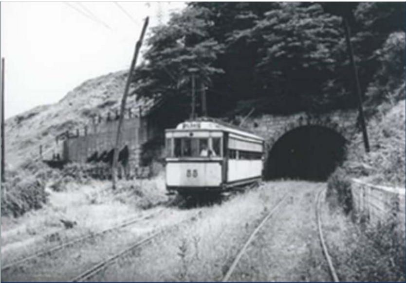
Imagen 4: Tranvía saliendo del túnel de El Boquete, en su boca sentido Bolueta
