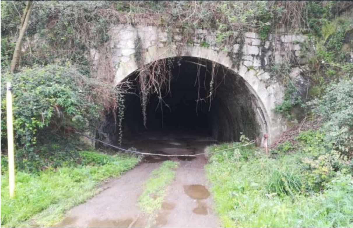
Imagen 23: Boca norte en buen estado. Túnel de El Boquete
