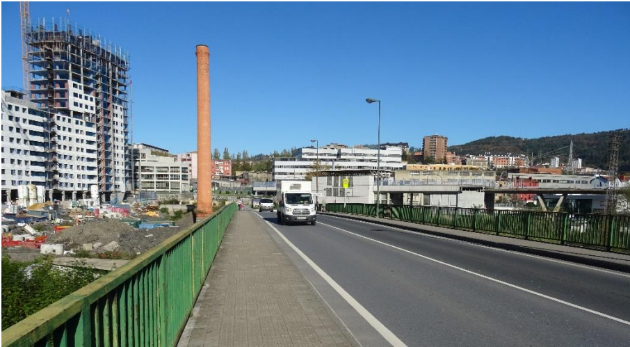
Imagen 13: Puente de Zubialde. Vista hacia Bolueta
