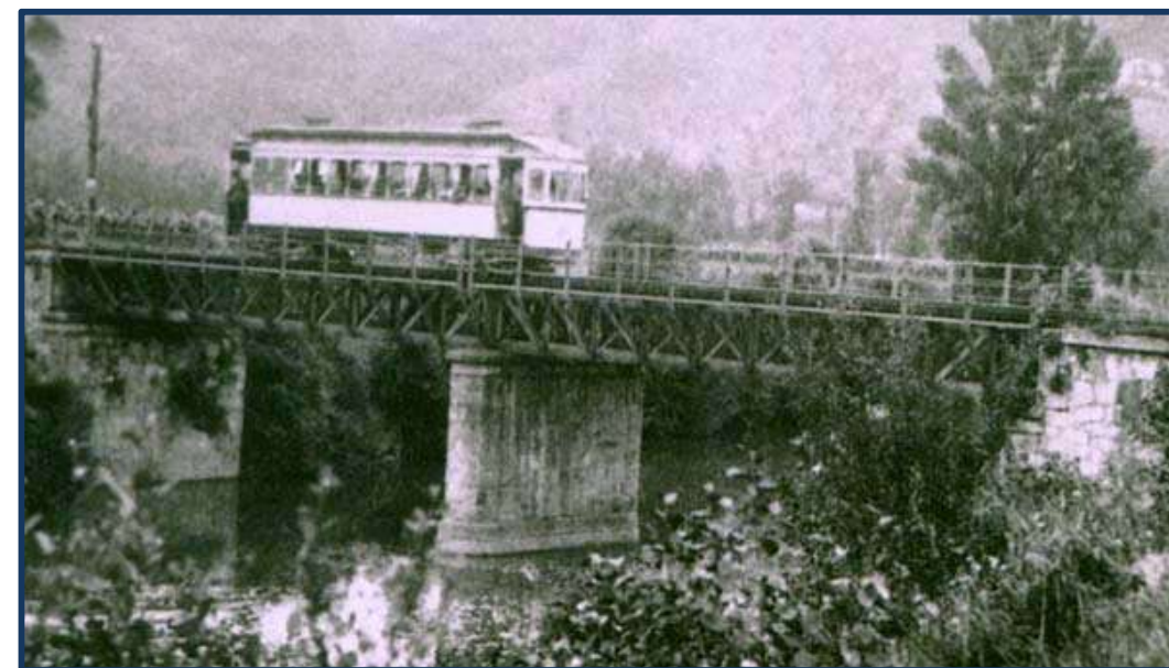
Tranvía de Arratia a su paso por el puente Urbi en Basauri.
