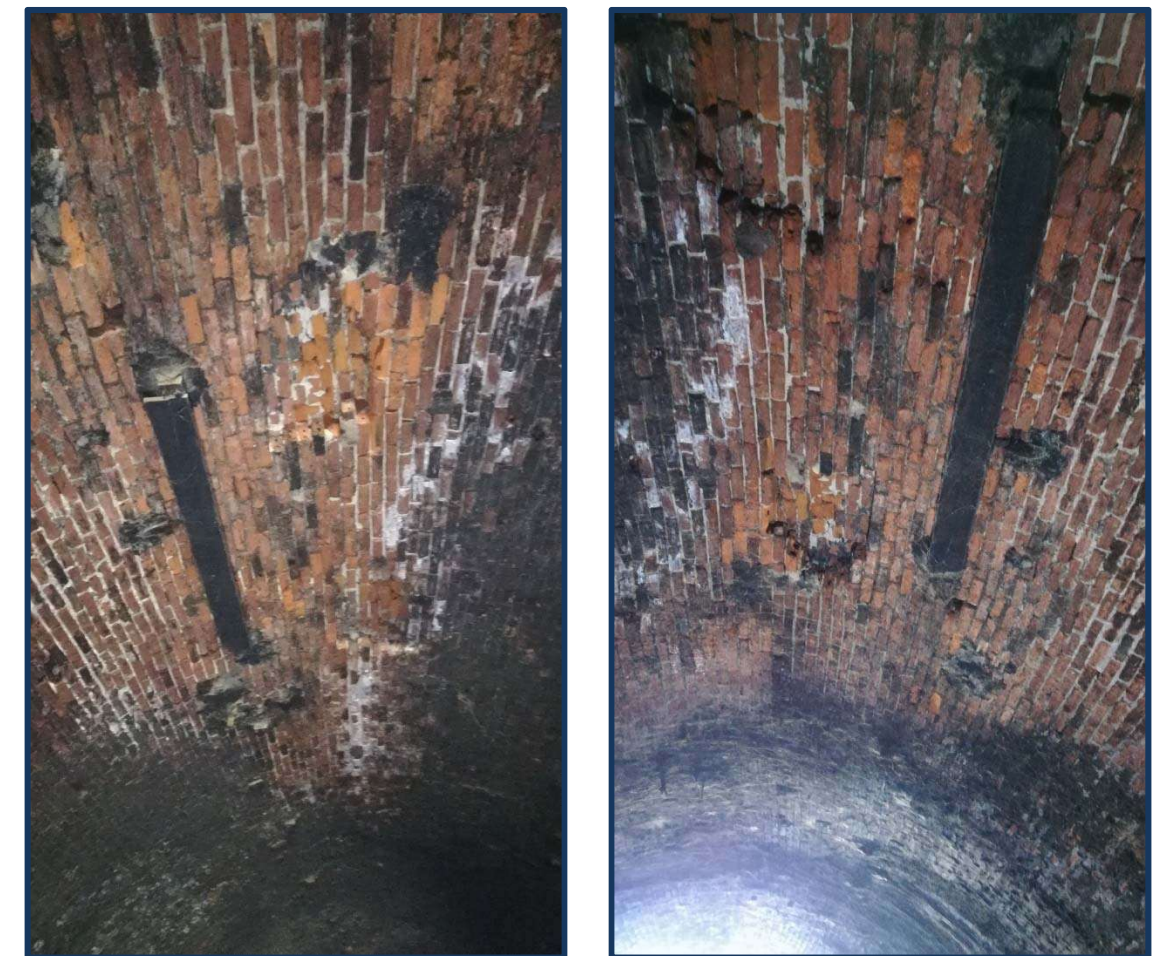
Restos de la antiguo sistema de donde colgaba la catenaria para cada uno de las dos vías.
