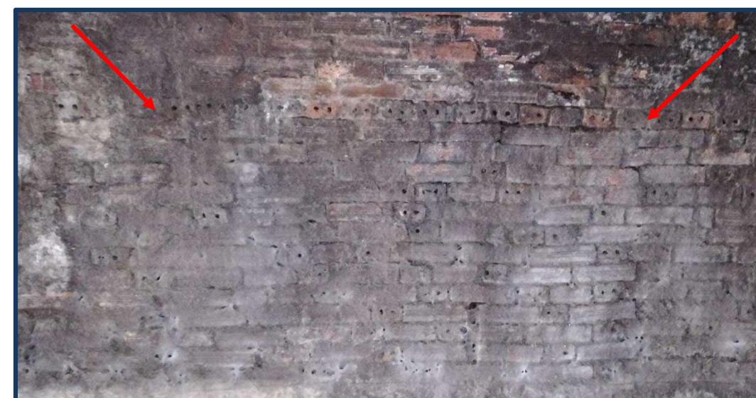
Aparejo a soga y tizón correspondiente a la parte inferior del revestimiento de ladrillos.
