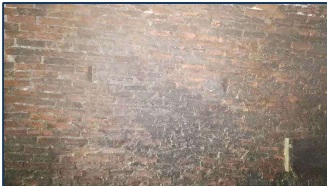
Mechinales sistemáticos en hastial del túnel.
