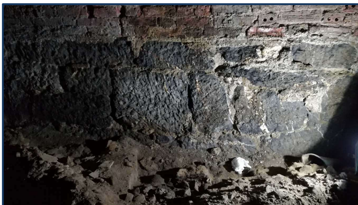
Diversas imágenes del zócalo de mampostería presente en la base de los hastiales del túnel.
