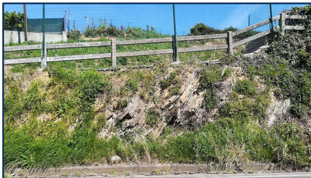
Nivel de margas y margocalizas tableadas en las cercanías del túnel de El Boquete.
