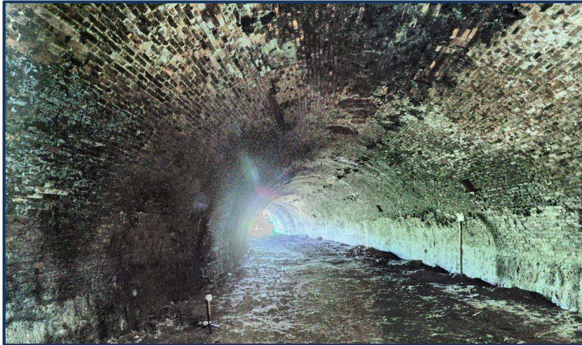
Vista de la clave del túnel donde podemos reconocer la línea de tacos de madera que servían de anclaje de la catenaria del tranvía para ambas direcciones.
