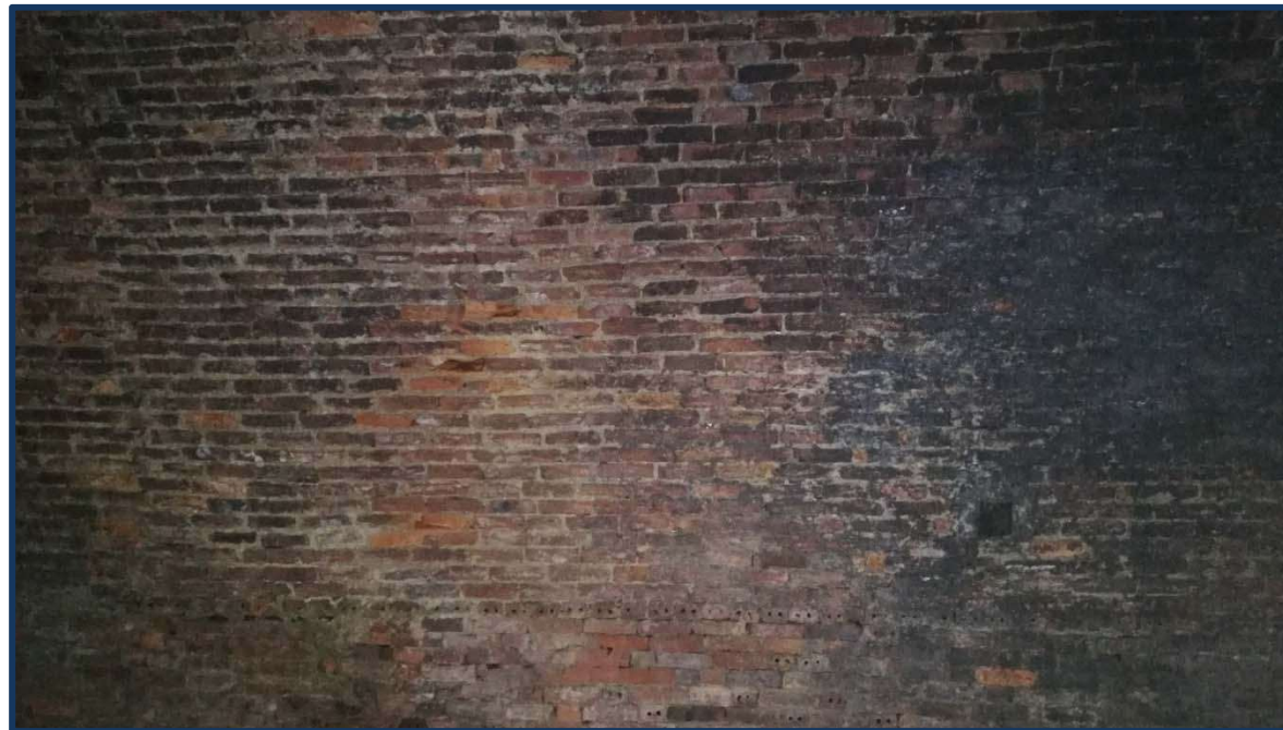
Aparejo a soga correspondiente a la clave del túnel.
