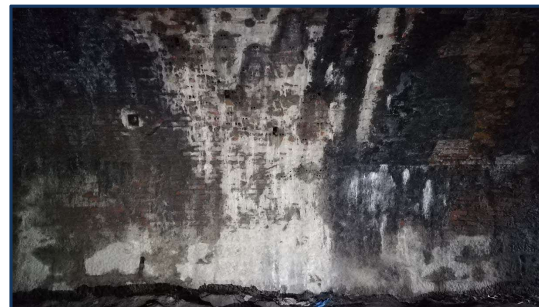
Precipitados de carbonato cálcico en la zona de la boquilla este, lado Basauri.
