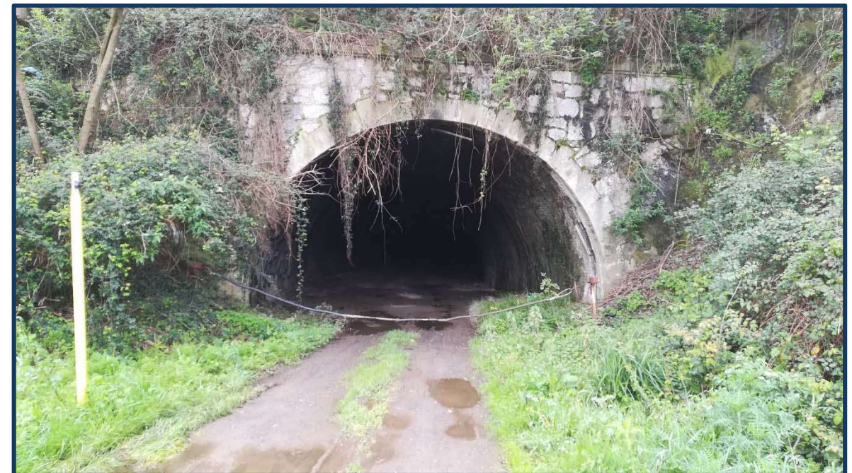
Boca este del túnel, lado Bolueta.
