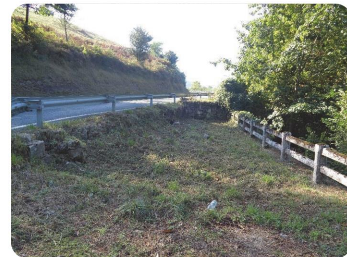
49+400 Muro en MI con sobreancho
