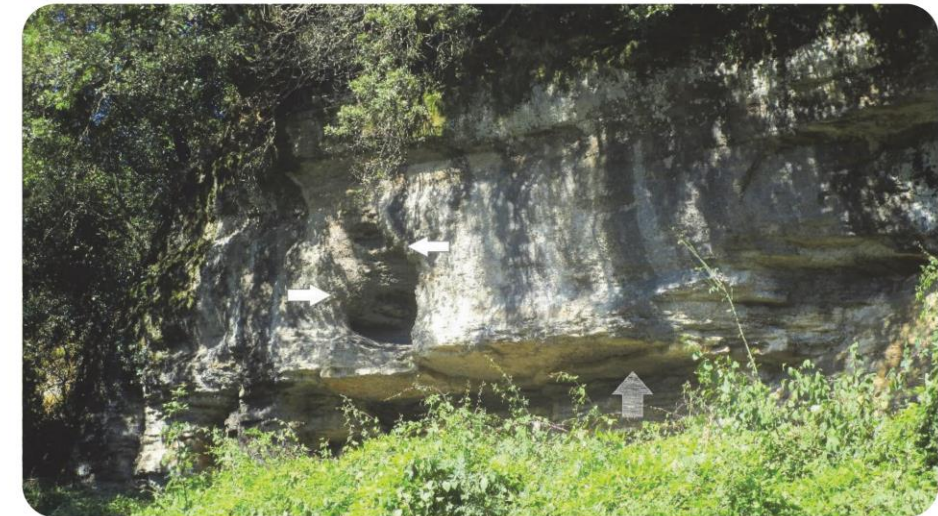
50+700 Resaltes en Voladizo con karstificaciones
