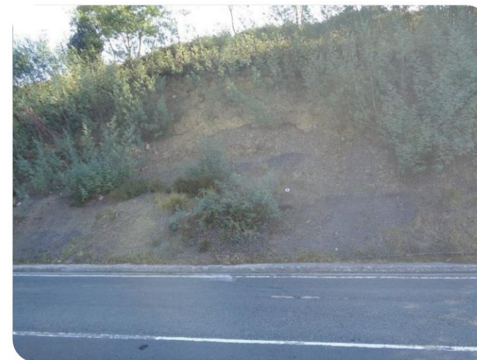
49+300 Desmonte en MD con malla
