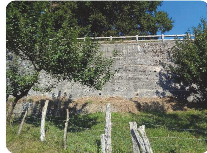
50+660 Muro de hormigon en MI -2
