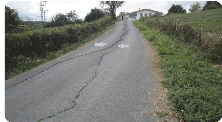
53+800 Zona Coluvial inestable-Vial Acceso a Manzaneda
