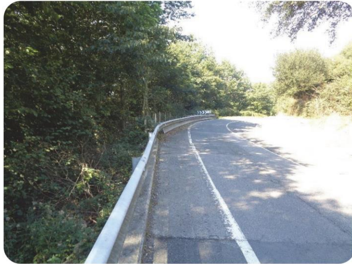
49+750 Fin de muro en MI 49+700 muro en MD
