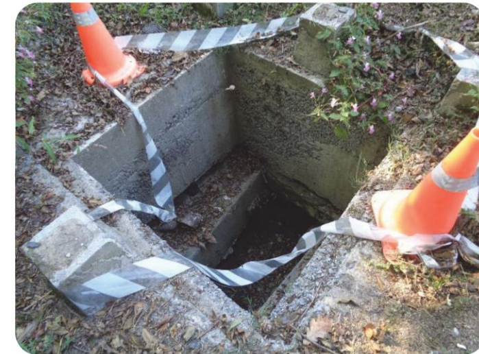
51+800 Arqueta en vaguada MD
