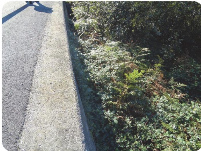
49+200 Detalle de muro
