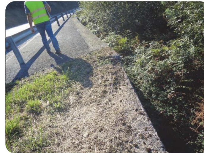
49+200 Muros en MI
