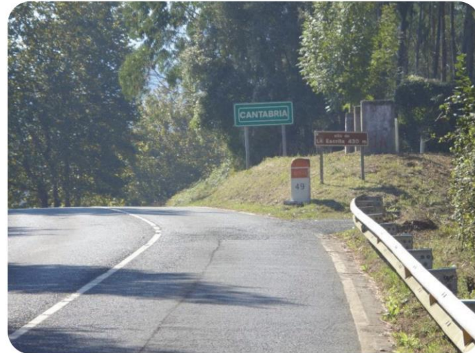
49+000 Inicio de tramo Alto de La Escrita
