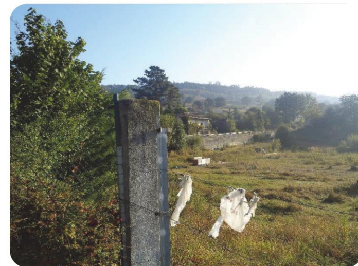
52 Muro de contencion MI
