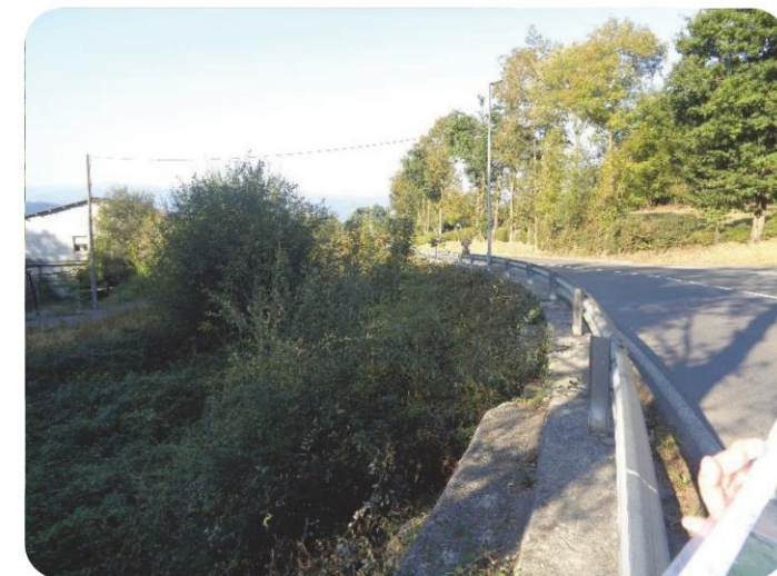
51+900 Muro en MI
