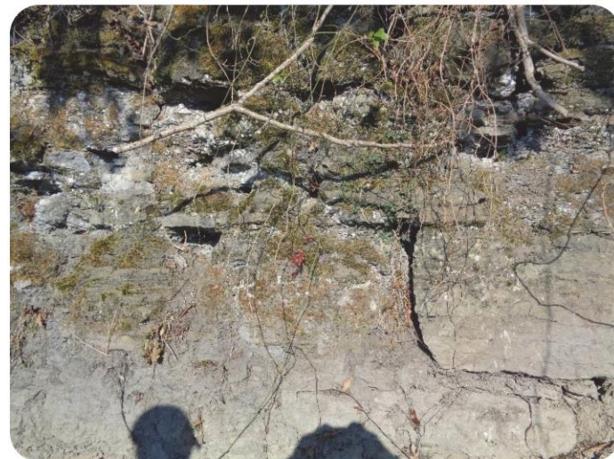
50+750 Detalle muro mamposteria MI-1
