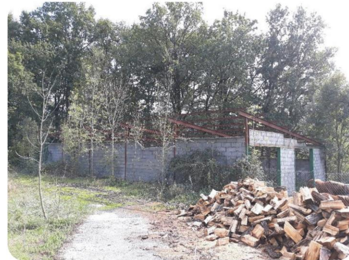
51+800 Ruinas lado derecho
