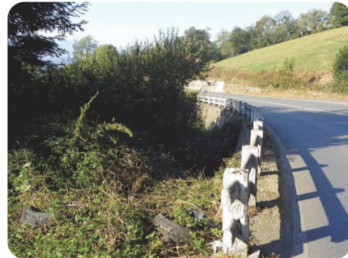
51+050 Vista hacia PK+ muro en MI
