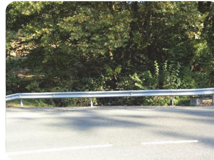
51+050 Proteccion en MD de caño
