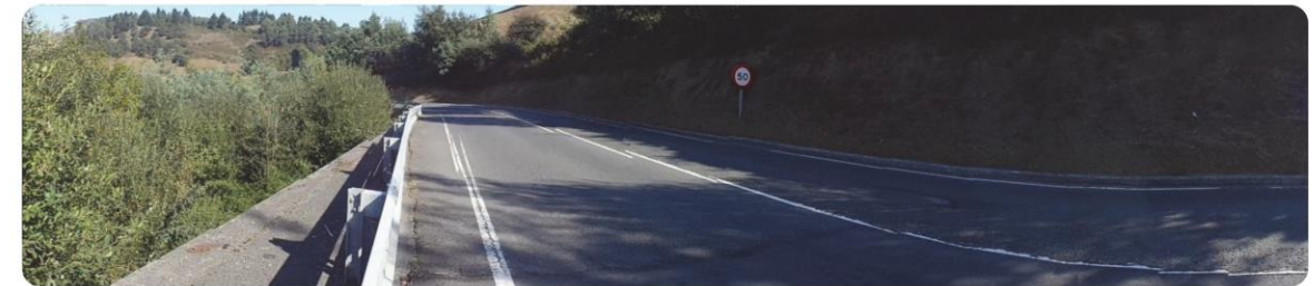
49+100 Vista desde PK + a PK -
