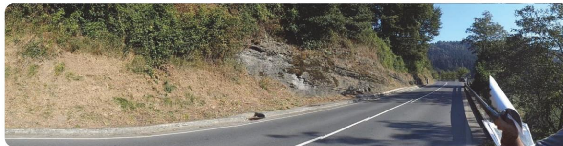
50+700 Vista hacia PK - zona instrumentada
