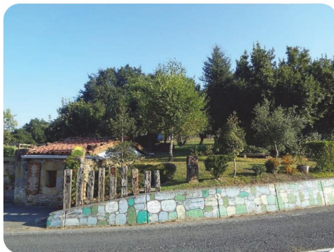
51+950 muro en MD
