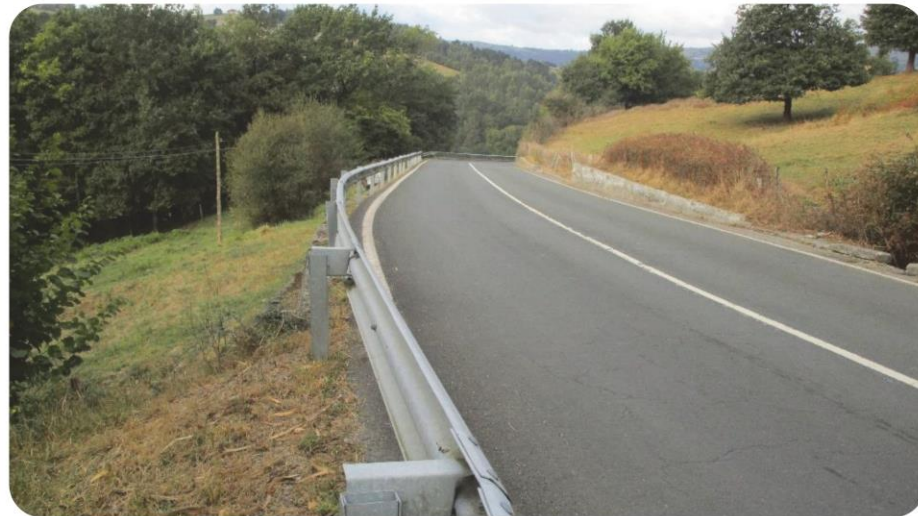
54+160-54+200 Muro Lado derecho
