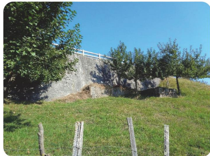
50+660 Muro de hormigon en MI -3
