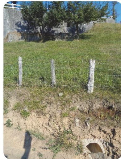
50+660 Muro de hormigon en MI -6
