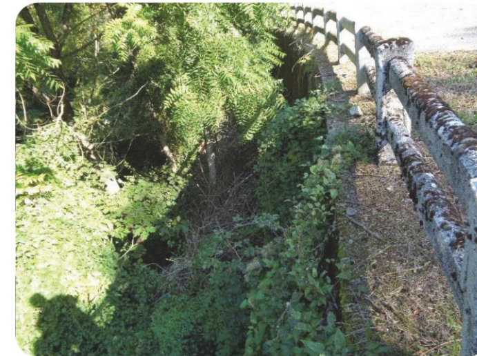
49+450 Muro en MI
