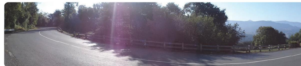
51+050 Vista desde PK - a PK +
