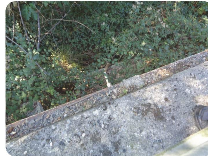
49+700 Muro en MI
