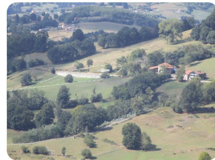
51+250 Vaguada con Coluvial y muro de contención
