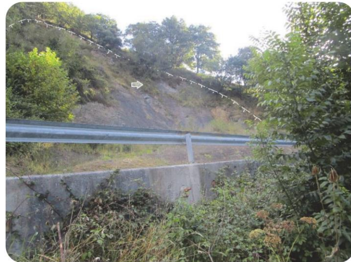
49+900 Antiguo Deslizamiento en roca- Muro anclado en pié
