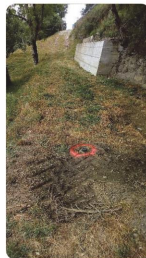
50+750 Muro reparado con tacón de hormigón SM-2
