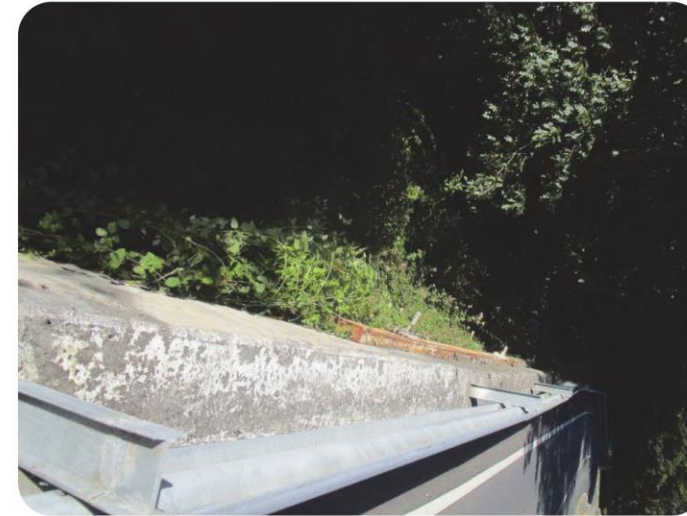
49+750 Muro Anclado Inestabilidad por pendientes
