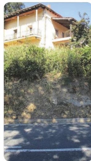
51+100 Punto de observacion de la roca 27. Vivienda proxima
