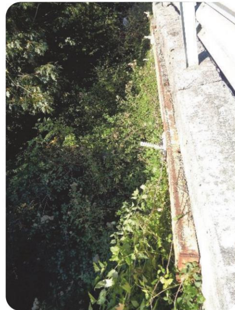
49+700 Muro en MI
