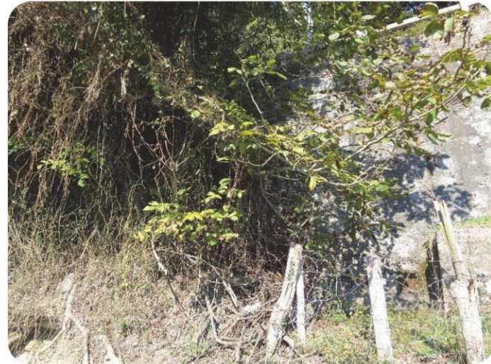
50+660 Muro de hormigon en MI -1
