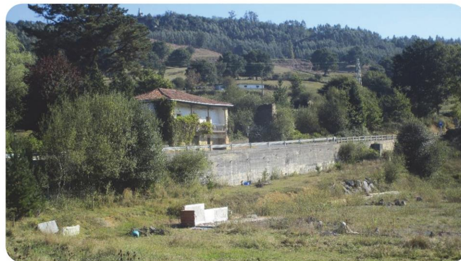
52+500 Casa de las picas-Oeste Gran zona coluvial- Muro anclado
