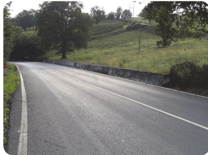
53+700-53+800 Muro sostenimiento acceso a Manzanedo de Biañez
