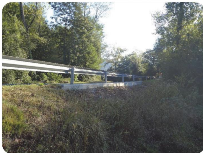
51+050 Vista de muro en MI hacia PK - (Hito 51)
