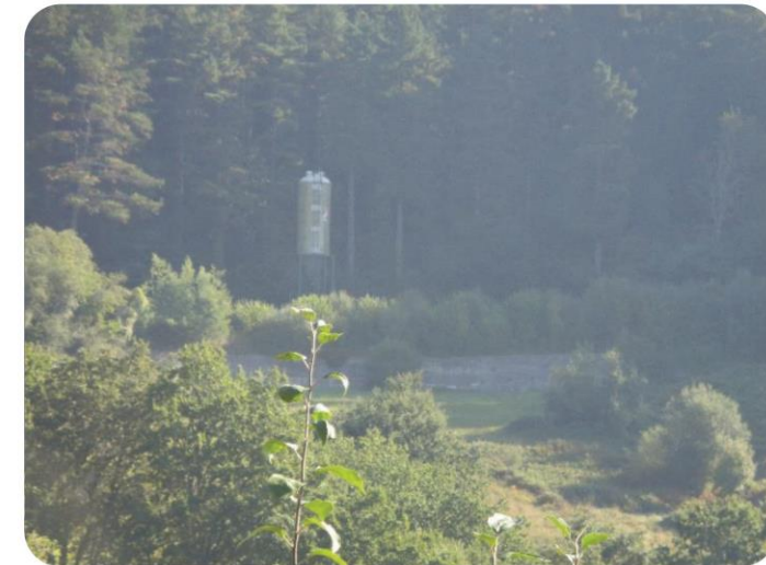
50+100 Vista del muro en MI situado en el 50+150
