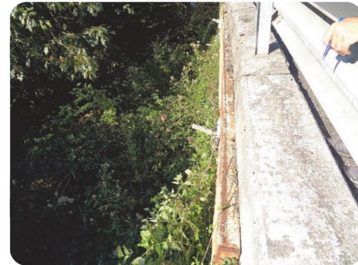
49+700 Refuerzo con anclajes del muro 49+700
