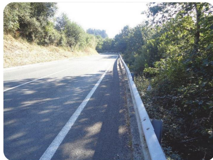
49+700 Vista del muro en MI hacia PK -
