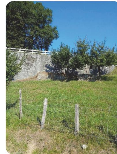
50+660 Muro de hormigon en MI -7
