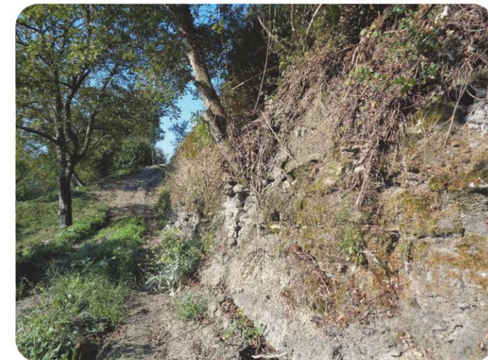
50+750 Detalle muro mamposteria MI-2
