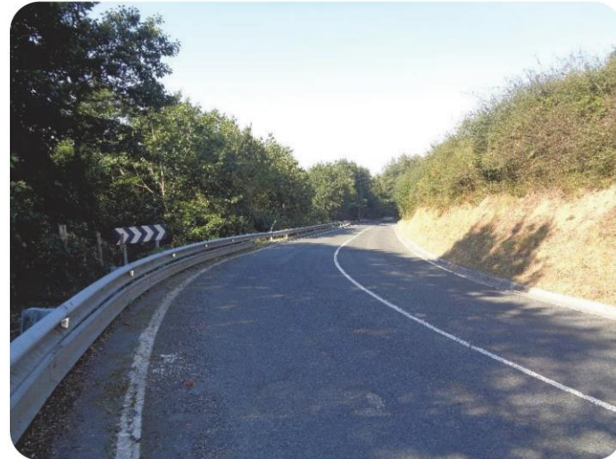
49+620 Vista hacia PK + muro en MI
