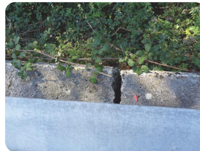
49+700 Muro en MI
