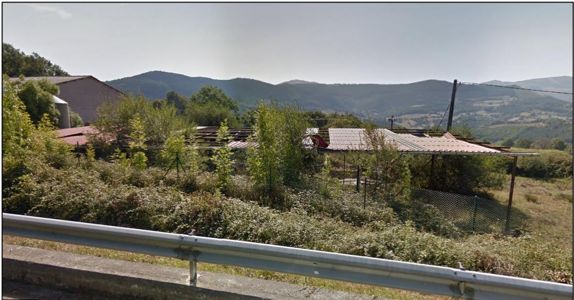
Una esquina, afectada por la reposición de un camino a la altura del PK 3+600 (estribo E2 del viaducto 3.5). Lo afectado no tiene cubierta. Plataforma de hormigón invadida por la vegetación.
