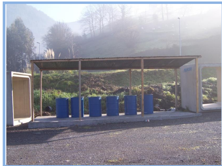
Ilustración 2: Punto limpio en construcción.
