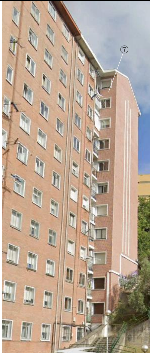
Edificio 3 Bloque izquierda 2. Fachada 7
