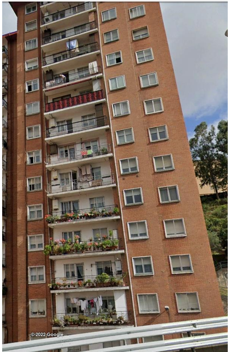
Edificio 3 Bloque izquierda 2. Fachada 3
