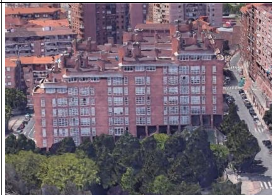
Edificio 1 Fachada B
