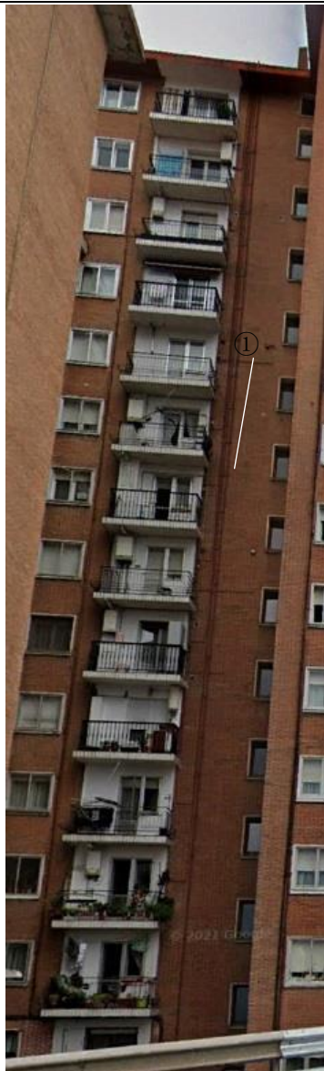
Edificio 3 Bloque izquierda 2. Fachada 1
