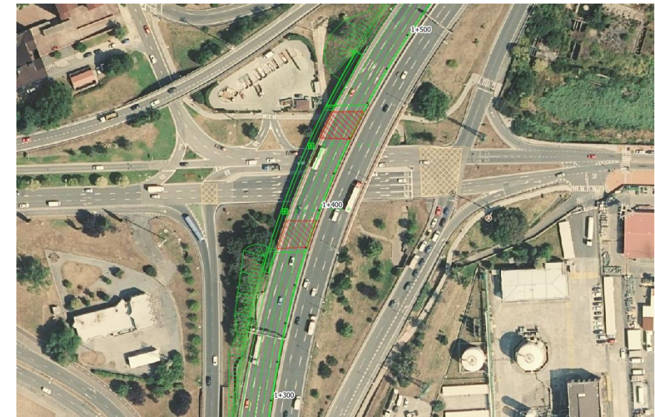
Imagen 39: Zona de acopio de tierras y Punto limpio.
